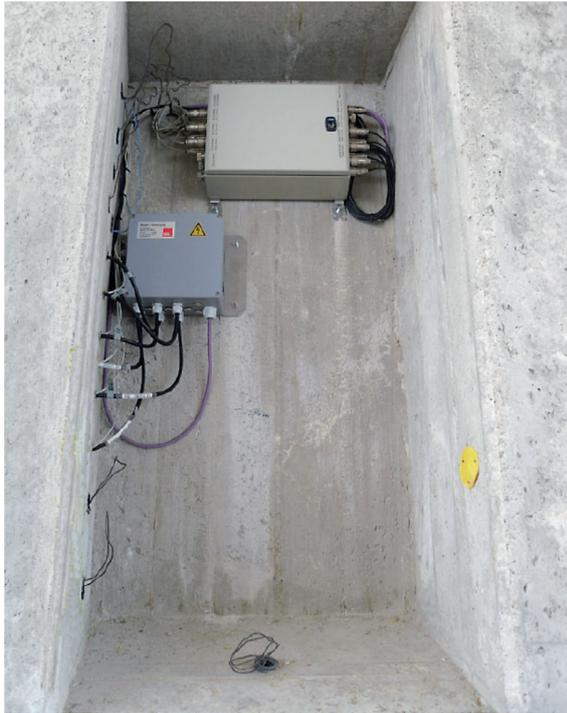
**Bild 104: Vorgesehene Nische für die Monitoringzentrale am Widerlager an der Seitenhafenbrücke in Wien (GEIER et al., 2014)**
