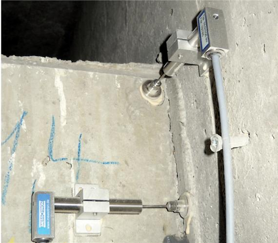
**Bild 50: Montage von Wegaufnehmern hinter dem Endverankerungsblock (BOROS et al., 2016)**
