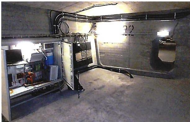
**Bild 8: Messzentrale im Inneren des Hohlkastens der Köhlbrandbrücke (ULLERICH 2012)**
