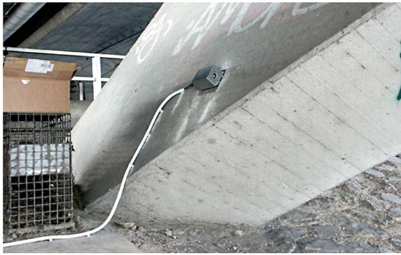
**Bild 47:** Installation eines laseroptischen Sensors an den Kämpfern einer Bogenbrücke in Massivbauweise (GEIER and BINDER, 2009)
