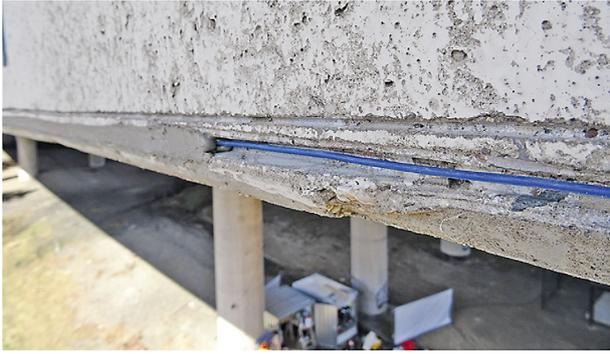
**Bild 100: Installationsmöglichkeit in einer Nut nahe der Stegunterkante (NOVÁK et al., 2021)**
