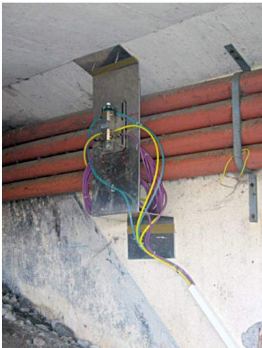
**Bild 38: Montage einer elektronischen Schlauchwaage (REITERER et al., 2008)**
