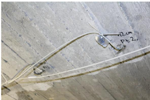
**Bild 17: Montage eines Temperatursensors zur Erfassung der Bauteiltemperatur (WEIHER et al., 2015)**
