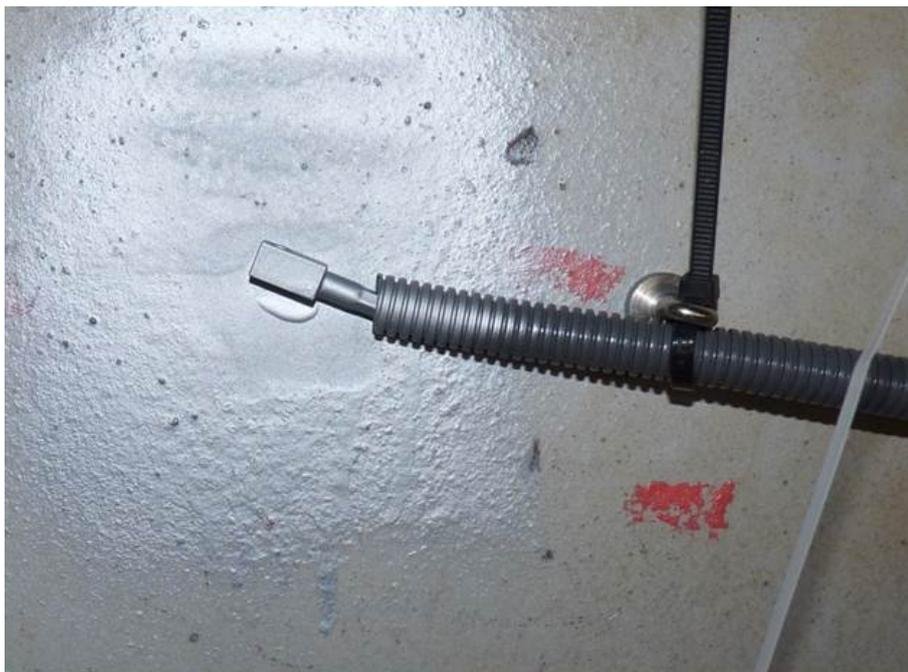
Bild 4: Temperaturmessstelle, Quelle: KBauMV
