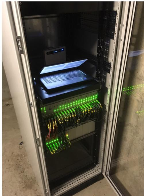
Bild 3: Messzentrale, Quelle: Bilfinger Noell GmbH
