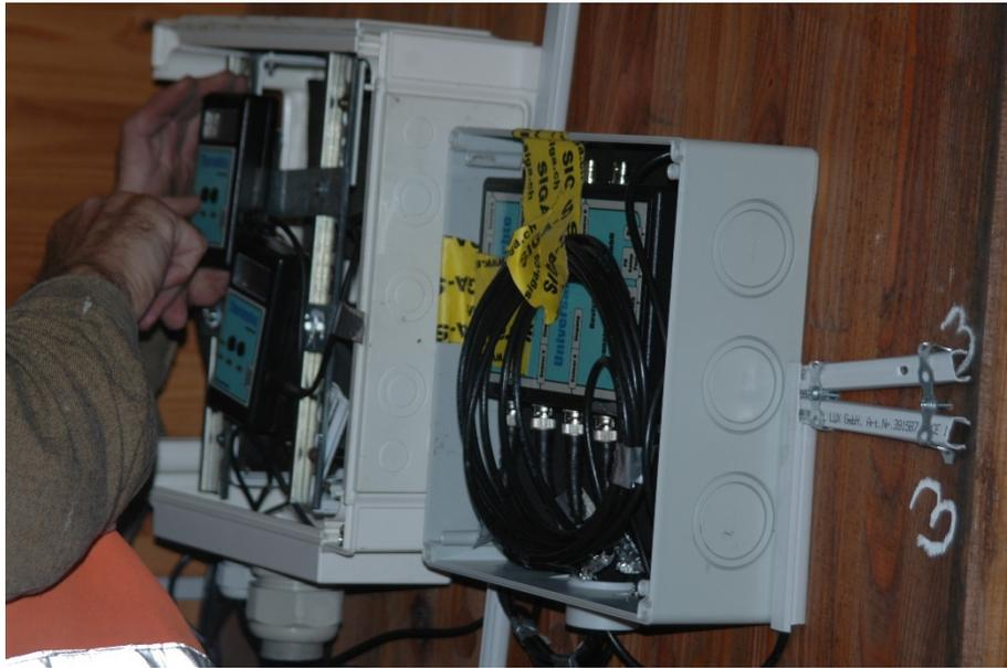
Bild 3: Messkasten mit Datenlogger und Widerstandsmessmodul, Quelle: KBauMV FH Wismar
