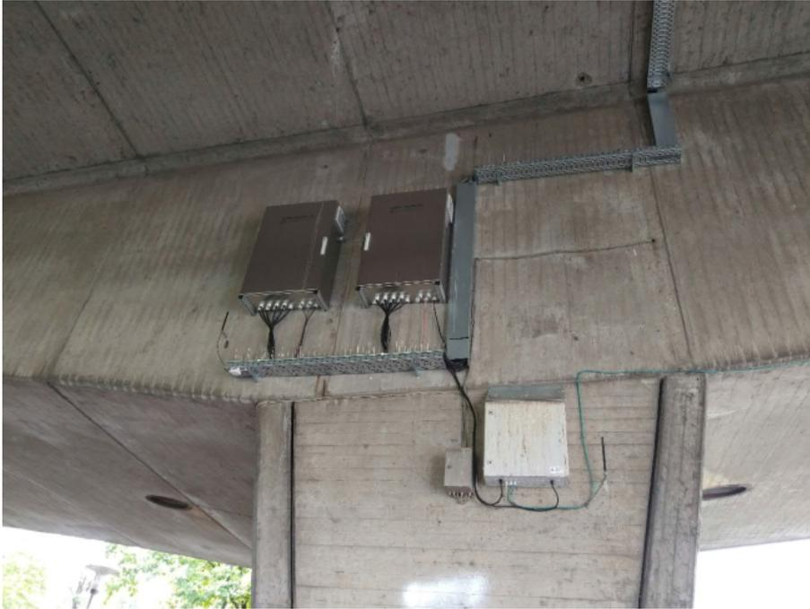
Bild 3: Schaltschränke (oben) des Schallemissionssystems,
