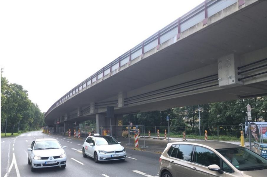
Bild 1: Ansicht des verstärkten Bauwerks, Quelle: Niedersächsische Landesbehörde für Straßenbau und Verkehr
