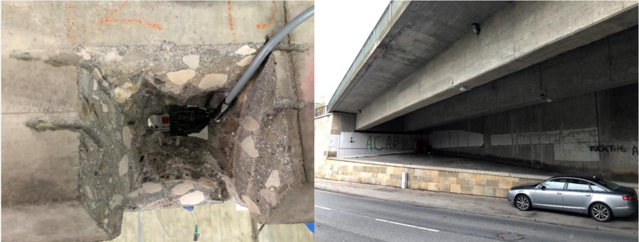
Bild 1: Messstelle zur Erfassung der Betonstahl-Längsdehnung (DMS) während der Installation (li), Bauwerksansicht (re), Quelle: Büro für Strukturmechanik GmbH
