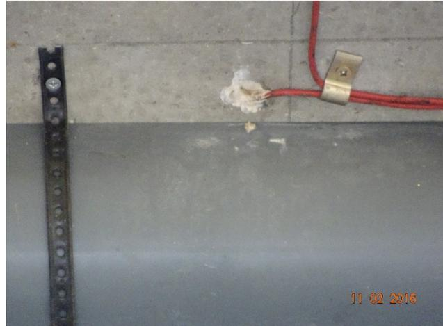
Bild 1: Installation und Schutzabdeckung der Sensorik an der Trägerunterkante in Feldmitte,
