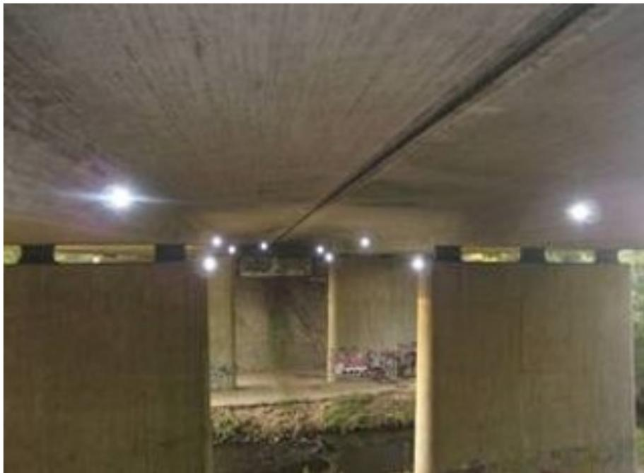
Bild 2: Messstellen und Installation der Messprismen, Quelle: Die Autobahn GmbH des Bundes, Niederlassung Nordwest
