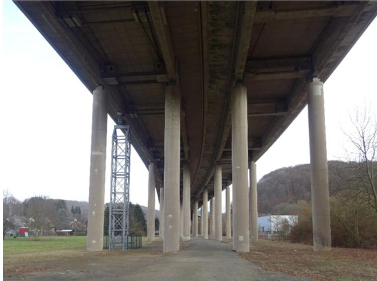
Bild 2: Ansicht Talbrücke und Notunterstützung, Quelle: ILEK, Universität Stuttgart
