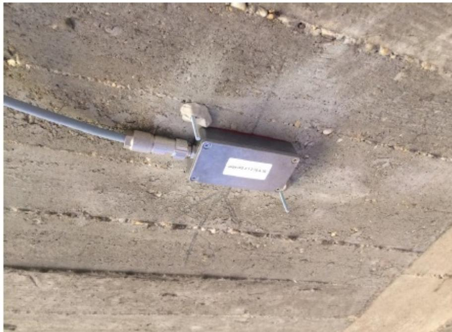
Bild 2: Sensorinstallation an der Unterkante, Quelle: iNDTact GmbH
