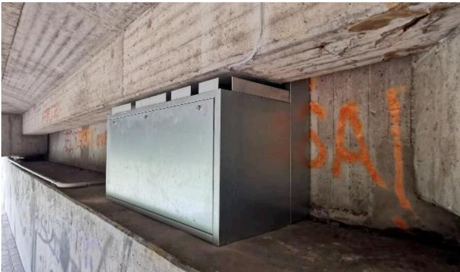
Bild 10: Ansicht der Messzentrale, Quelle: Lucks Technologies GmbH
