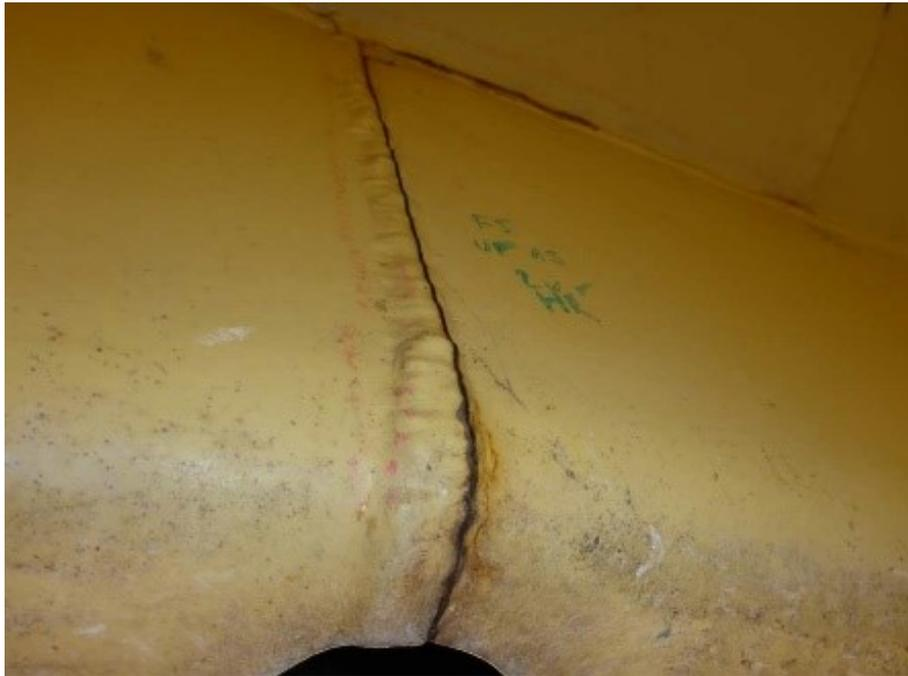
Bild 3: Ermüdungsschaden (vor der Instandsetzung), Quelle: Die Autobahn GmbH des Bundes, Niederlassung Nordost
