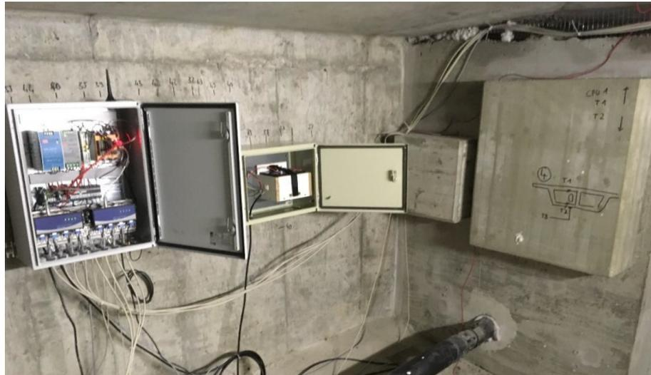
Bild 6: Messzentrale und Batteriekästen, Quelle: Lucks Technologies GmbH
