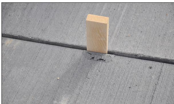
Bild 3-16: Abplatzung am Plattenrand durch Holzkeil
