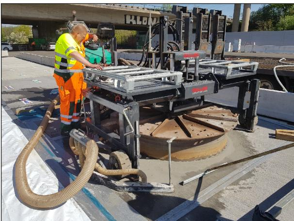
Bild 3-13: Bohren der Aussparung für rundes Fertigteil
