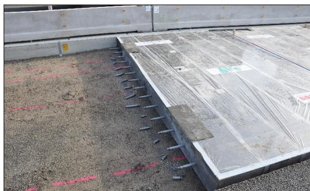
Bild 3-19: Abtrennen der Dübel
