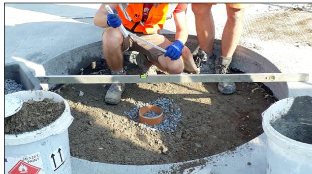
Bild 3-14: Entwässerungseinrichtung für rundes Fertigteil
