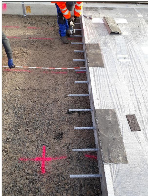
Bild 3-11: Kürzen eingebrachter Dübel
