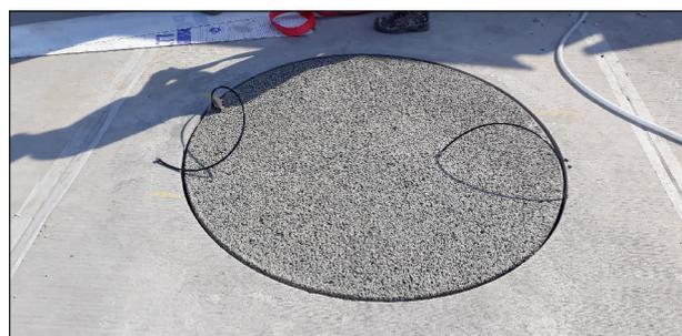
Bild 3-15: Eingesetztes rundes Fertigteil
