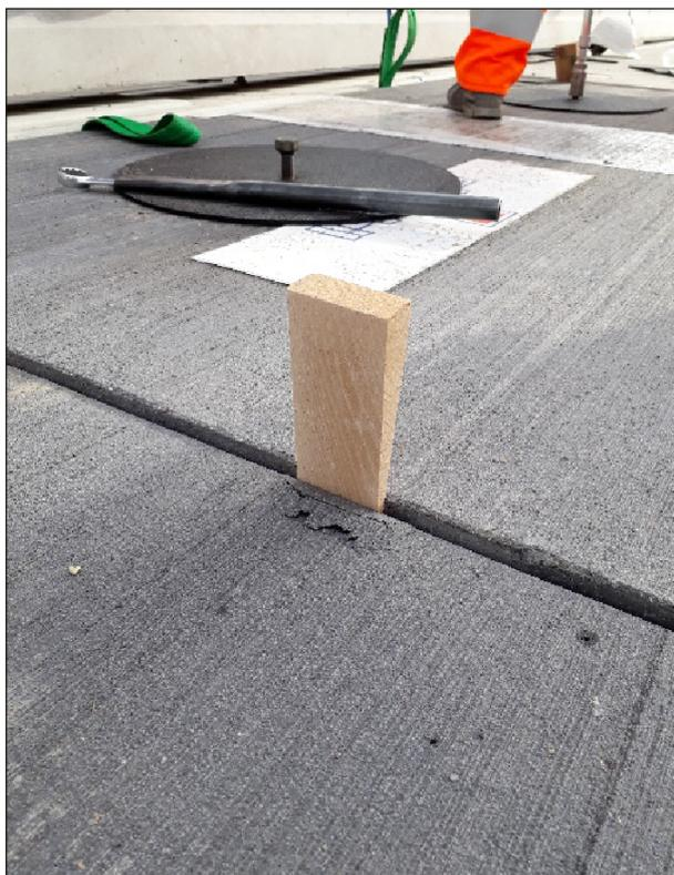
Bild 3-10: Beim Einbau abgeplatzte Betonkante
