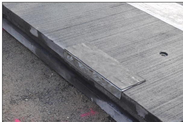
Bild 3-17: Metallprofil zum Kantenschutz
