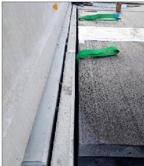
Bild 3-9: Gurtschlaufen nach Verlegung des Fertigteils
