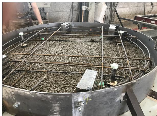
Bild 3-7: Herstellung rundes Fertigteil
