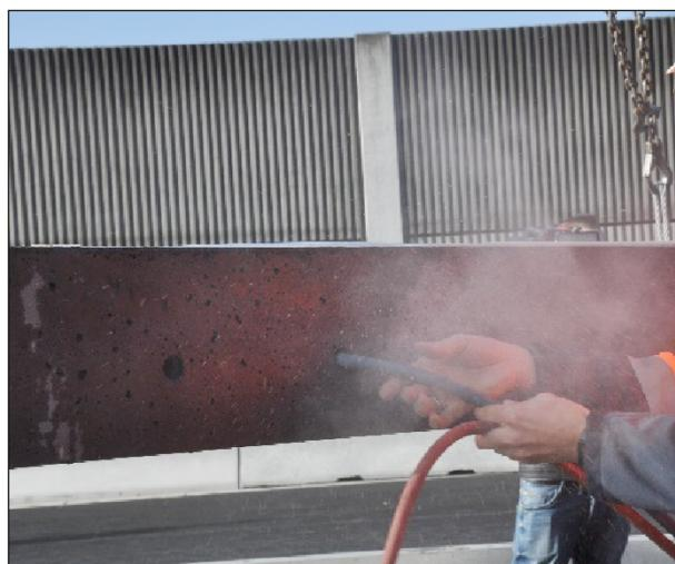
Bild 3-18: Säubern der Aussparungen für die Dübel
