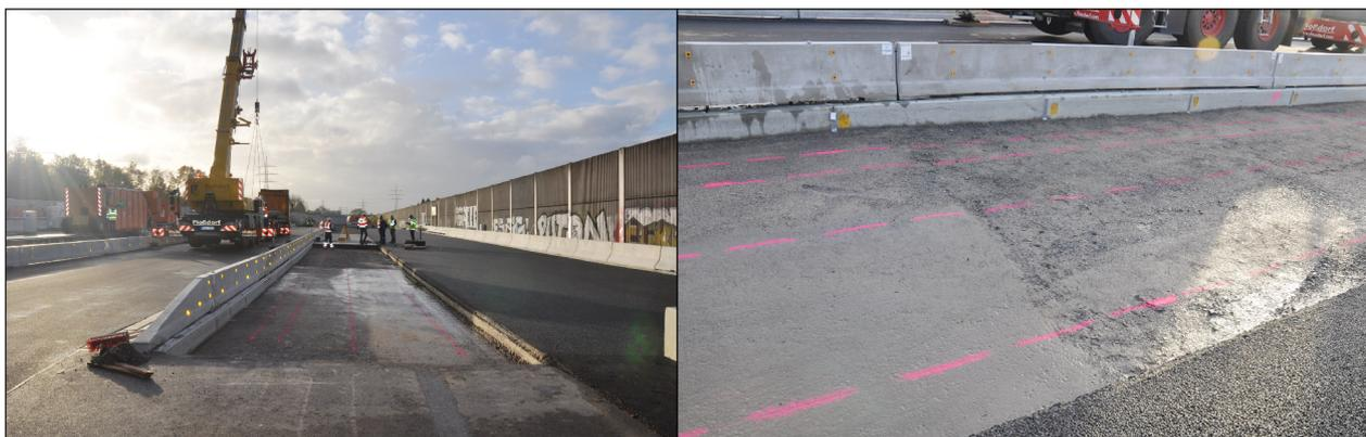
Bild 3-2: Vorbereitetes Baufeld mit Schotter- und Asphalttragschicht
