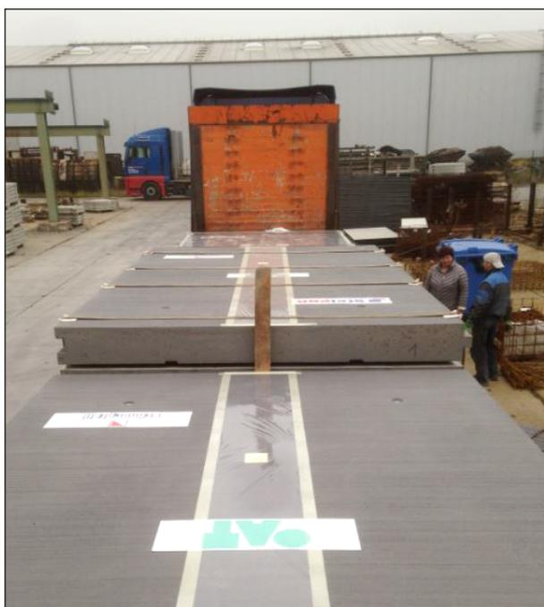
Bild 3-8: Auf Lkw verladene Fertigteile
