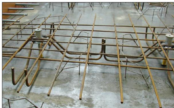
Bild 3-4: Bewehrung im Bereich der Transportanker
