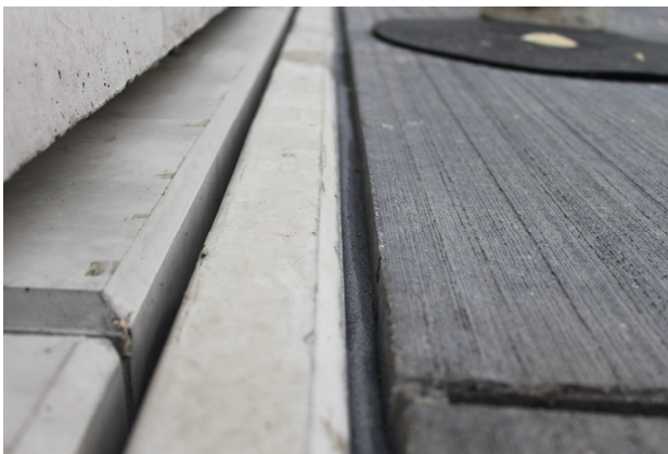
Bild A.88: Vorbereitete Kaltvergussfuge
