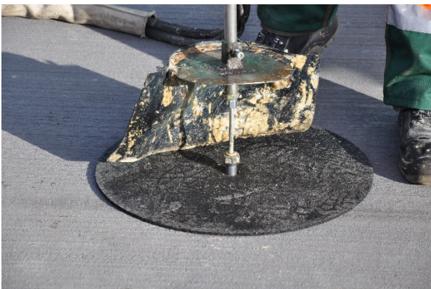
Bild A.82: Lanze im Höhenjustierelement JTU
