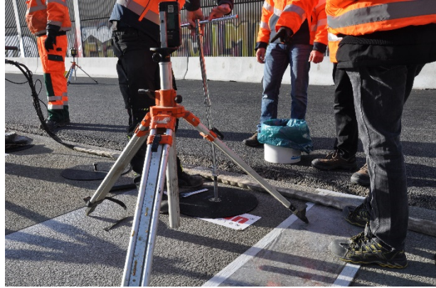
Bild A.56: Entlasten nach Unterfüllen der Platte (mit zeitlichem Abstand)
