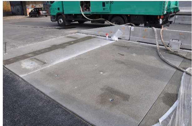
Bild A.64: Fertigteile 11 und 12 nach Unterfüllen und Entlastung
