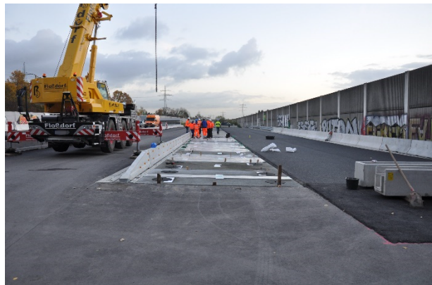
Bild A.48: Einbaustelle am Ende des ersten Einbautages
