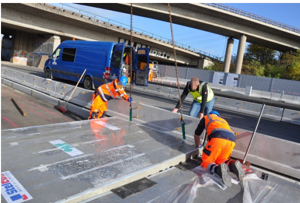
Bild A.21: erstes Einsetzen des Fertigteils 7
