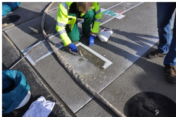
Bild A.60: Entfernen von Resten des Silikatharzes
