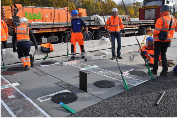
Bild A.31: Nachträgliches Anpassen der Lage des Fertigteils 1
