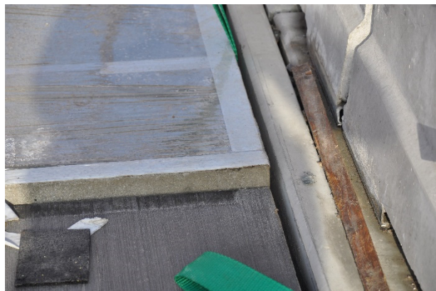
Bild A.22: Höhenversatz nach Einsetzen von Platte 7
