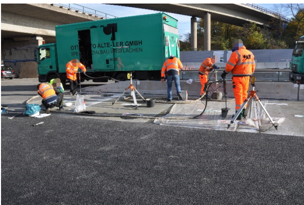
Bild A.59: Parallel laufende Arbeiten-Unterfüllen, Entlasten, Säubern
