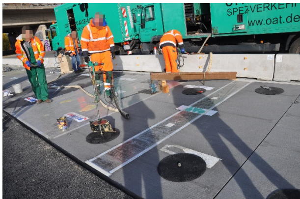
Bild A.83: Einbaustelle, Beginn des Unterpressen am Fertigteil 2
