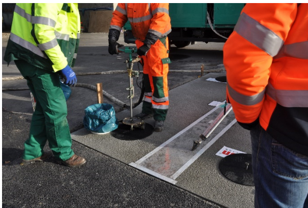
Bild A.51: Beginn des Unterfüllens bei Platte 12
