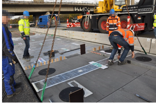
Bild A.32: Nachträgliches Anpassen der Lage des Fertigteils 2
