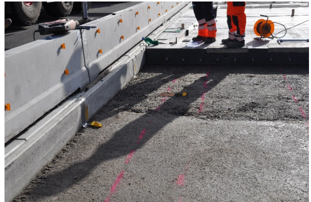
Bild A.28: Wechsel der Tragschicht
