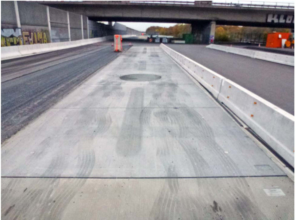
Abb. 2: Versuchsstrecke – Zustand am 8.11.2018
