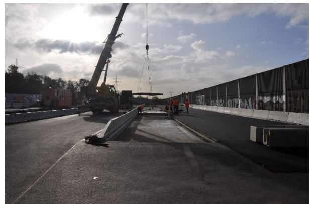
Bild A.16: Ansicht Einbaustelle
