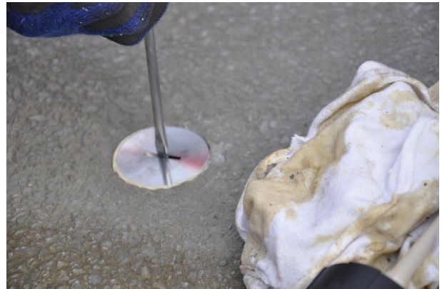
Bild A.75: Einkleben und Abdichten der Edelstahlverschraubungen
