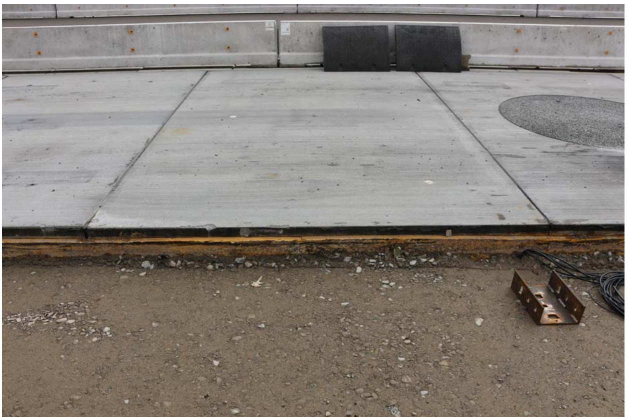
Abb. 6: belastetes Fertigteil 4 am 15.8.2019
