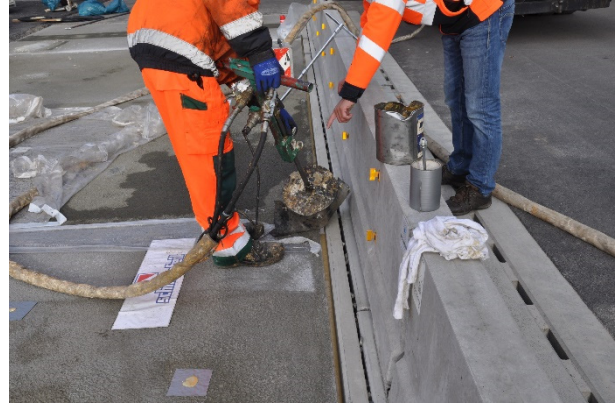
Bild A.62: Verfüllen im Randbereich zum Kabelschacht
