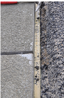
Bild A.71: Randbereich/Fuge zum angrenzenden OPA-Bereich
