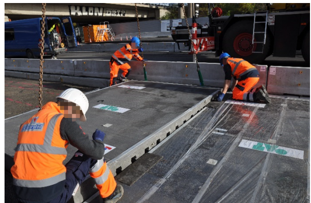
Bild A.18: Einsetzen von Fertigteil 5
