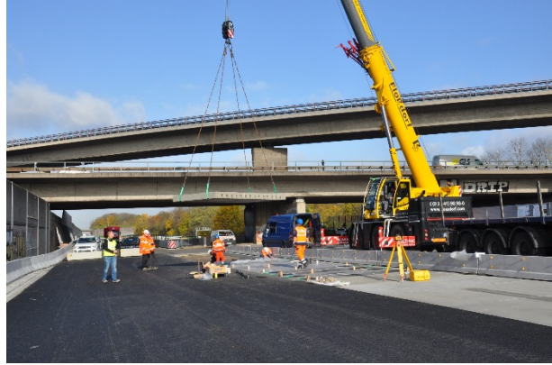
Bild A.20: Ansicht Einbaustelle
