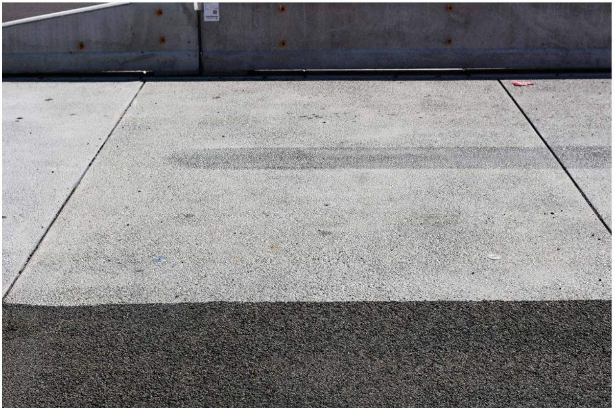
Abb. 13: belastetes Fertigteil 11 am 29.4.2019
