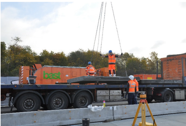
Bild A.9: Abladen des Fertigteils 3 (Dreipunktlagerung)
