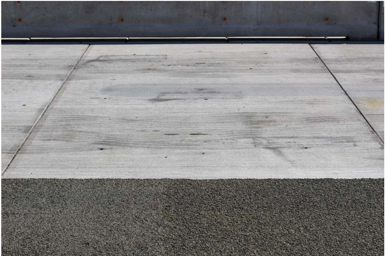
Abb. 7: belastetes Fertigteil 5 am 29.4.2019
