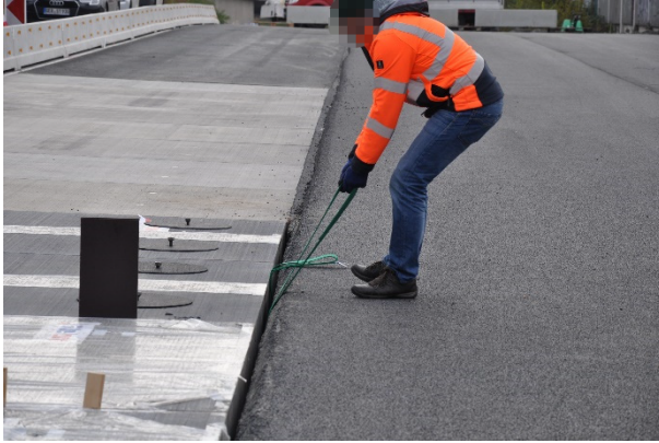
Bild A.72: Entfernen der Transportgurte (Herausziehen)
