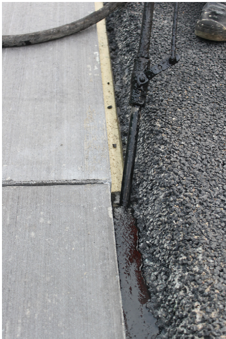
Bild A.86: Verguss der Fuge zum Asphalt
