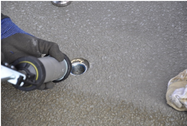
Bild A.74: Einkleben und Abdichten der Edelstahlverschraubungen
