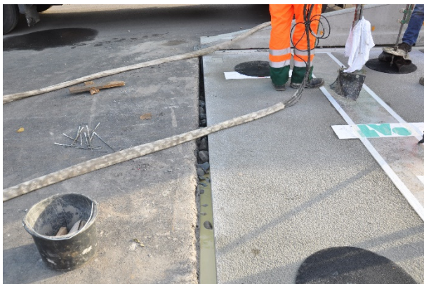
Bild A.53: Auffüllen des Restspalts mit Steinen
