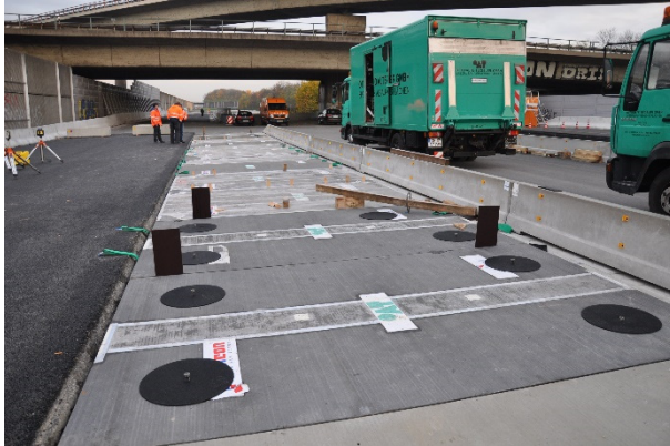
Bild A.49: Einbaustelle vor Beginn der Arbeiten am 14.11.2017
