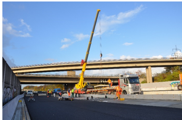
Bild A.36: Ansicht Einbaustelle
