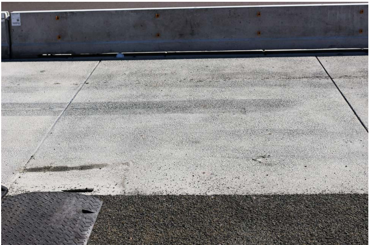
Abb. 10: belastetes Fertigteil 8 am 29.4.2019
