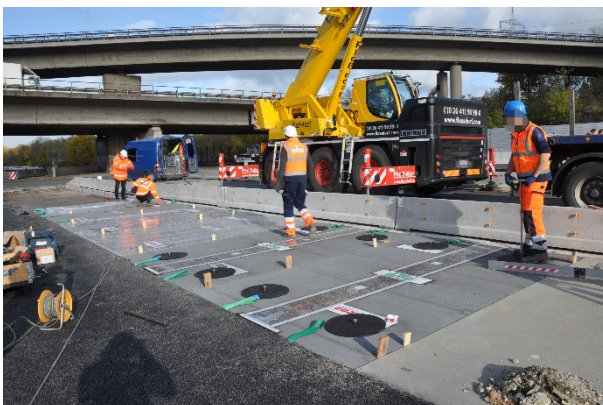
Bild A.29: Einbaustelle mit 6 eingesetzten Fertigteilen
