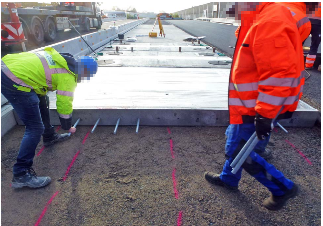
Abb. 4: Dübeleinbau am 13.11.2017
