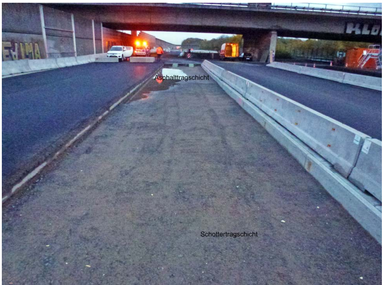
Abb. 2: Versuchsstrecke Schottertragschicht und Asphalttragschicht – Zustand am 13.11.2017
