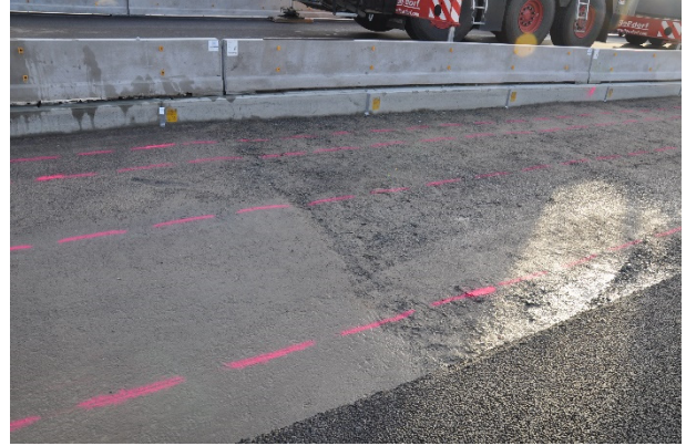
Bild A.2: Markierung für Unterlegplatten der Höhenjustierelemente
