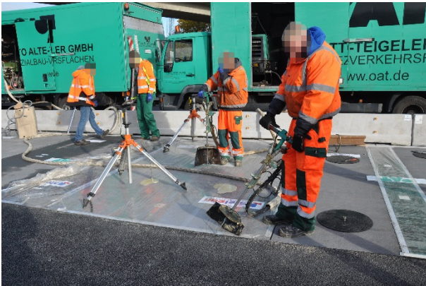
Bild A.80: Unterpressen und Höhenkontrolle
