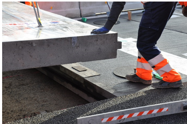
Bild A.12: Einsetzen des Fertigteils 3
