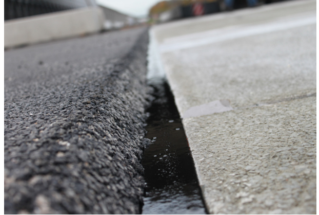
Bild A.85: Vergossene Fuge an Asphalt
