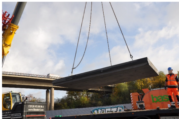
Bild A.10: Abladen des Fertigteils 3 (Dreipunktlagerung)
