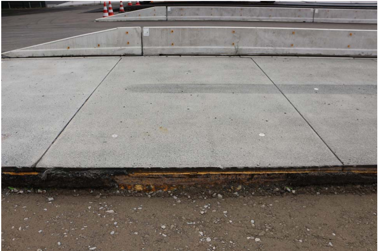
Abb. 13: belastetes Fertigteil 11 am 15.8.2019
