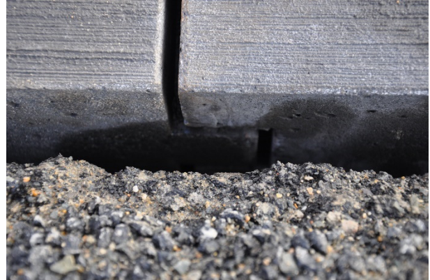
Bild A.14: Nut-Feder-System zwischen Fertigteil 2 und 3
