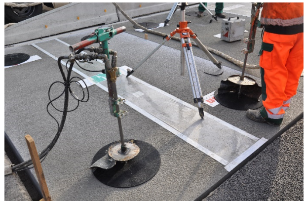
Bild A.52: Unterfüllen mit zwei Lanzen gleichzeitig
