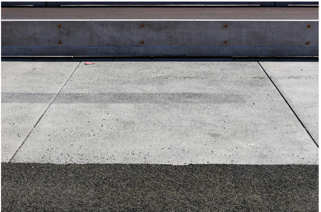
Abb. 12: belastetes Fertigteil 10 am 29.4.2019
