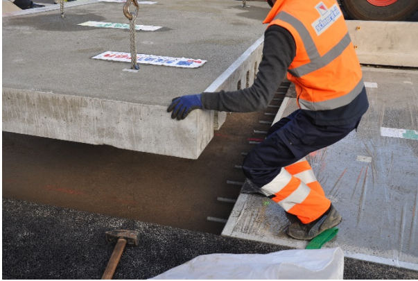
Bild A.37: Einsetzen von Fertigteil 9
