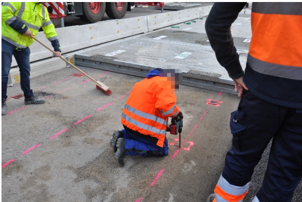
Bild A.41: Aufstemmen der Tragschicht für Unterlegplatten unter Fertigteil 11
