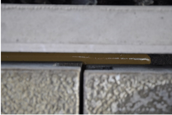
Bild A.61: Randbereich mit Nut-Nut-Anker und aufsteigendem Silikatharz
