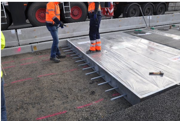
Bild A.15: Einsetzen der Dübel in die Aussparungen am Fertigteil 3
