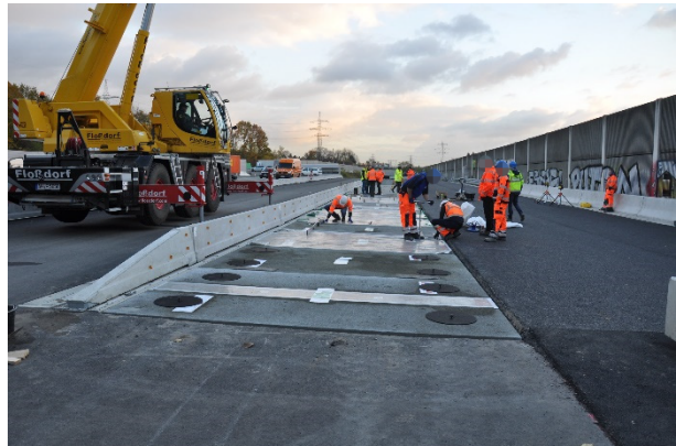
Bild A.46: Einbaustelle nach dem Verlegen der Fertigteile 1 bis 12
