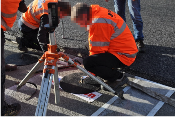
Bild A.55: Entlasten nach Unterfüllen der Platte (mit zeitlichem Abstand)
