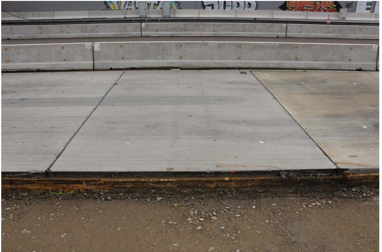
Abb. 3: belastetes Fertigteile 1 am 15.8.2019
