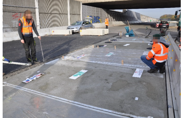
Bild A.50: Nachjustierung der Plattenreihe
