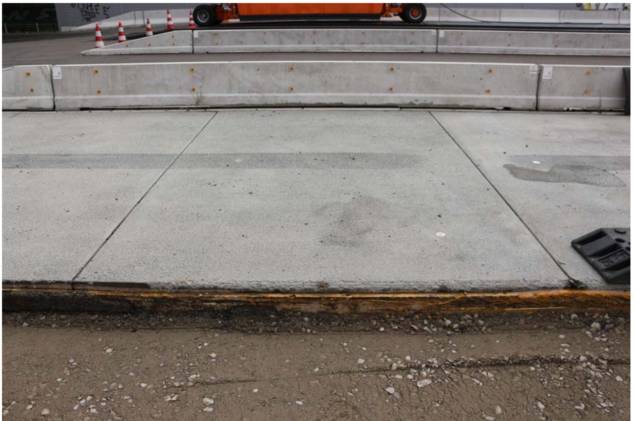
Abb. 12: belastetes Fertigteil 10 am 15.8.2019
