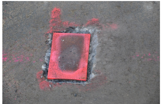
Bild A.42: eingesetzte Stahlplatte als Auflagerung für Höhenjustierelement
