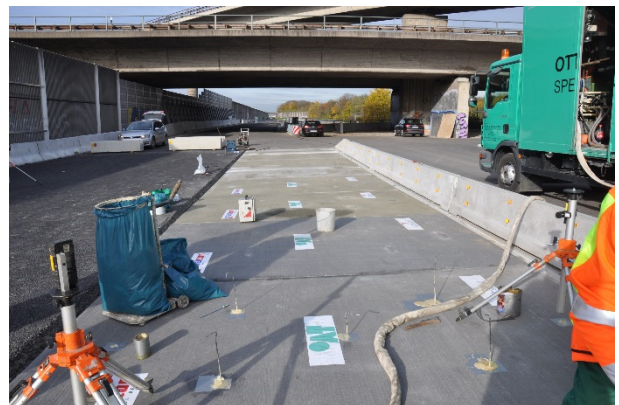
Bild A.77: Bereits fertig unterpresste Fertigteile
