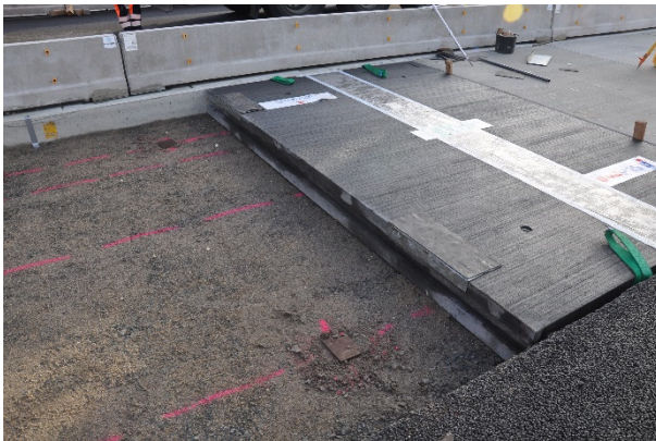
Bild A.3: Fertigteil 1 und bereits verlegte Unterlegplatten für Platte 2
