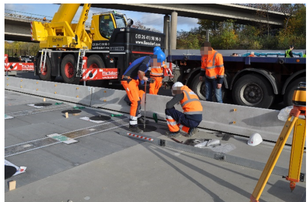
Bild A.30: Höhenjustierung am Fertigteil 1
