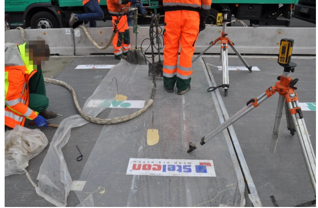
Bild A.73: Unterpressen und Höhenkontrolle
