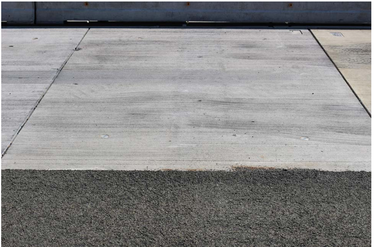
Abb. 3: belastetes Fertigteil 1 am 29.4.2019
