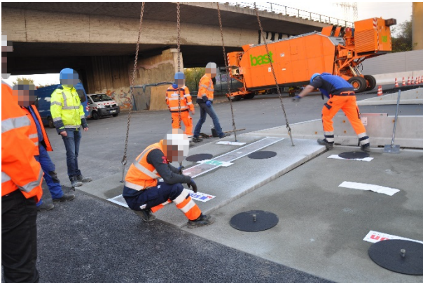
Bild A.45: Einsetzen des Fertigteils 12
