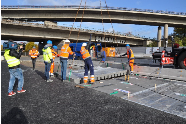
Bild A.25: Korrektur am Fertigteil 6
