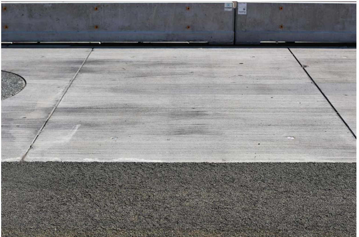
Abb. 4: belastetes Fertigteil 2 am 29.4.2019
