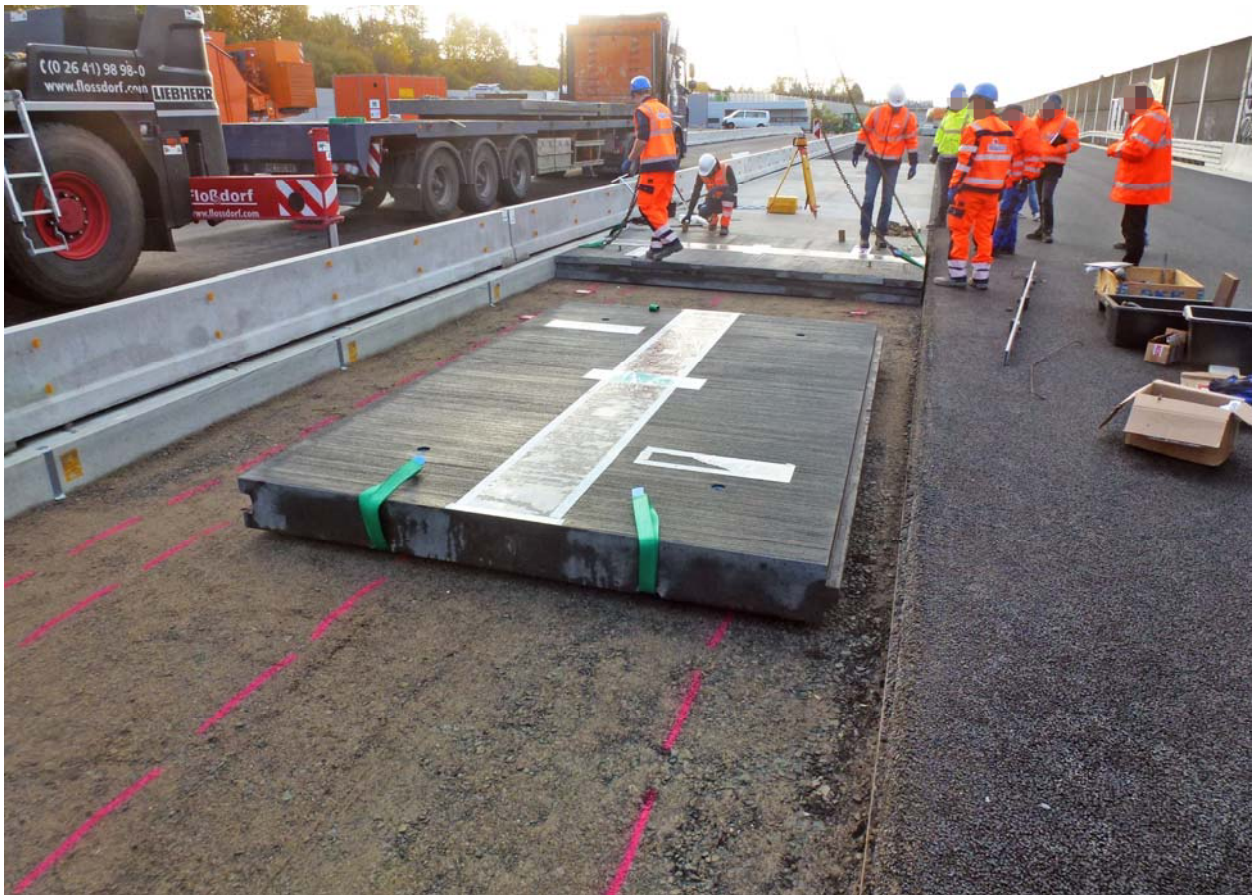
Abb. 3: Einbau der Fertigteile am 13.11.2017
