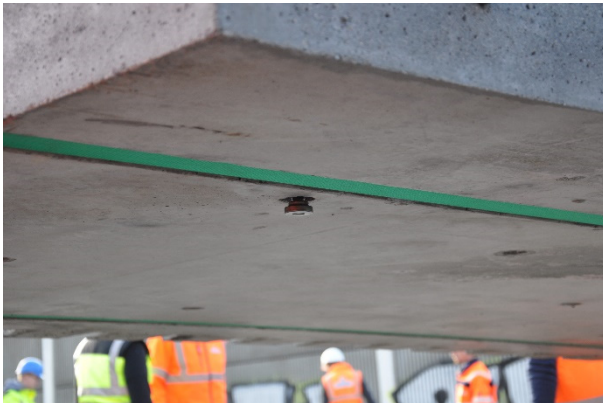
Bild A.27: Höhenjustierelement an der Unterseite des Fertigteils
