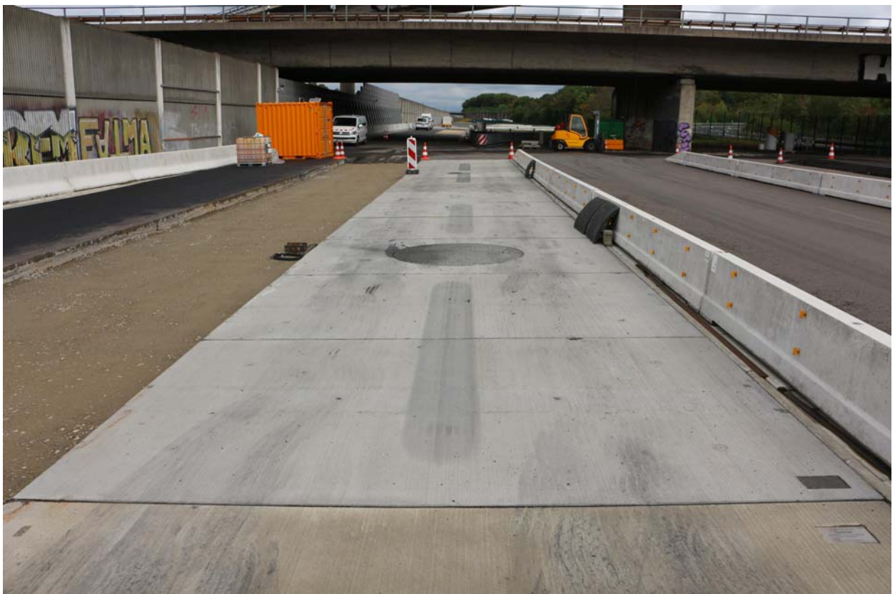
Abb. 2: Versuchsstrecke – Zustand am 15.8.2019
