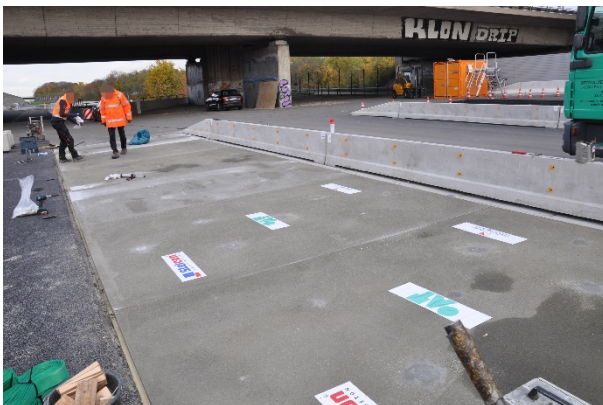
Bild A.76: Bereits fertig unterpresste Fertigteile
