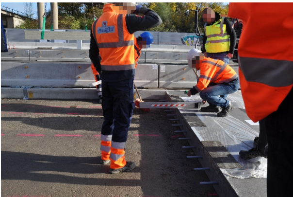
Bild A.23: Prüfen der Höhenlage nach Ausheben von Platte 7
