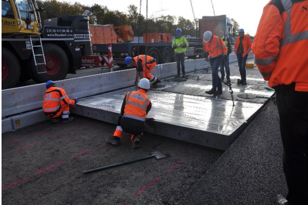
Bild A.13: Einsetzen und Ausrichten des Fertigteils 3
