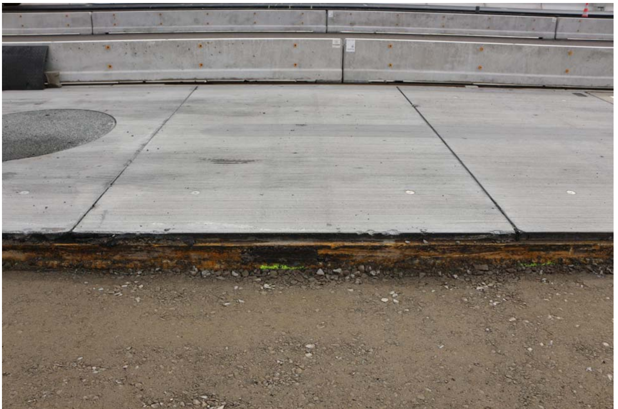
Abb. 4: belastetes Fertigteile 2 am 15.8.2019
