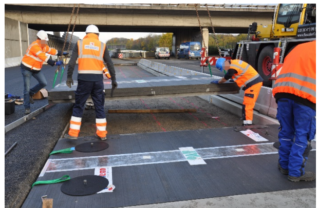
Bild A.6: Einsetzen des Fertigteils 2
