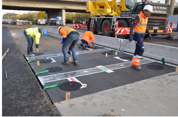
Bild A.8: Eingesetzte Fertigteile 1 und 2
