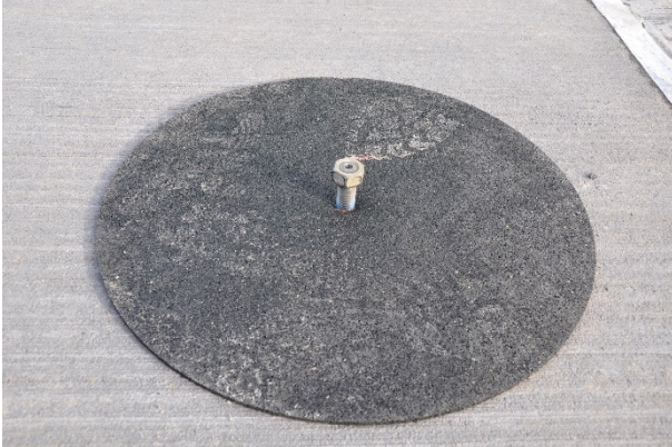
Bild A.78: Höhenjustierelement JTU mit Gummimatte als Schutz vor austretendem Silikatharz
