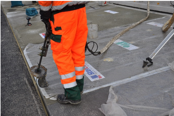
Bild A.69: Verfüllen im Randbereich zum Asphalt
