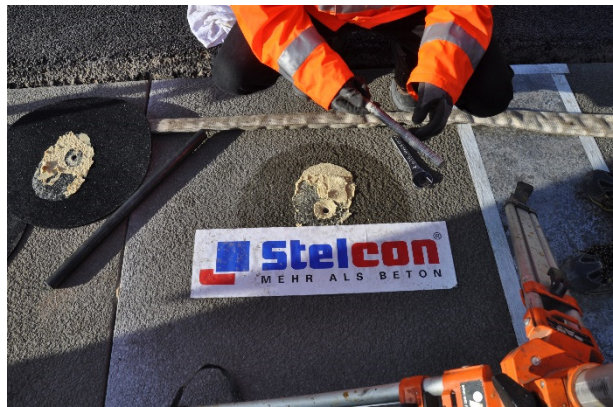
Bild A.58: im Bolzen aufsteigendes Silikatharz führt zur Verschmutzung an der Oberseite des Fertigteils (Einzelfall)
