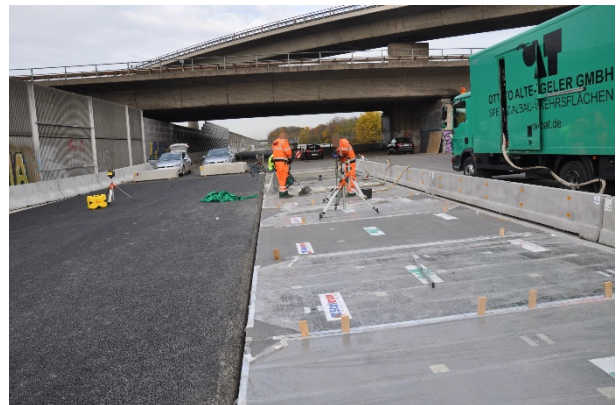
Bild A.66: Ansicht Einbaustelle während des Unterfüllens
