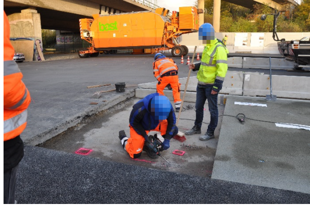
Bild A.44: Aufstemmen der Tragschicht für Unterlegplatten unter Fertigteile 12
