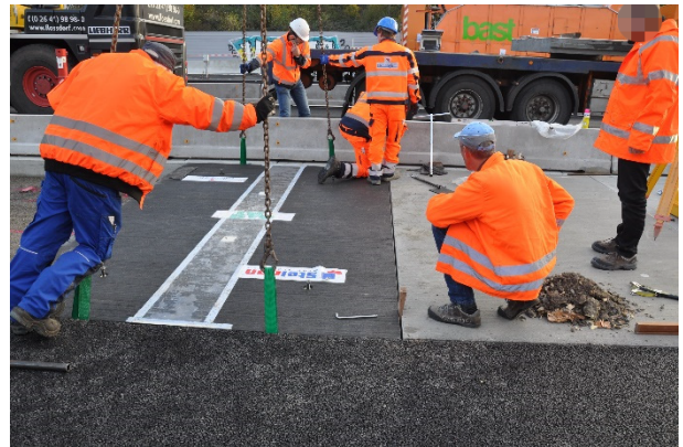
Bild A.4: Ausrichten von Fertigteil 1
