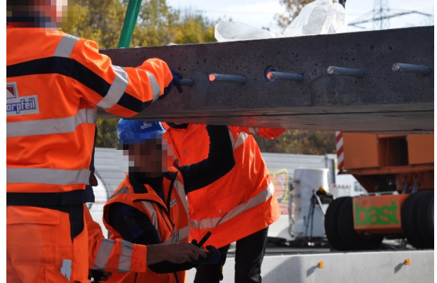
Bild A.26: Wiederherstellen der Funktionsfähigkeit eines Höhenjustierelements nach Werkzeugbruch
