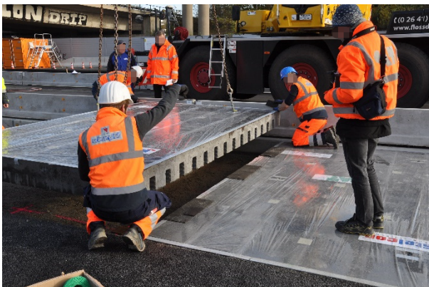
Bild A.17: Einsetzen von Fertigteil 4
