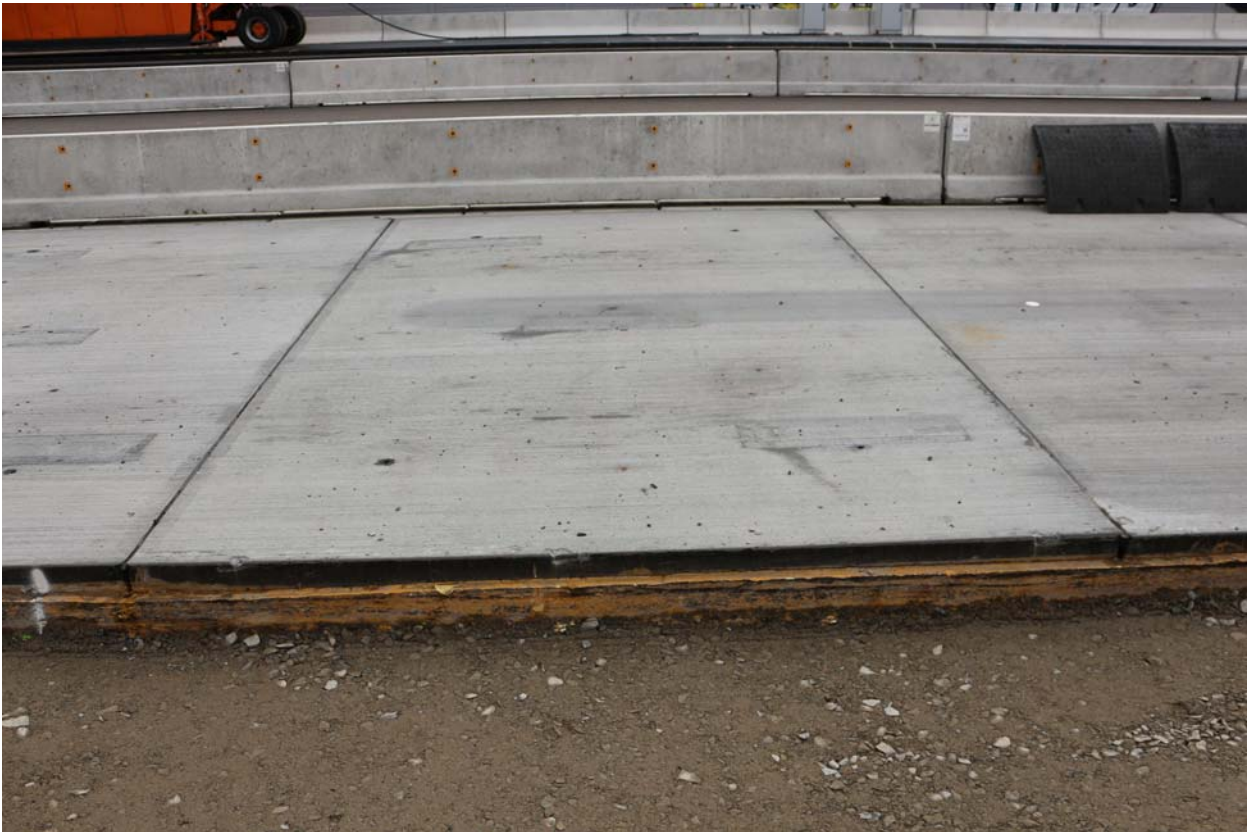
Abb. 7: belastetes Fertigteile 5 am 15.8.2019
