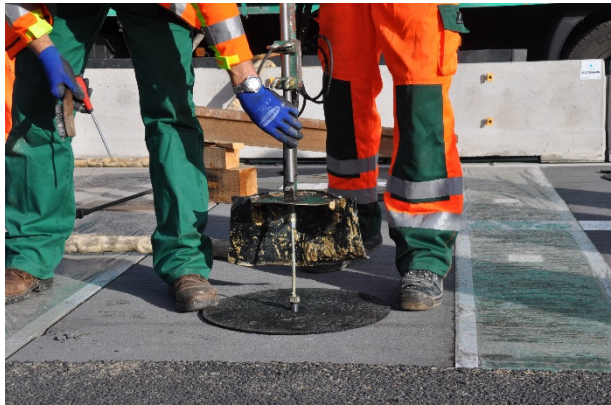
Bild A.81: Lanze im Höhenjustierelement JTU
