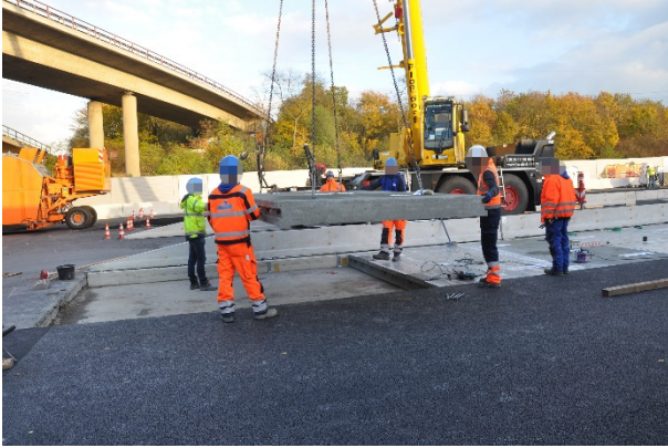
Bild A.43: Einsetzen des Fertigteils 11
