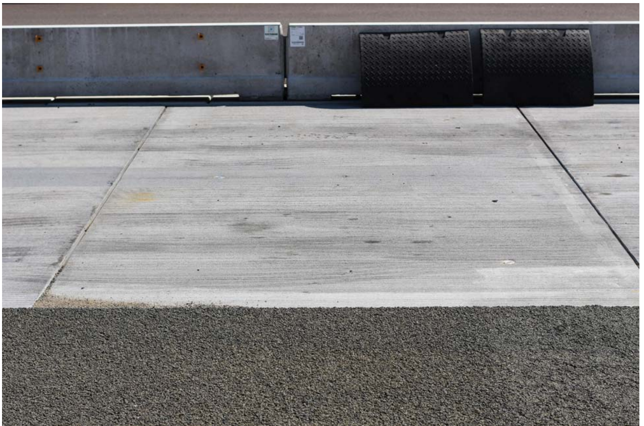
Abb. 6: belastetes Fertigteil 4 am 29.4.2019
