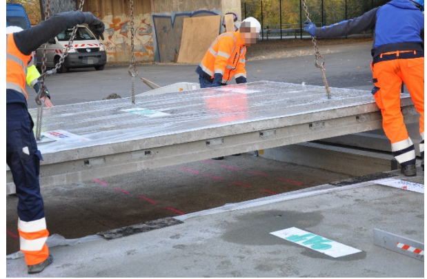
Bild A.38: Einsetzen von Fertigteil 10
