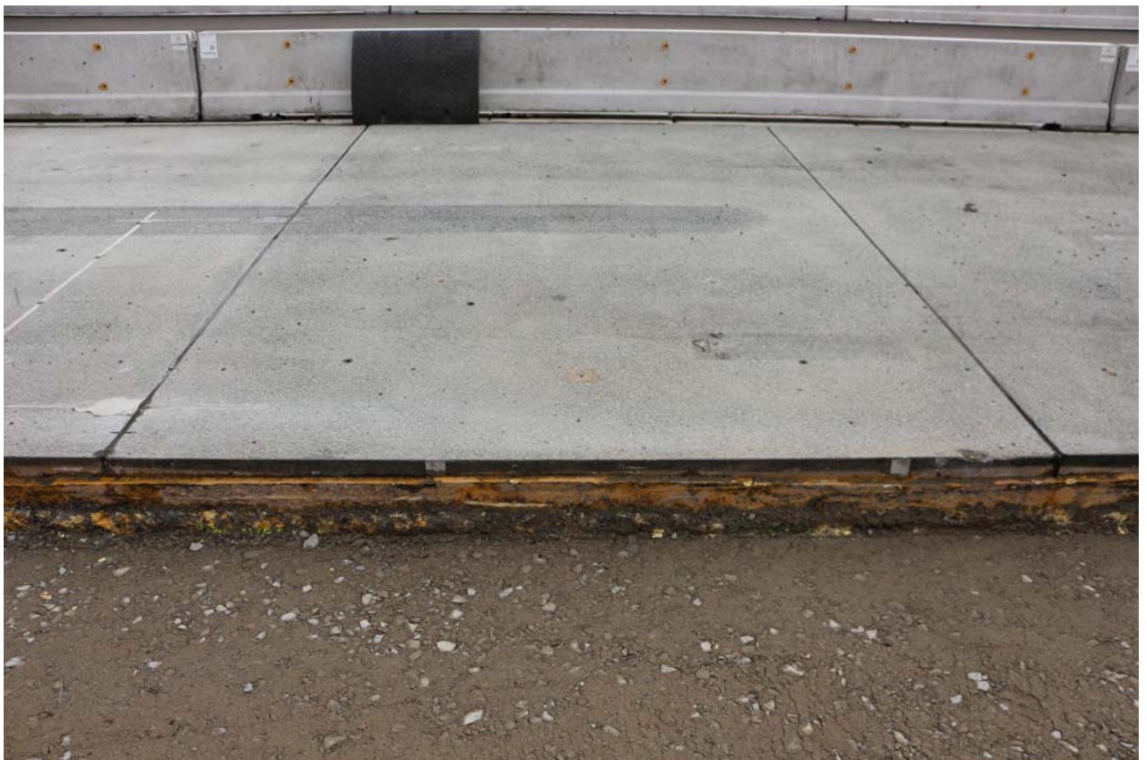
Abb. 10: belastetes Fertigteil 8 am 15.8.2019
