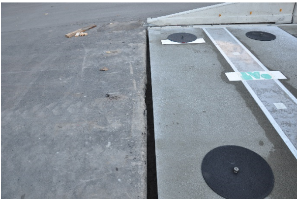
Bild A.47: Ende der Plattenreihe am Fertigteile 12
