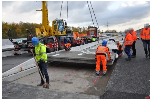
Bild A.40: erstes Einsetzen von Fertigteil 11
