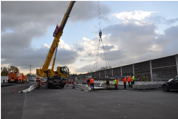
Bild A.39: Ansicht Einbaustelle beim Einbau der letzten Fertigteil
