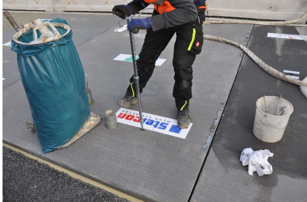
Bild A.79: Entlasten am Höhenjustierelement J
