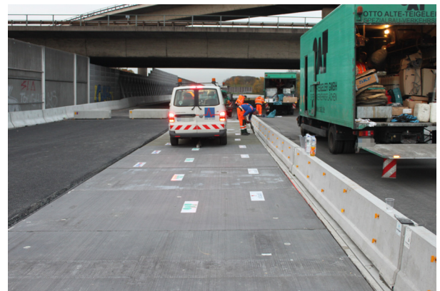
Bild A.89: Fugenverguss kalt
