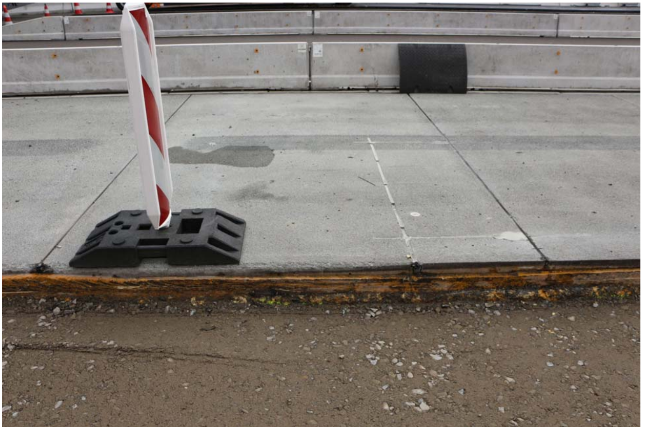
Abb. 11: belastetes Fertigteil 9 am 15.8.2019
