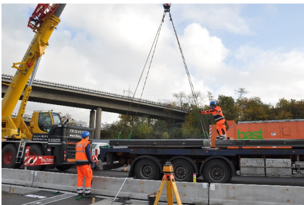
Bild A.5: Abladen des Fertigteils 2
