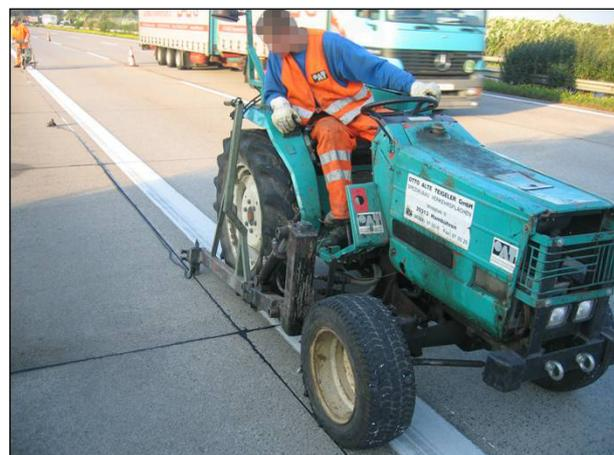
Bild 3.1: Fugensanierung – Herausreißen des alten Fugenmaterials [OAT 2021]
