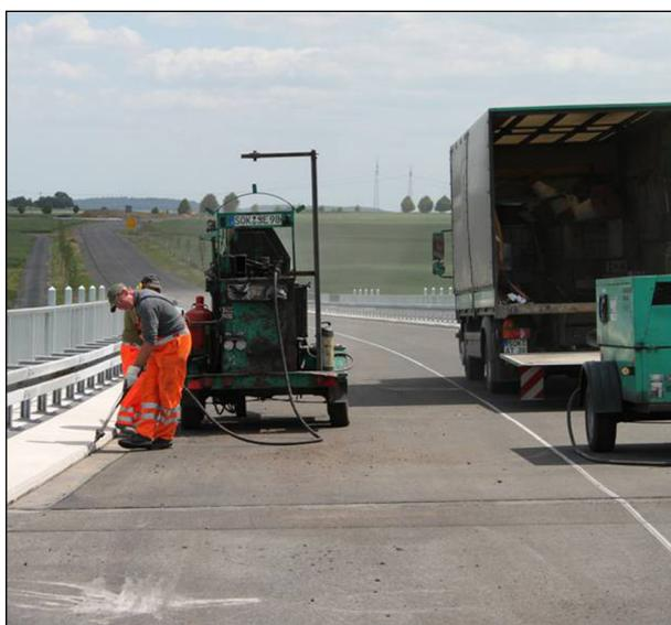
Bild 3.4: Fugensanierung – Füllen des vorbereiteten Fugenspalts [OAT 2021]
