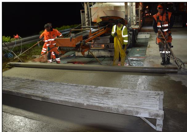
Bild 3.10: Abziehen der Oberfläche mit Nivellierwalze
