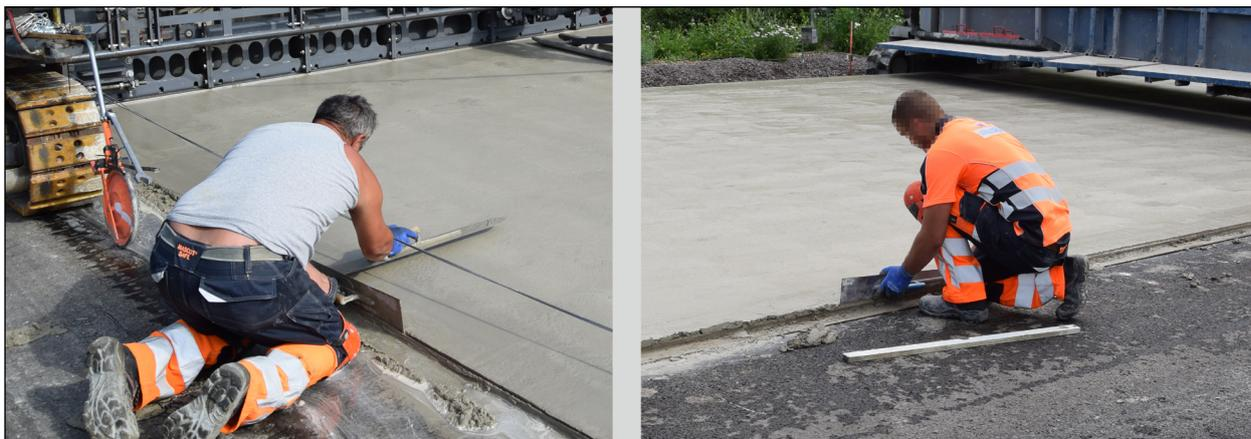
Bild 3.17: Unterschiedliche Positionen beim Nacharbeiten der frischen Betonkante
