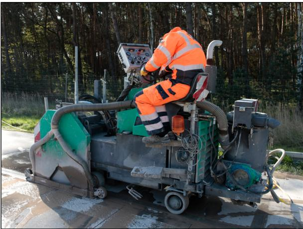
Bild 3.5: Plattenersatz – Schnitte entlang der Längsfuge [OAT 2021]
