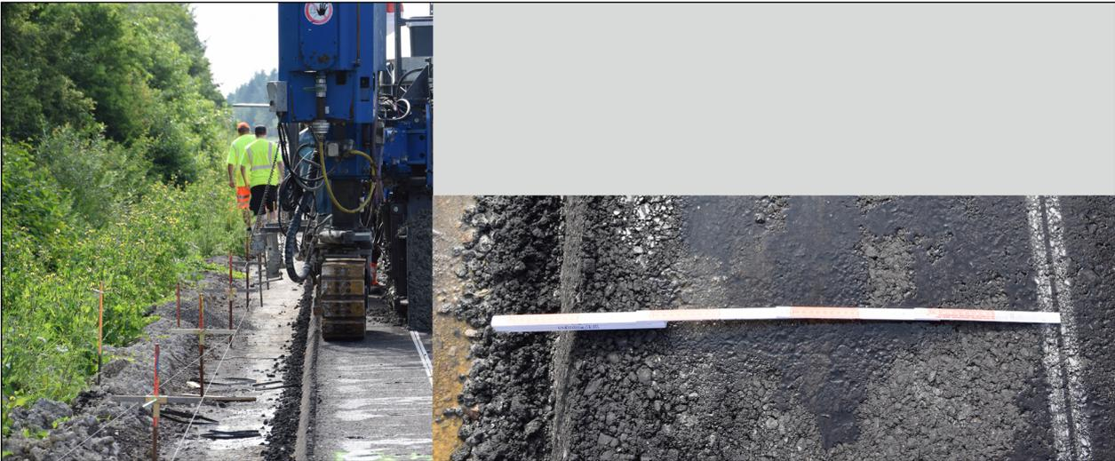
Bild 3.15: Arbeitsbereich Gleitschalungsfertiger 0,70 m neben Betonkante
