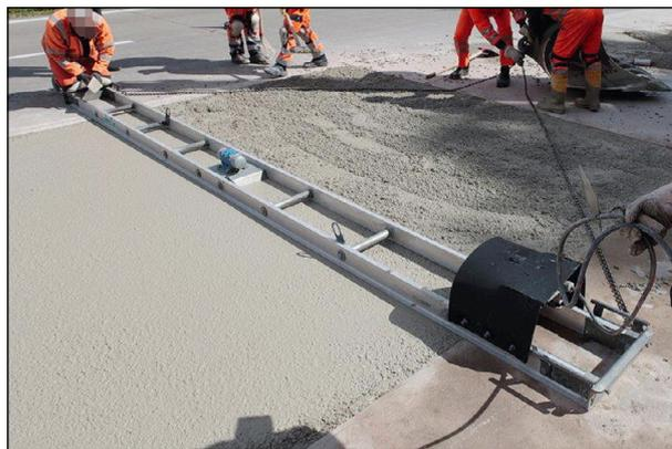
Bild 5.9: Verdichten mittels Rüttelbohle [Foto: OAT]
