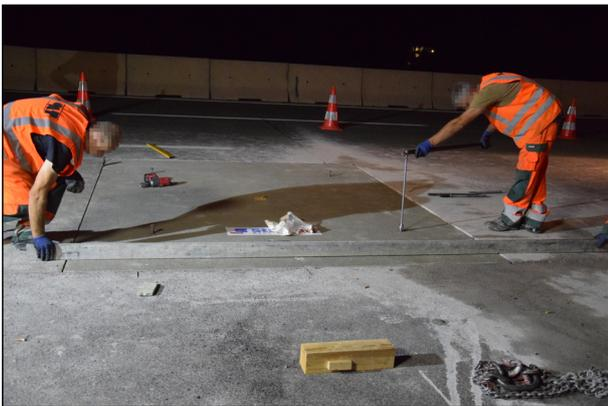
Bild 5.3: Höhenjustierung mittels Einbauelementen
