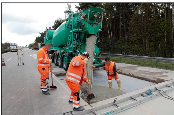
Bild 5.8: Einbringen des Betons [Foto: OAT]
