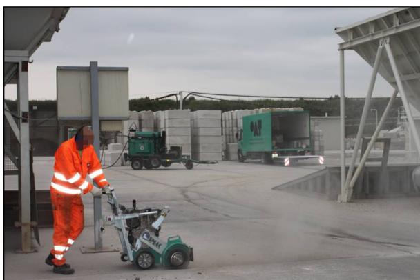
Bild 3.3: Fugensanierung – Ausbürsten des Fugenspalts [OAT 2021]
