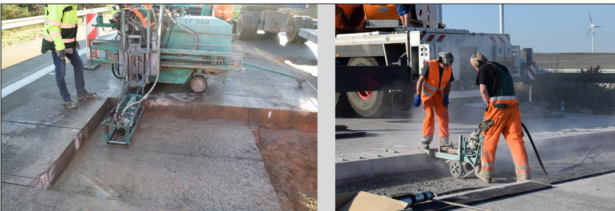
Bild 3.6: Bohren von Löchern zum nachträglichen Einbau von Dübeln bzw. Ankern [OAT 2021]
