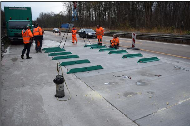
Bild 5.2: Höhenjustierung mittels Traversen
