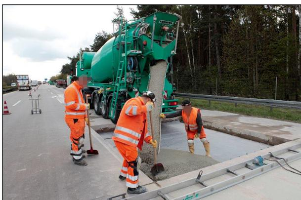
Bild 3.8: Einbringen und Verteilen des Betons beim Plattenersatz [Foto: OAT]
