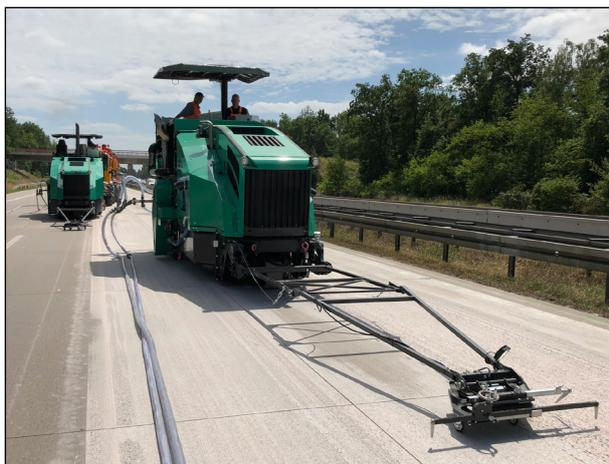
Bild 3.14: Grindingmaschine [OAT 2021]
