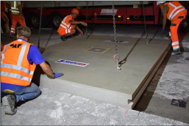
Bild 5.1: Einheben und Ausrichten von Fertigteilen
