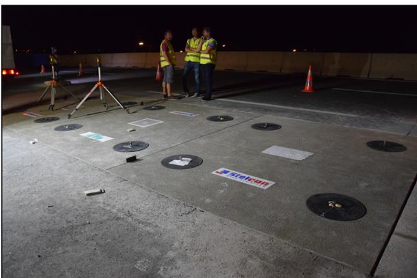
Bild 5.4: Unterpressstellen auf den Fertigteilen
