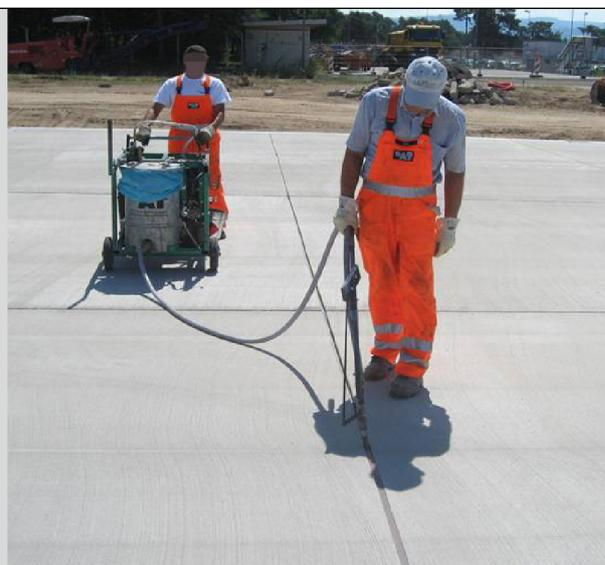
In jedem Fall sind die Beteiligten vor Beginn der Bauarbeiten darauf hinzuweisen, sich auf der verkehrsabgewandten Seite der Fuge zu bewegen. Gegebenenfalls sind die Arbeiten so zu planen, dass sie bei Notwendigkeit auch entgegen der Fahrtrichtung ausgeführt werden können, um den Abstand zwischen fließendem Verkehr und Mitarbeitern auf der Baustelle maximieren und Breitenkonflikte minimieren zu können.
