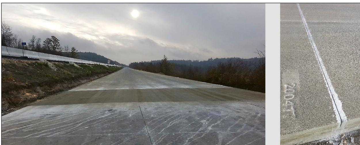
Bild 8: Fertiger Abschnitt im CEM I-Referenzabschnitt (links) und geschnittene QSF (rechts)
