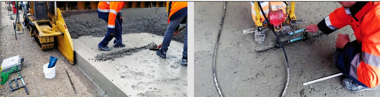
Bild 10: Einbau der Hilfskonstruktion mit Temperaturmessfühlern in den Unterbeton (Quelle: TPA)
