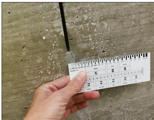
Bild 22: Rissbreitenbestimmung an QSF
