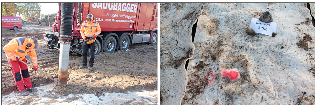
Bild 5-8: Saugbaggerarbeiten und rot markierte Stellen
