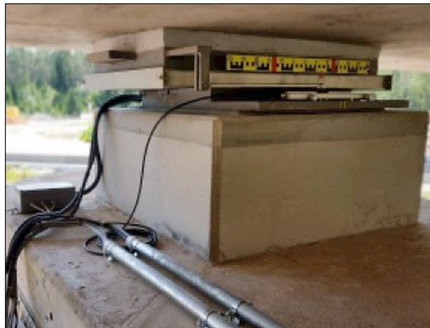
Bild 34: Instrumentiertes Lager; Quelle: Schlussbericht „Digitales Testfeld Autobahn – Intelligente Brücke – Datenerfassungsstrategien und Datenanalyse für intelligente Kalottengleittlager (BUTZ, C. (2021))“
