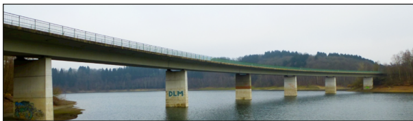
Bild 3-29: Ansicht Krähwinklerbrücke (Foto: TU Dortmund)
