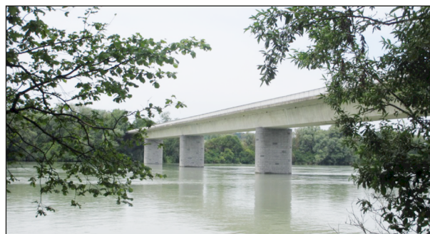
Bild 4-32: Ansicht der Innbrücke bei Passau (Foto: matrices engineering GmbH)
