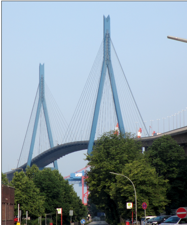
Bild 4-46: Brücke über die Elbe (Foto: matrix engineering GmbH)
