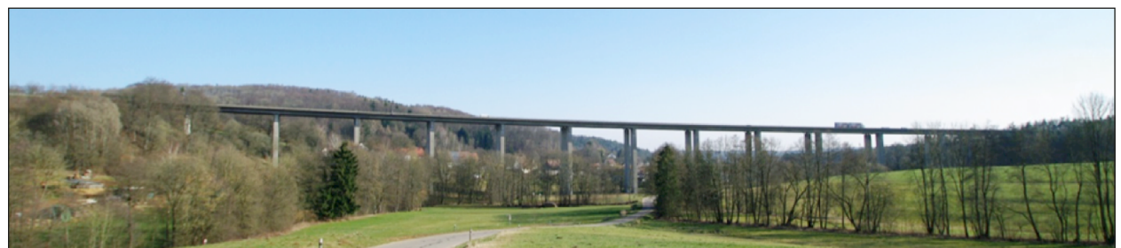
Bild 4-5: Talbrücke Unterrieden (Foto: ZM-I)
