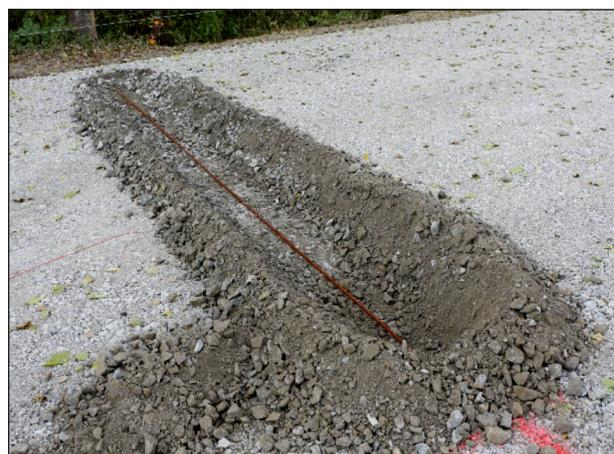
Bild 20: Stabstahl in der FSS zur Stationierungskontrolle
