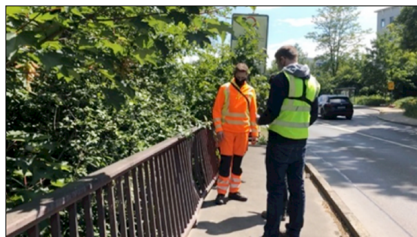
Bild 16: Exemplarische Prüfung des Brückenoberbaus
