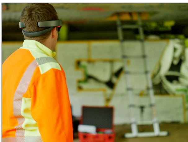
Bild 2: Zukunftsvision einer handnahen Bauwerksprüfung unterstützt mithilfe von AR-HMD's
