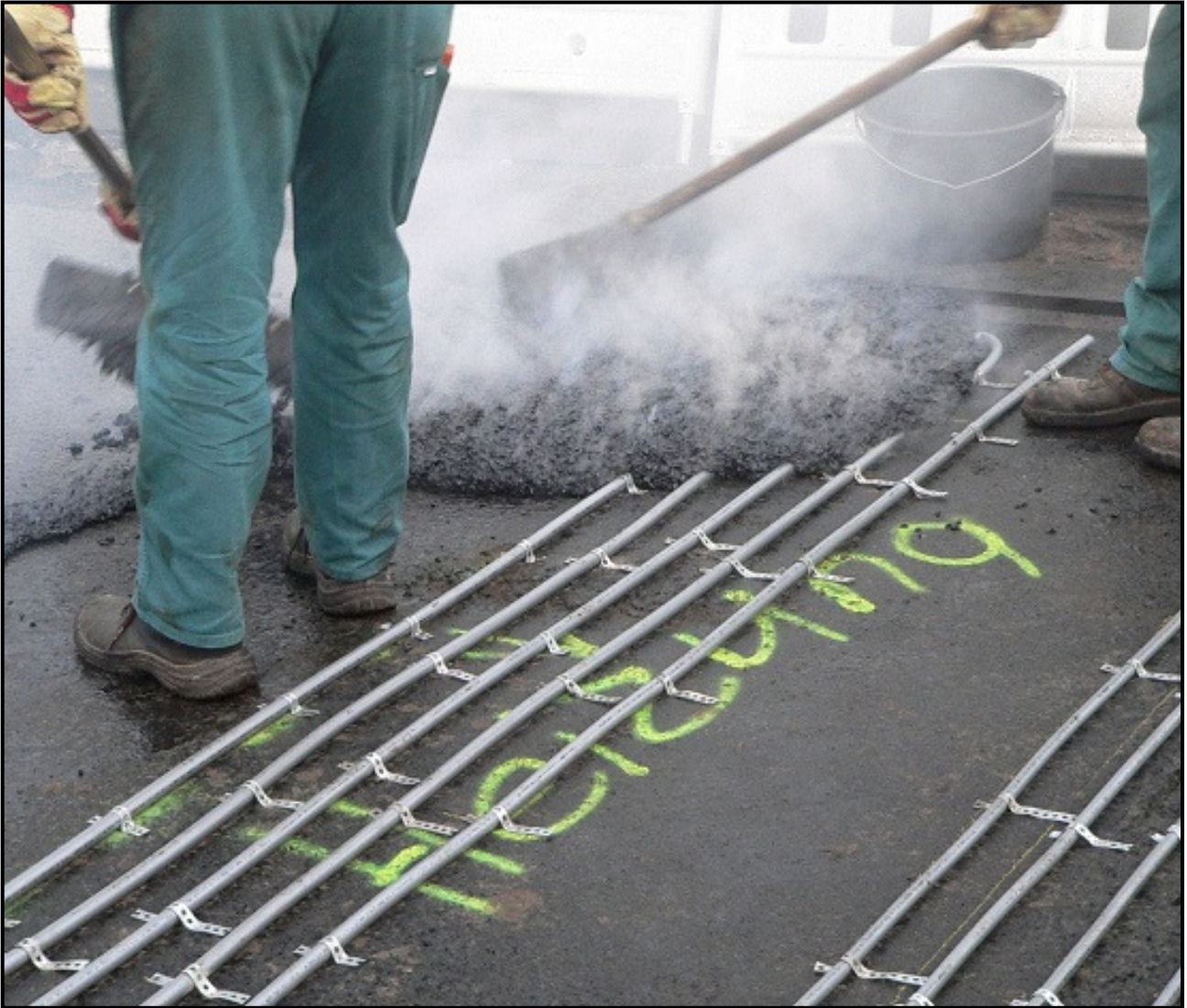
Bild 4: Einbau des Gussasphaltes auf die fixierten Rohre
