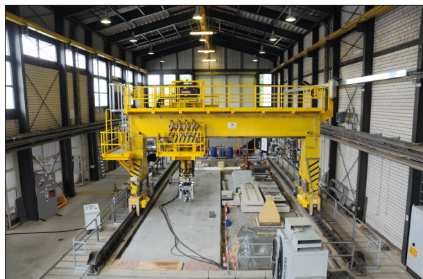
Bild 2-1: Belastungsrahmen in Halle 7 der BAST
