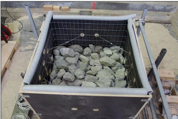
Bild 5-1: Befüllung der Gabione mit Granit 80/250 und Einbau der 2. Distanzhalterebe
