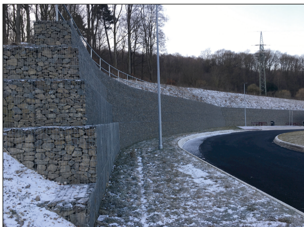
Bild 1-1: Stützmauer aus Gabionen. Rastplatz Funckenhausen an der BAB 1.
