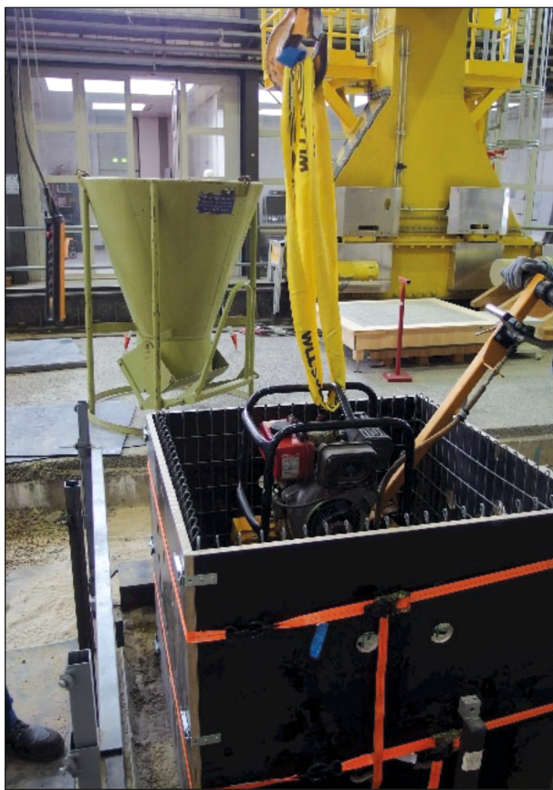
Bild 5-2: Versuch 7 – Verdichtung des Füllmaterials mittels Rüttelplatte
