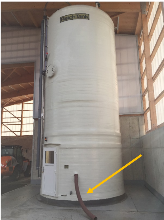
Bild 44: Upflow-Löseanlage mit integriertem Salzvorrat und Abschlämmschlauch in der SM Dillingen
