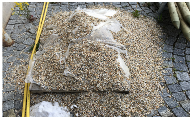
Bild 3: Salzlöseanlage nach dem Downflow-Prinzip in der AM Trockau (unten links: Soleabzugsrohre auf dem Boden der Salzlöseanlage, unten rechts: Kiesschüttung für den Soleabzug)
