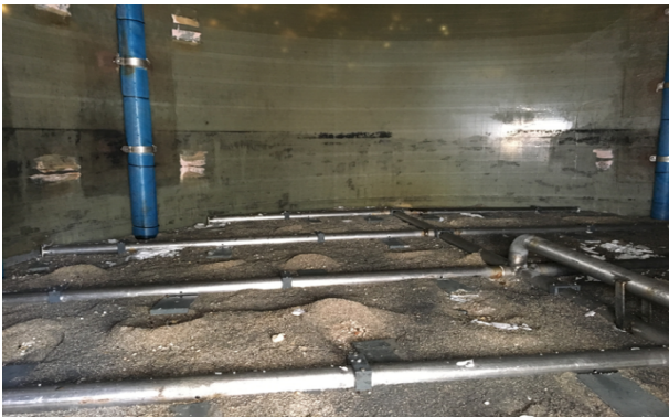
Bild 3: Salzlöseanlage nach dem Downflow-Prinzip in der AM Trockau (unten links: Soleabzugsrohre auf dem Boden der Salzlöseanlage, unten rechts: Kiesschüttung für den Soleabzug)
