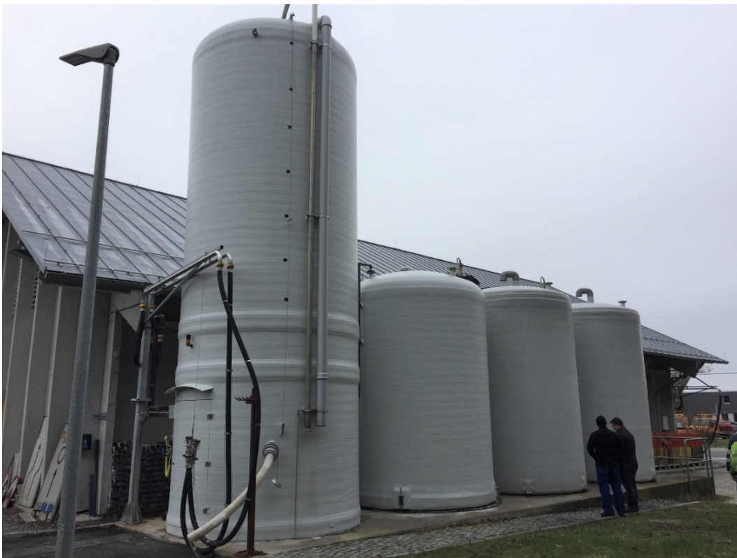
Bild 28: Tausalzlöseanlage in der AM Kist
