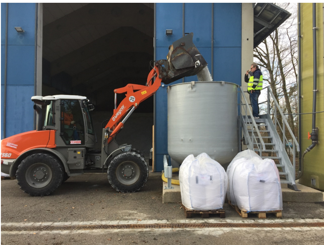
Bild 30: Tausalzlöseanlage in der SM Neumarkt
