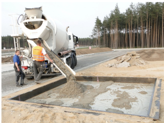
Abbildung 9: Einbringen des Betons
