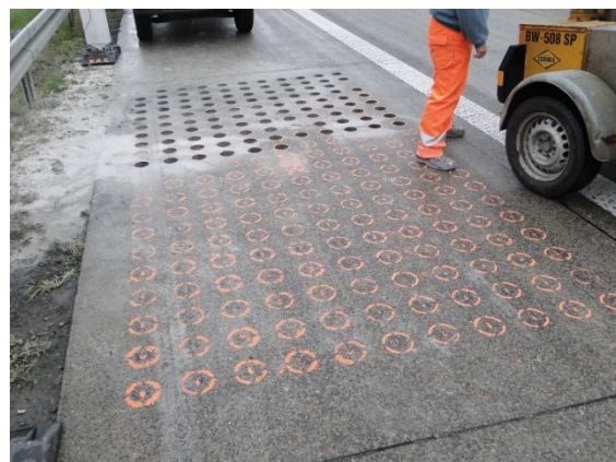
Abbildung 12: Bohrkernentnahme aus einer Fahrbahnplatte (Prüflos 7, BAB A38, Südumfahrung Leipzig)
