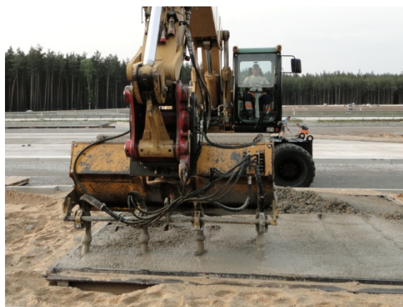
Abbildung 10: Verdichten der Versuchsplatte
