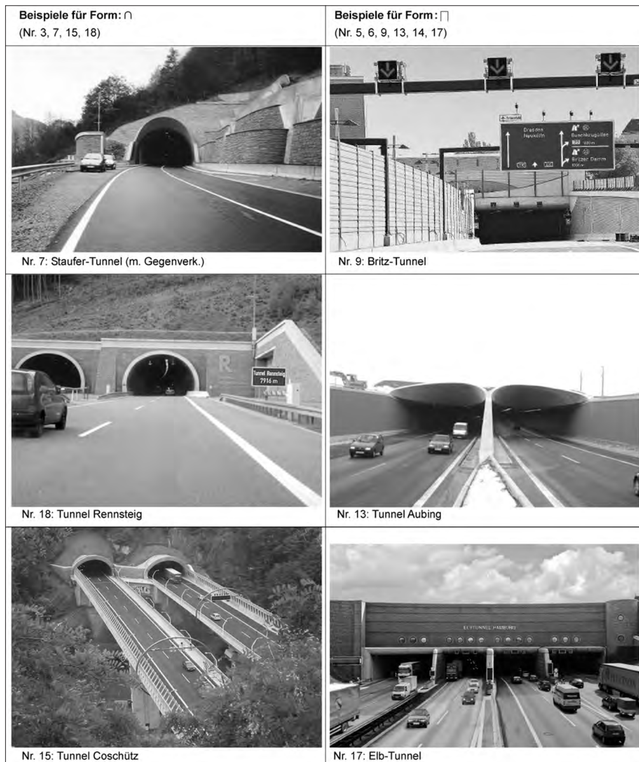
Bild 5.3: Tunnel, für die Befragungsergebnisse vorliegen – Beispiele
