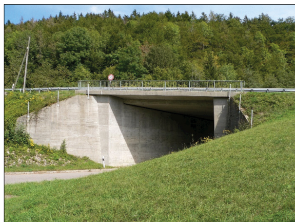
Bild 79: Brücke im Zuge der B 500 über den Anschlussast bei Gaiss (1)
