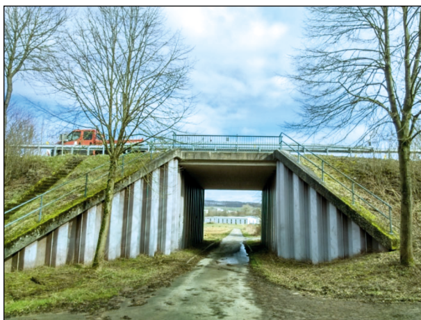
Bild 11: Überführung der Bundesstraße B 64 über einen Feldweg bei Herste (1)
