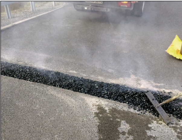
Bild 21: Einbau der Gesteinskörnung (1)
