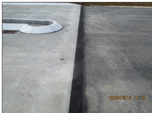
Bild 106: Belagsdehnfuge am Verteilerkreis direkt nach Fertigstellung (13)
