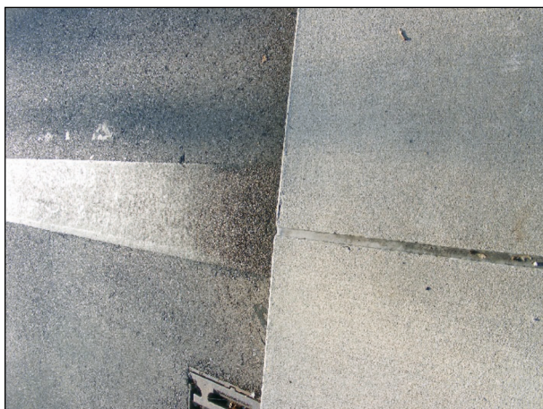
Bild 96: 30 cm breite Belagsdehnfuge auf der Brücke Ulrich-Schweizer-Straße (11)
