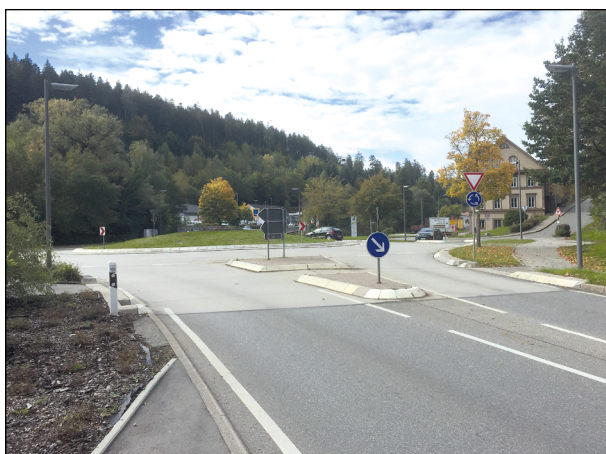
Bild 89: Kreisverkehr im Zuge der B 28 in Altensteig (8)
