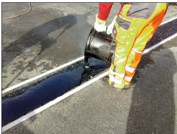
Bild 25: Einbringen der heißen Tränkmasse (1)
