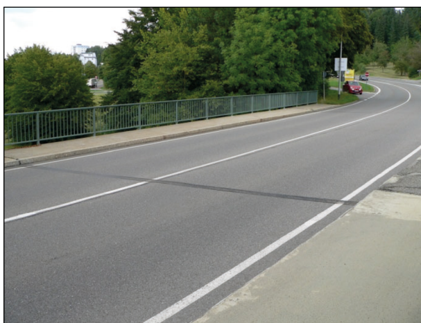
Bild 68: Überführung der Schwenningerstraße über den Fürstenbergring (1)
