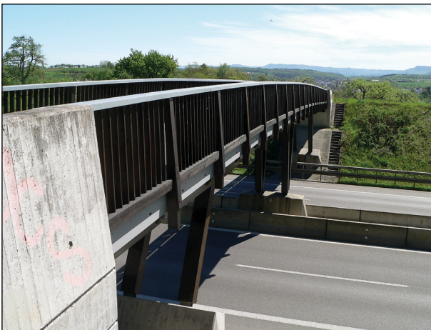
Bild 46: Holzbrücke über die B 313 in Nürtingen (1)
