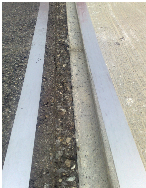
Bild 112: Vorbereitete Mulde zwischen Asphalt- und Betonfahrbahn (15)
