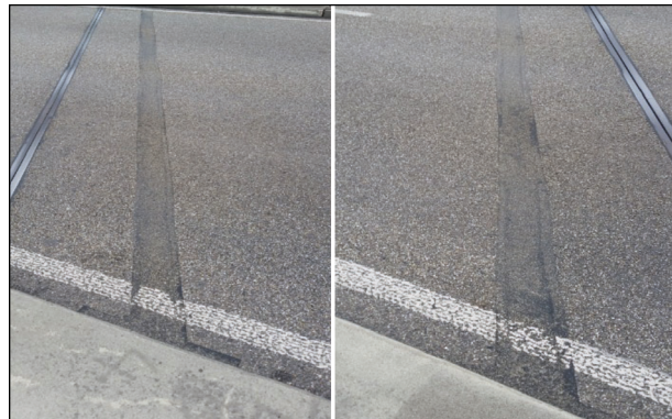
Bild 110: Belagsdehnfugen im Zuge der B 500 über den Sandbach bei Iffezheim nach 6 Jahren unter Verkehr ohne Schäden (14)
