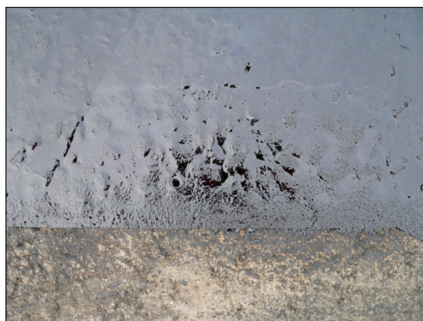
Bild 28: Komplett mit Tränkmasse gefülltes Gesteinskörnungsgüst der Muldenfüllung (1)
