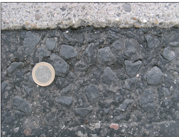
Bild 102: Freigelegte grobe Gesteinskörnung der Muldenfüllung (12)
