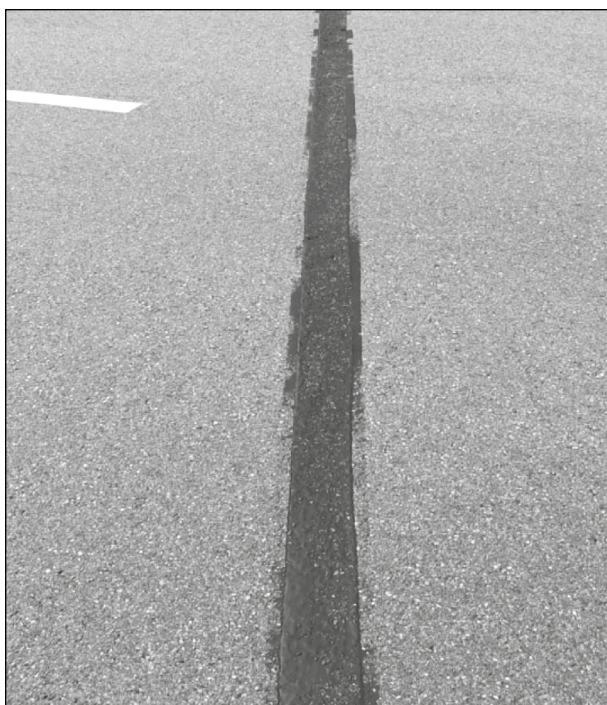
Bild 76: Belagsdehnfuge auf der Brücke über die K 6563 bei Gaiss nach 4 Jahren unter Verkehr ohne Schäden (1)
