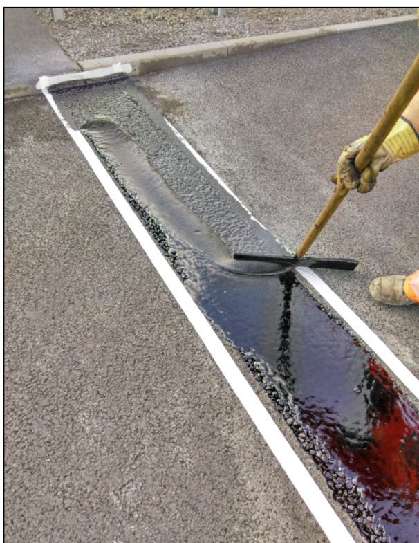
Bild 26: Verteilen der Tränkmasse (1)
