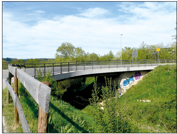
Bild 41: Brücke über die Lauter im Zuge der L 1200a (1)
