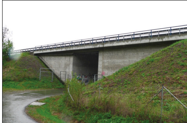
Bild 48: Wirtschaftswegunterführung im Zuge der BAB A 81 (1)
