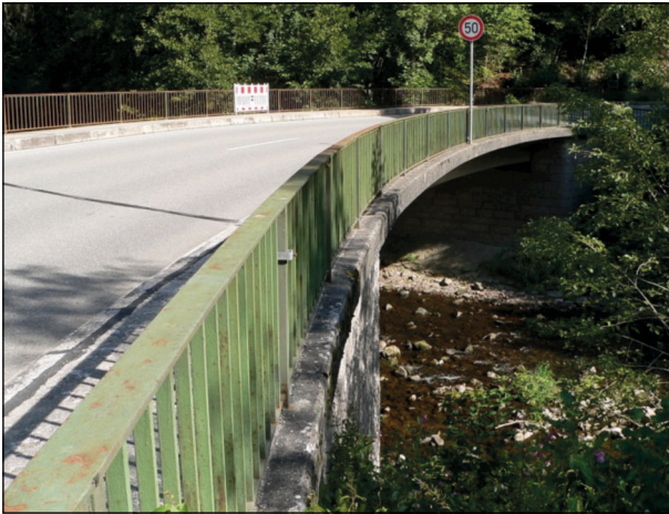
Bild 72: Brücke über die Wutach (1)
