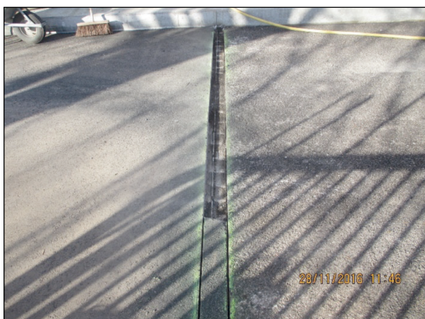
Bild 105: Herausstemmen der Mulde für die spätere 12 cm breite Belagsdehnfuge (13)
