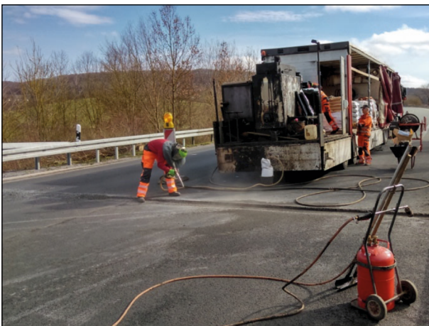
Bild 15: Sandstrahlen der Fugenmulde (1)
