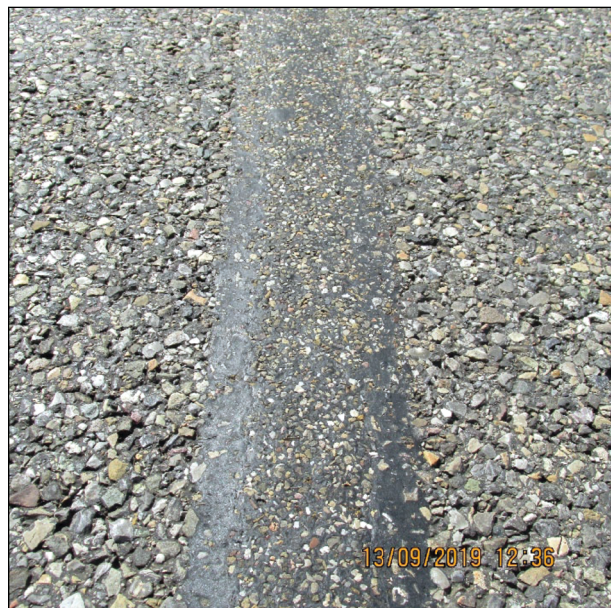
Bild 83: Belagsdehnfuge der Brücke über die Steina im Zuge der BAB A 98 nach 10 Jahren unter Verkehr ohne Schaden (6)
