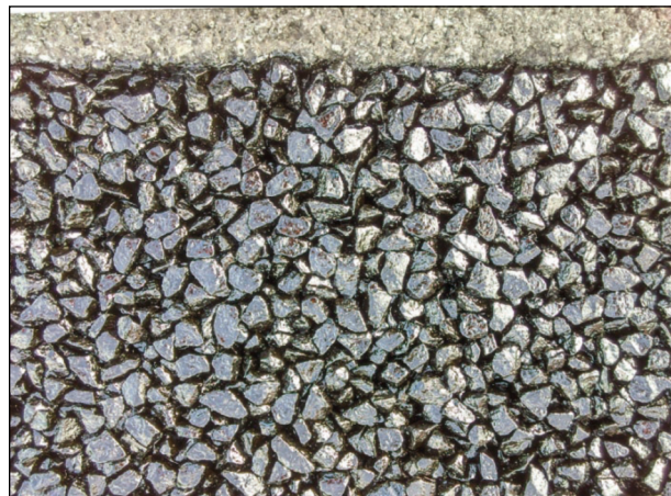
Bild 24: Fertiges Gesteinskörnungsgerüst vor dem Verfüllen mit der Tränkmasse (1)
