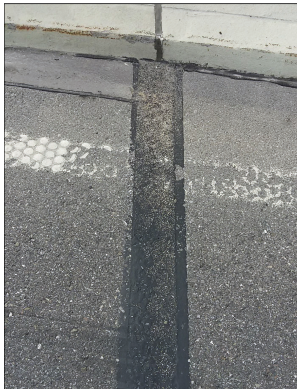
Bild 103: Belagsdehnfuge bis zur Brückenkappe, nach 3 Jahren unter Verkehr ohne Schäden (13)
