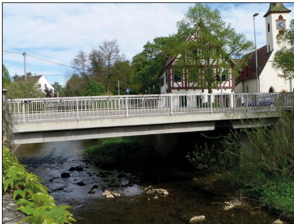
Bild 43: Aichbrücke in Nürtingen-Oberensingen (1)
