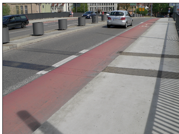
Bild 37: Fahrbahnübergänge aus Asphalt in herkömmlicher Breite in Fahrtrichtung Innenstadt (1)
