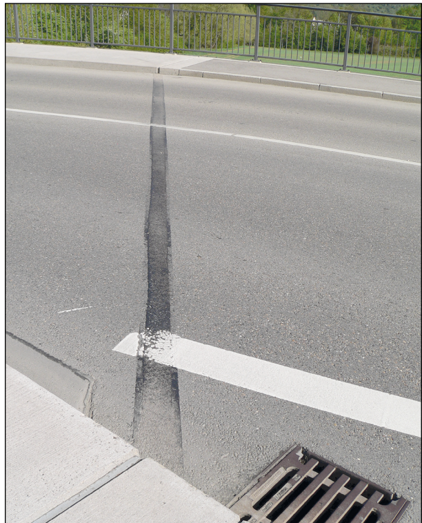
Bild 42: 14 cm breite Belagsdehnfuge im Zuge der L 1200a nach 5 Jahren unter Verkehr ohne Schäden (1)
