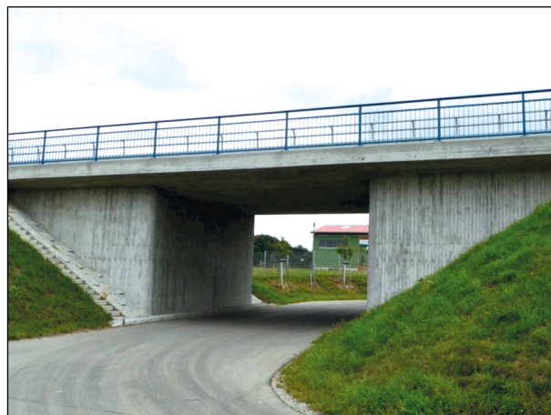
Bild 61: Überführung der Bundesstraße B 462 über einen Wirtschaftsweg (1)
