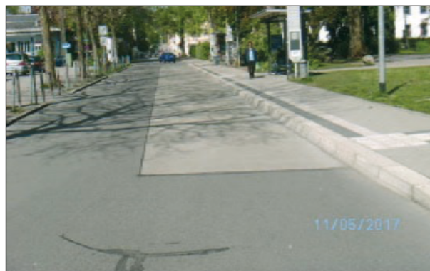
Bild 97: Betonsegment mit Belagsdehnfugen in der Busspur (12)
