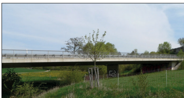
Bild 50: Brücke über die Glems im Zuge der K 1011 (1)
