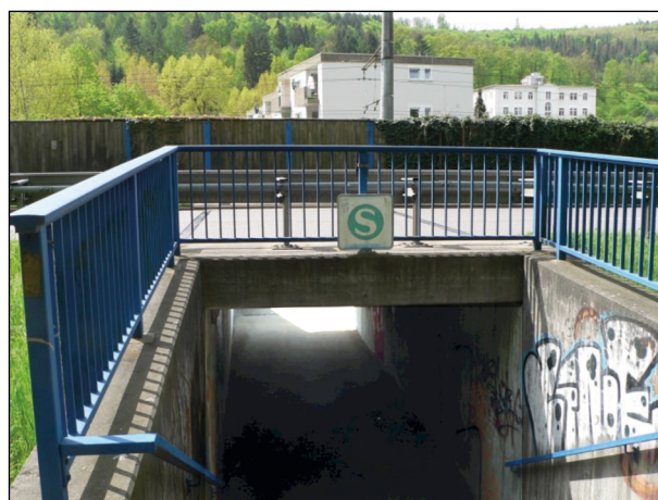
Bild 52: Fußgängerunterführung unter der L 562, Ettlingen (1)
