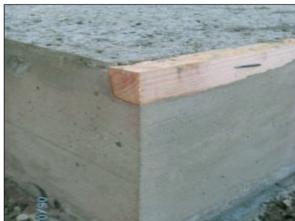
Bild 98: Aussparung in der Betonplatte für die spätere Belagsdehnfuge (12)
