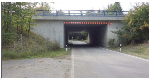
Bild 84: Überführungsbauwerk der BAB A 95 über die K 17 bei Achmühle (7)
