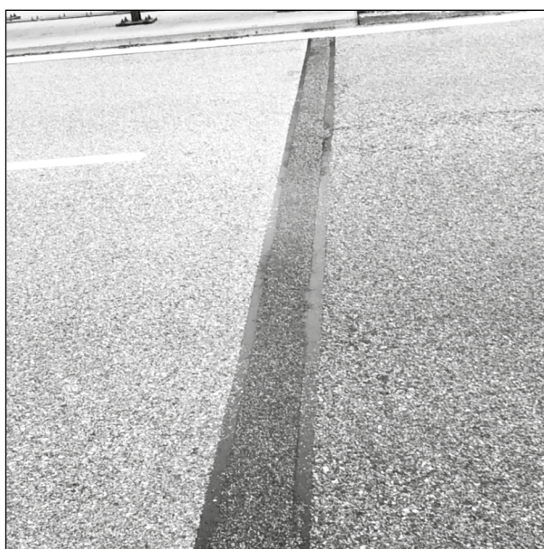
Bild 85: Schadensfreie Belagsdehnfuge der Brücke im Zuge der BAB A 95 nach 5 Jahren unter Verkehr (6)
