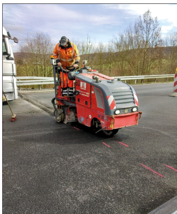
Bild 12: Ausfräsen der Fugenmulde entlang der Anzeichnung
