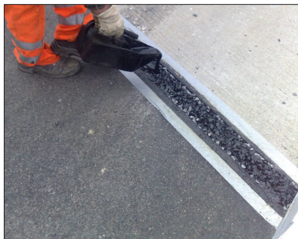
Bild 113: Verfüllen mit Tränkmasse (15)
