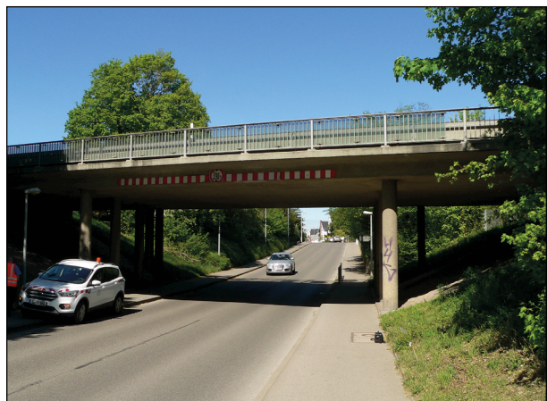
Bild 32: Überführung der B 297 über die Tannenbergsstraße in Kirchheim unter Teck (1)
