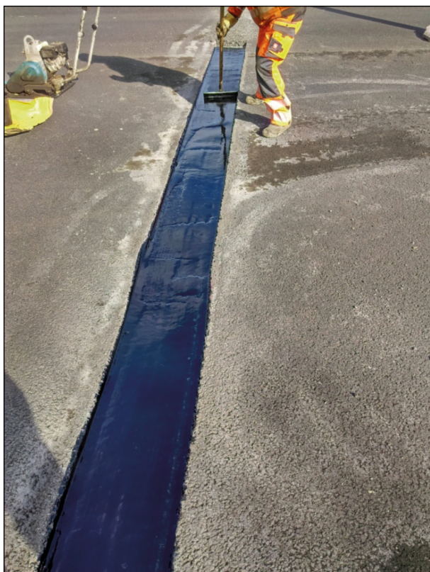
Bild 18: Auskleiden des Muldenbodens und der Muldenflanken mit der Tränkmassse (1)
