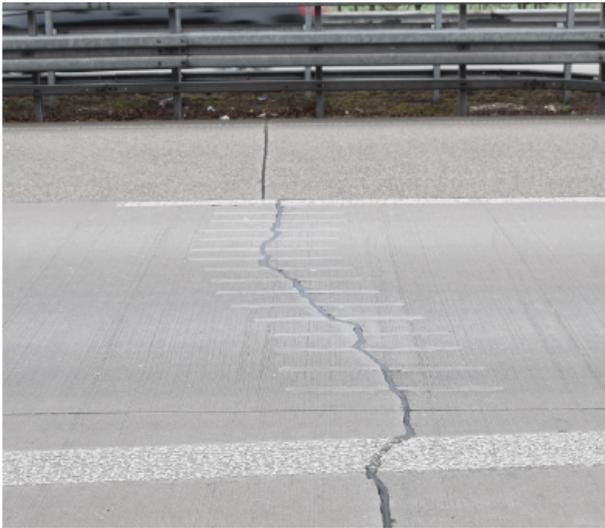
**Bild 130:** Detail der Zustandserfassung A40 – „wilde“ Risse aufgrund der Plattenlänge von 10 m, trotz stahlfaserbewehrtem Beton
