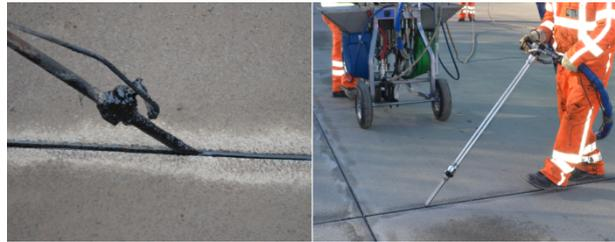
**Bild 6:** Einbringen von Fugenmasse (links: Heißverguss; rechts: Kaltverguss)
