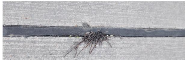
Bild 128: Detail der Zustandserfassung A40 – undichtes Fugenfüllsystem
