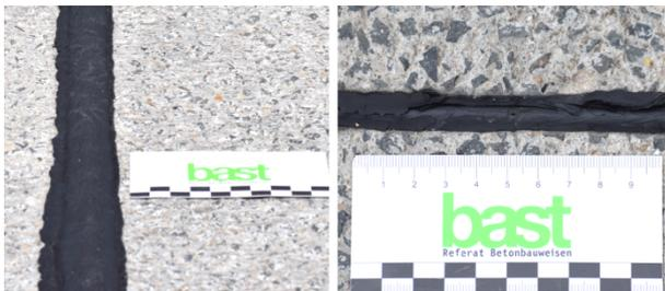
Bild 123: Überbeanspruchung der Fugensysteme A48 (links: heiß verarbeitbare Fugenmasse; rechts: heiß verarbeitbare Fugenmasse)
