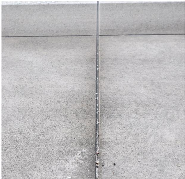
**Bild 163:** Verschmutzung inkl. Streusalzablagerungen im Standstreifen (Januar 2018, Testfeld 1.2)
