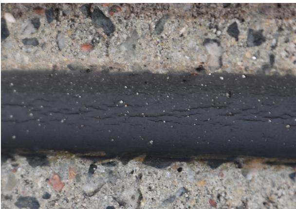
**Bild 162:** Detailaufnahme von oberflächlichen Rissen der Fugenmasse parallel zur Fugenflanke (Januar 2018, Testfeld 1.1)
