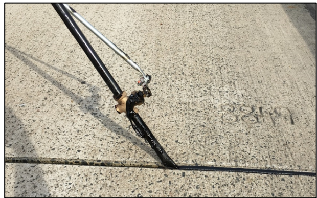
Bild 233: Einbau heiß verarbeitbare Fugenmasse (FM6) - Detail
