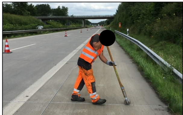
Bild 228: Einbringen der Unterfüllschnur
