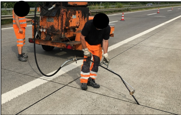
Bild 232: Einbau heiß verarbeitbare Fugenmasse (FM6)
