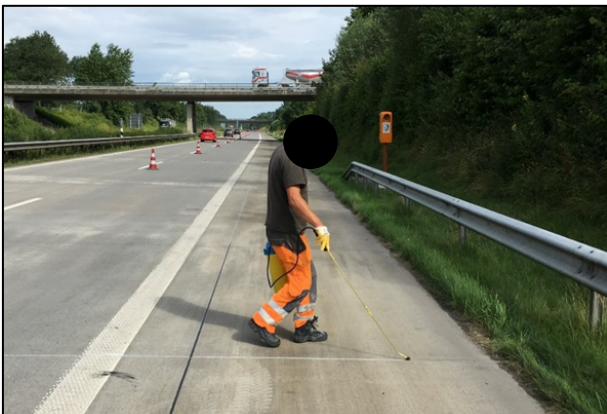
Bild 229: Applizieren des Voranstrichs
