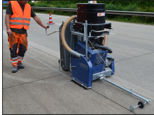
Bild 224: Nachschneiden der Längsscheinfugen
