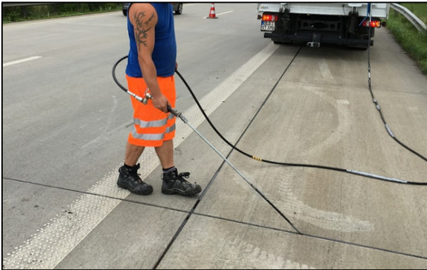
Bild 230: Einbau kalt verarbeitbare Fugenmasse (FM7)
