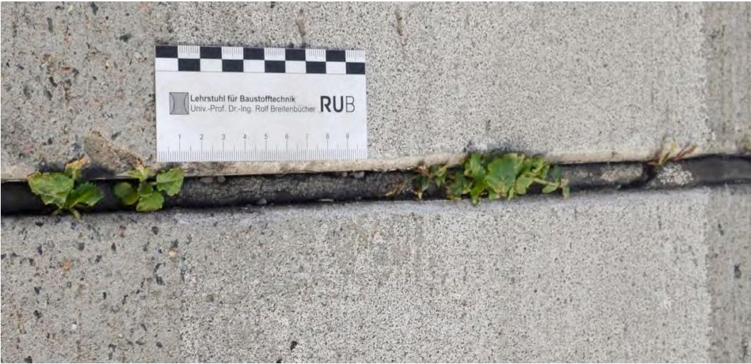
Bild 214: Grasbewuchs an den Fugenflanken (A24)
