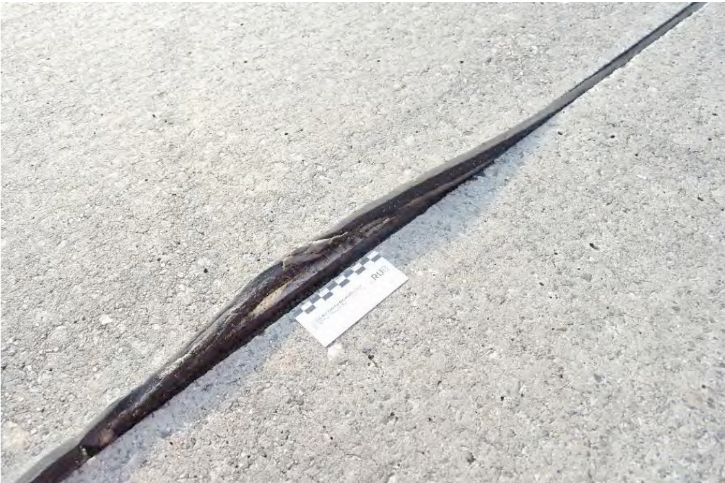
Bild 215: Flankenablösung (A24)
