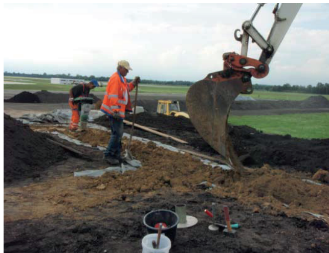
Abbildung 4.11: Einbau und Verdichtung der Dichtwände aus Ton
