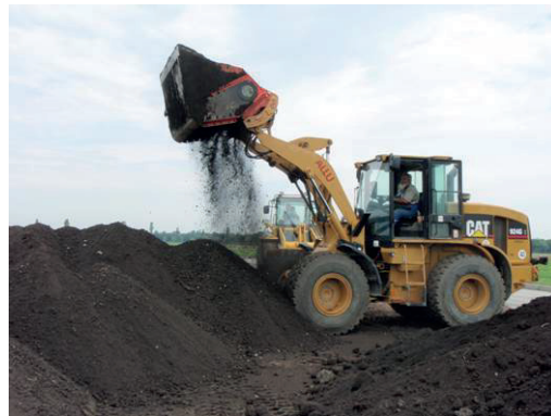
Abbildung 4.6: Homogenisieren des organischen Kernmaterials
