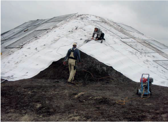
Abbildung 4.12: Verlegen der oberen Dränmatte
