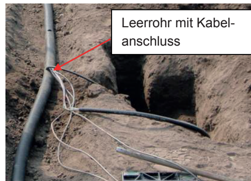
Abbildung 4.16: Kabelanschluss
