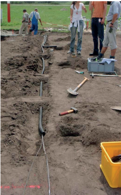
Abbildung 4.17: Verlegen der Leerrohre
