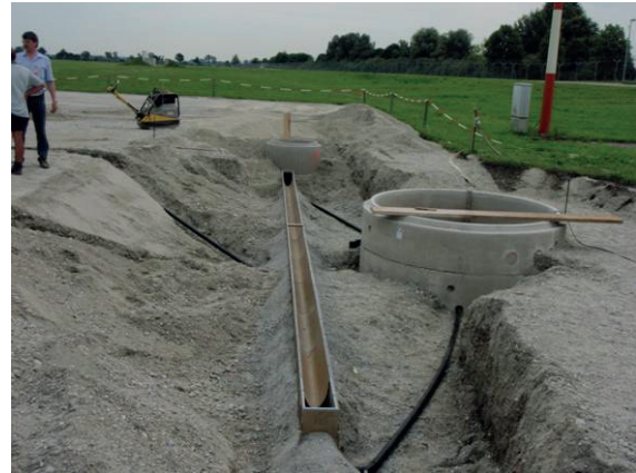
Abbildung 4.13: Rinnenkörper und Anschluss an Messschacht
