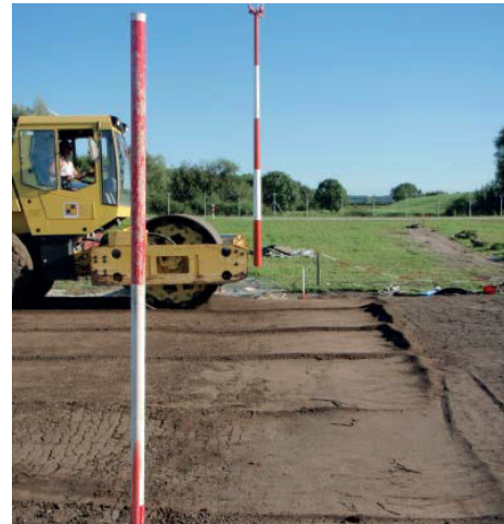
Abbildung 4.10: Glattmantelwalze
