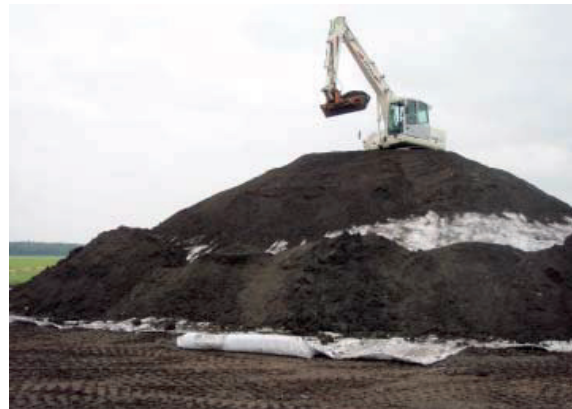
Abbildung 4.15: Aufbringen des Oberbodens
