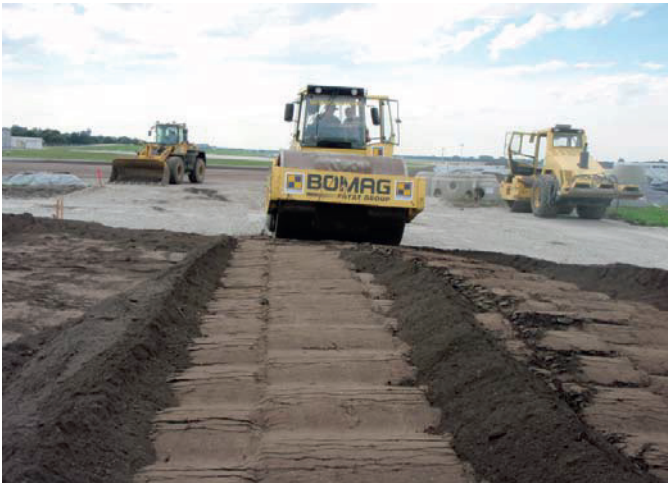
Abbildung 4.9: Polygonwalze (25t)
