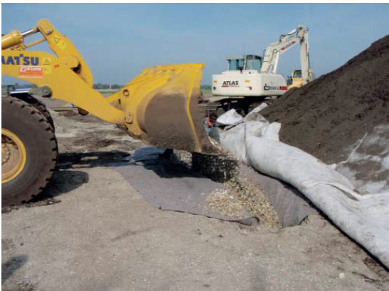
Abbildung 4.14: Herstellen der Sickerleitung
