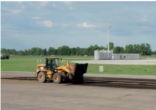
Abbildung 4.5: Ausbreiten des organischen Kernmaterials zum Trocknen
