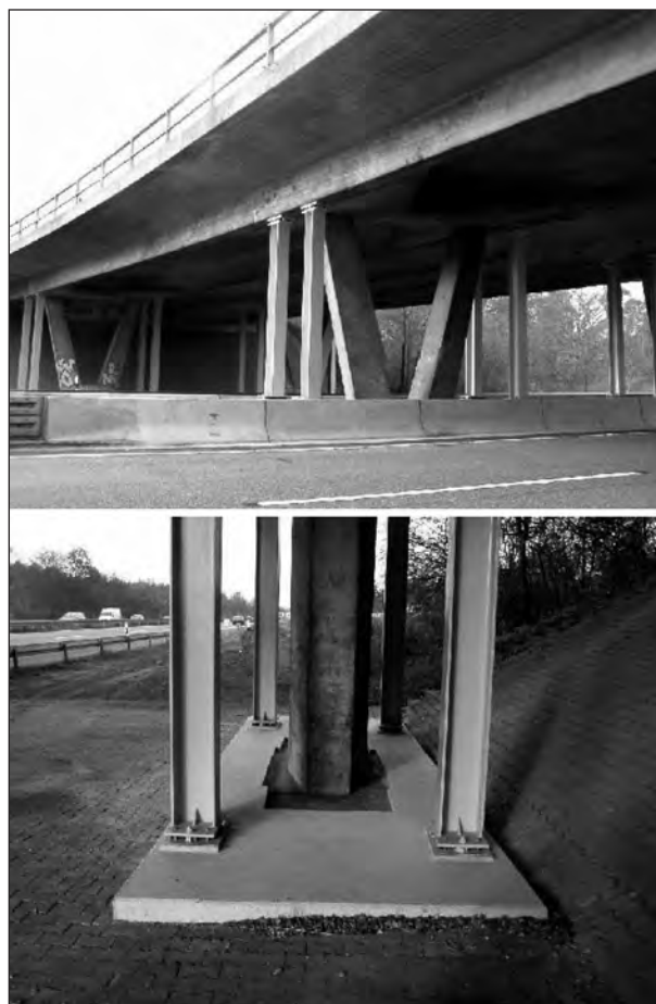
Bild 38: Provisorische Hilfsstützen zur Erhöhung der Querkrafttragfähigkeit (Kmi07)
