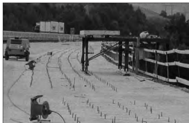
Bild 10: Dübelanordnung Donnergrabenbrücke (Bra06)
