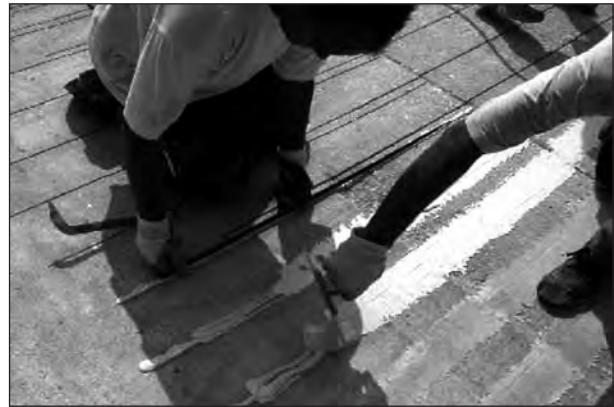
Bild 24: Einkleben der CFK-Lamellen (WeEn05)
