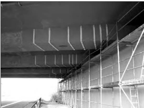
Bild 21: Verstärkung mit Stahl-Schubwinkeln (Kmi07)
