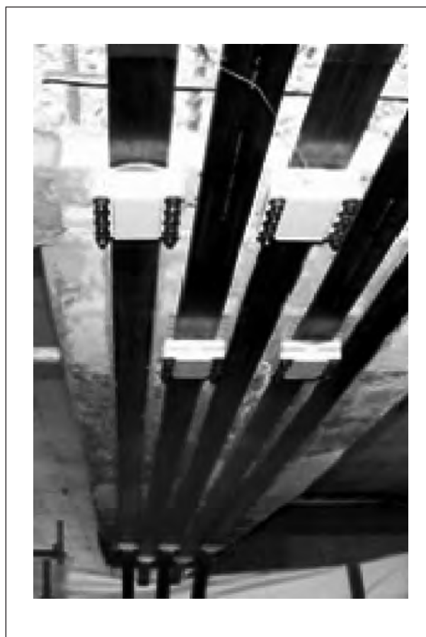
Bild 26: Vorgespannte CFK-Lamellen mit Lamellenverankerung – System Sika LEOBA CarboDur SLC II (Sika)
