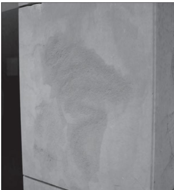
**Bild 1:** Sandsteinoberfläche, die durch unsachgemäße Graffiti-entfernung geschädigt wurde
