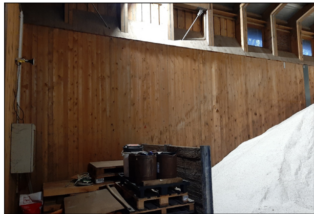
Bild 4: Beispiel einer Füllstandmessung in einer Salzhalle mit Radarsensoren (Bild: Landesbetrieb für Straßenbau Saarland)
