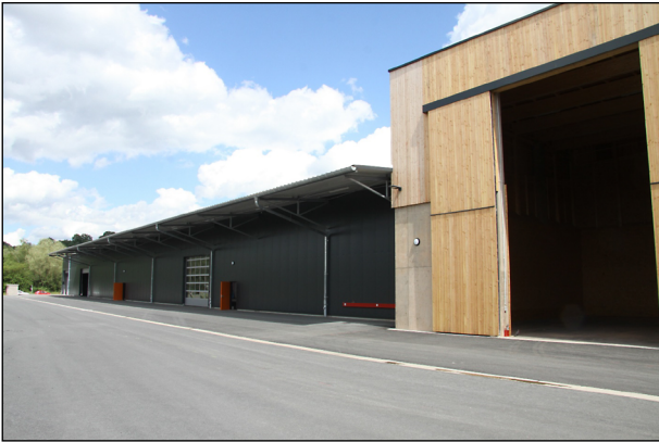
Bild 43: SM Merzig, Gesamtansicht des Gebäudekomplexes mit integrierter Streustoffhalle rechts (Bild: Cypra)
