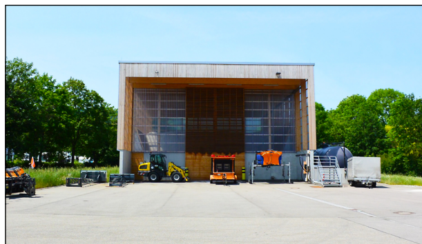
Bild 41: Streustoffhalle SM Geislingen, Außenansicht Frontseite (Bild: Pape)
