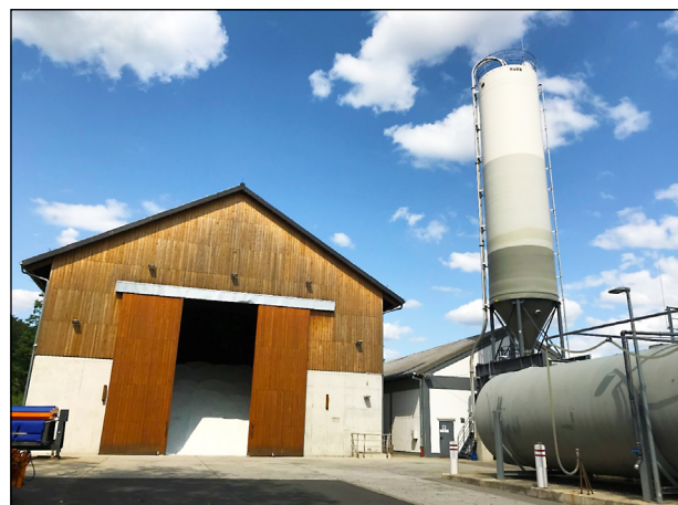
Bild 39: Streustoffhalle mit Verladeseilo aus GFK der AM Reiskirchen (Bild: Holldorb)
