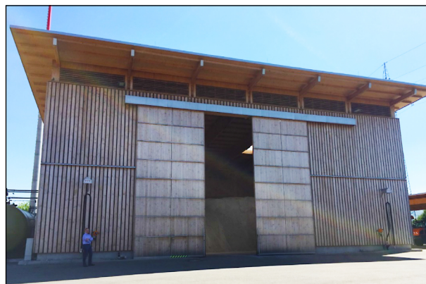
Bild 35: Streustoffhalle AM Kirchheim/Teck, Außenansicht (Bild: Holldorb)
