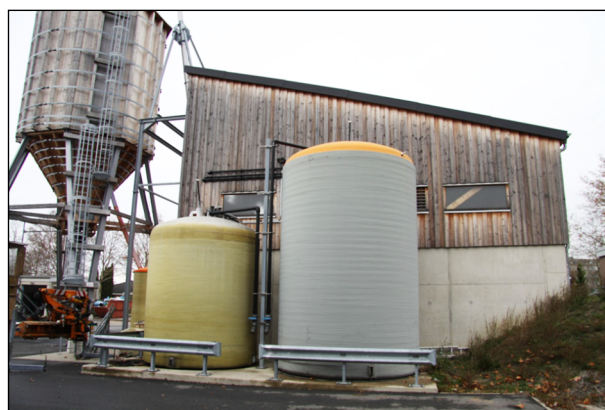
Bild 1: Tanks zur Solelagerung (Bild: Cypra)
