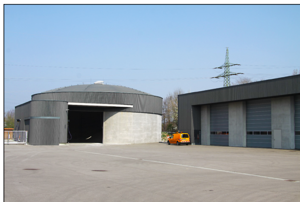
Bild 45: Gesamtansicht der Rundhalle mit Umfahrung der AM Efringen-Kirchen (Bild: Cypra)
