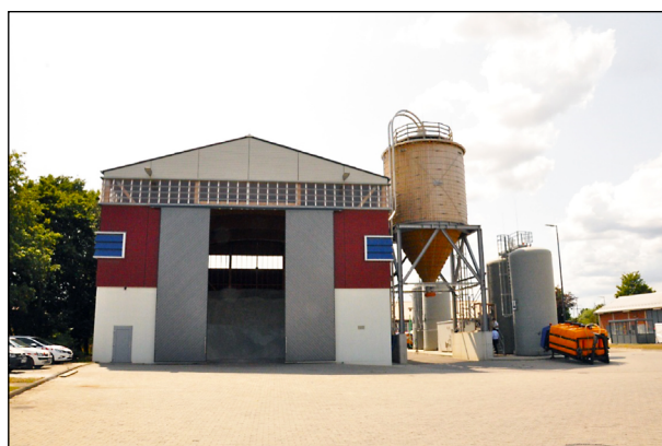
Bild 38: Streustoffhalle mit Verladesilo und Soletanks der SAM Frankfurt (Bild: Pape)
