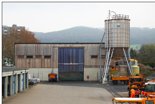
Bild 37: Gesamtansicht der Streustoffhalle mit Verladesilo und Salzlöseanlage der SM Northeim (Bild: Cypra)
