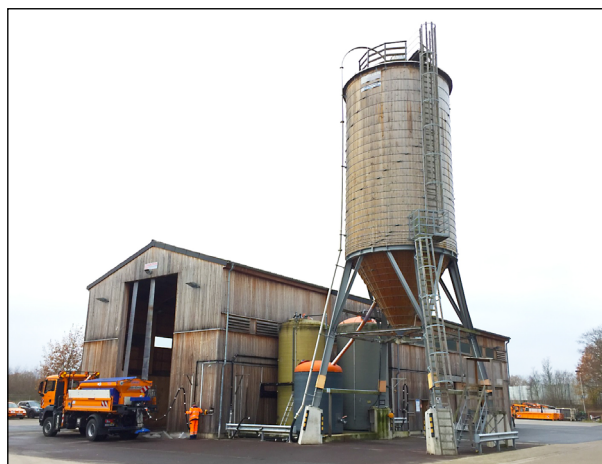
Bild 36: AM Hannover: Gesamtansicht der Streustoffhalle mit Verladesilo und Salzlöseanlage (Bild: Cypra)
