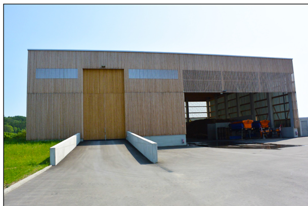
Bild 42: Streustoffhalle SM Münsingen, kombinierte Halle für die Lagerung von Streusalz (links) und Holzhackschnitzeln (rechts) (Bild: Pape)
