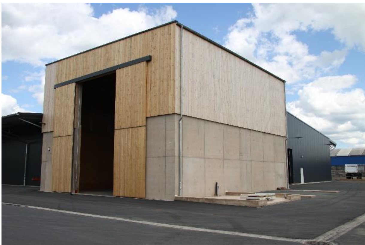
Streustoffhalle SAM Merzig, Streustoffhalle mit Schiebetoren sowie vorbereitete Fläche für die Salzlöseanlage (Bild: Cypra)
