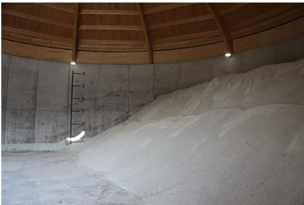
Streustoffhalle AM Efringen-Kirchen: Lagerung Trockensalz (Bild: Cypra)
