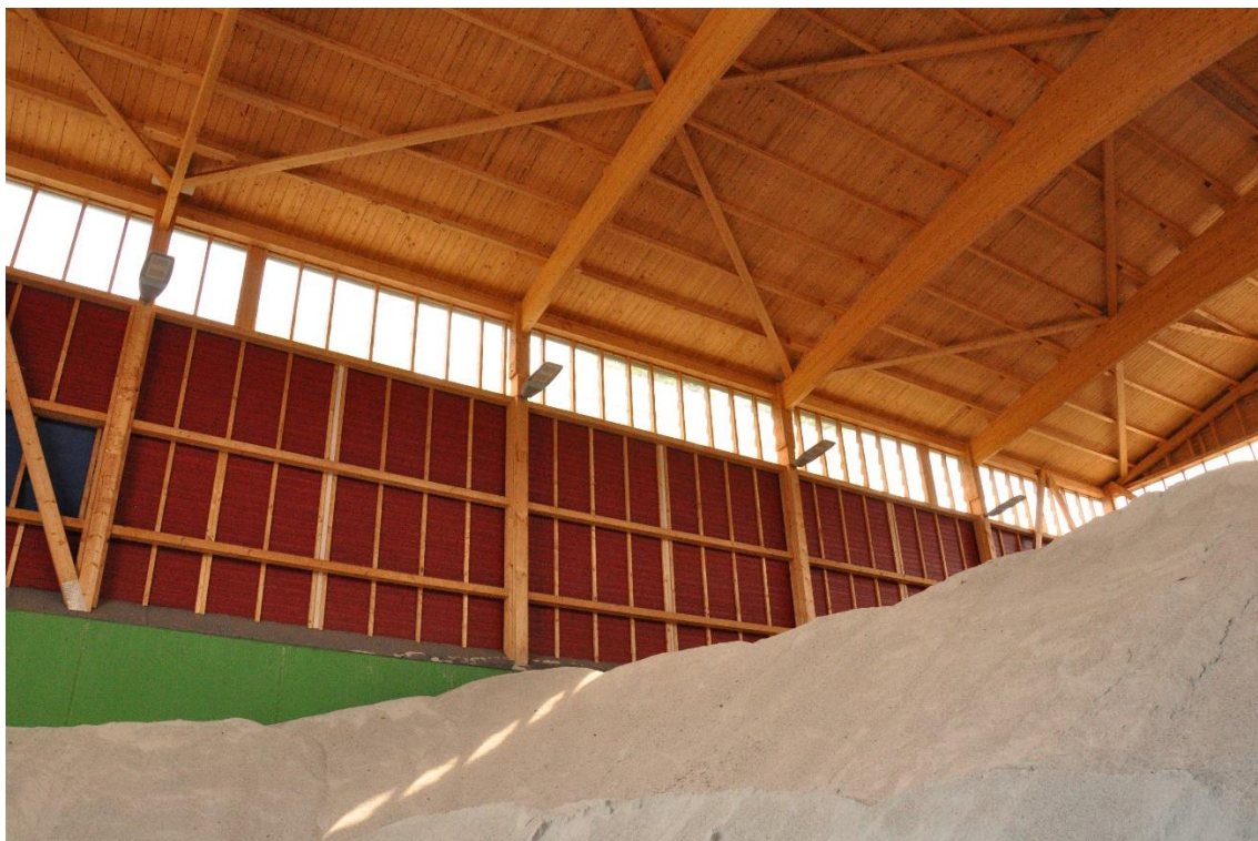
Streustoffhalle SAM Frankfurt: Innenansicht mit Betonwand und darüber liegender Holzkonstruktion (Bild: Pape)
