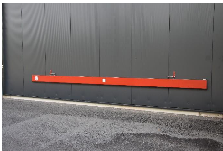
Streustoffhalle SAM Merzig, Sperreinrichtung zum Rückhalten von salzhaltigem Löschwasser im Falle eines Hallenbrandes (Bilder: Cypra)
