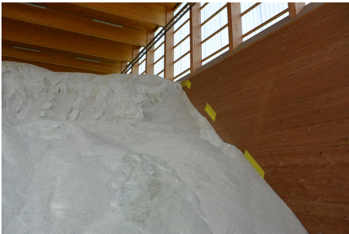
Streustoffhalle SM Geislingen, Innenansicht Holzseitenwand mit Markierung des Schüttbereichs (Bild: Pape)
