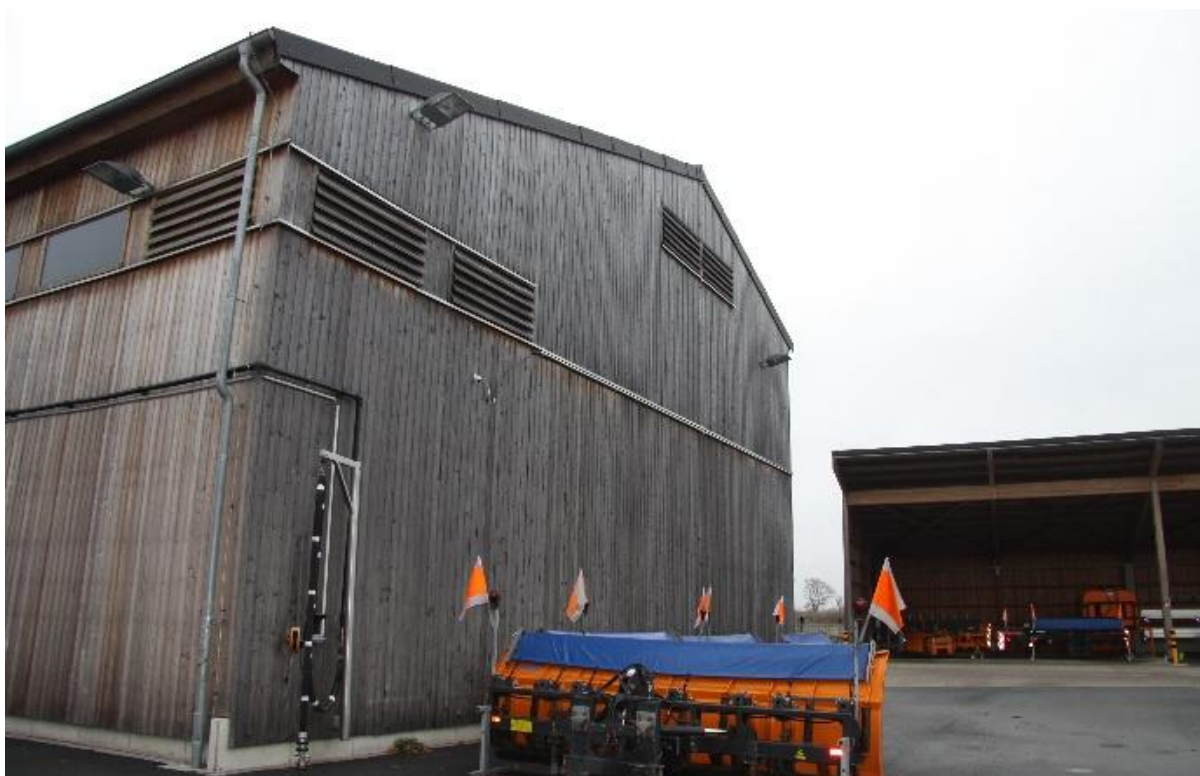
Streustoffhalle AM Hannover: Solezapfstelle im rückwärtigen Hallenbereich (Bild: Cypra)
