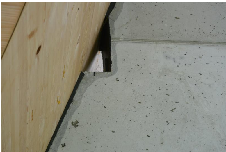
Streustoffhalle SM Geislingen, Lagerung der Dachkonstruktion und der Holzseitenwände auf Betonquerrippen und (Bilder: Pape)
