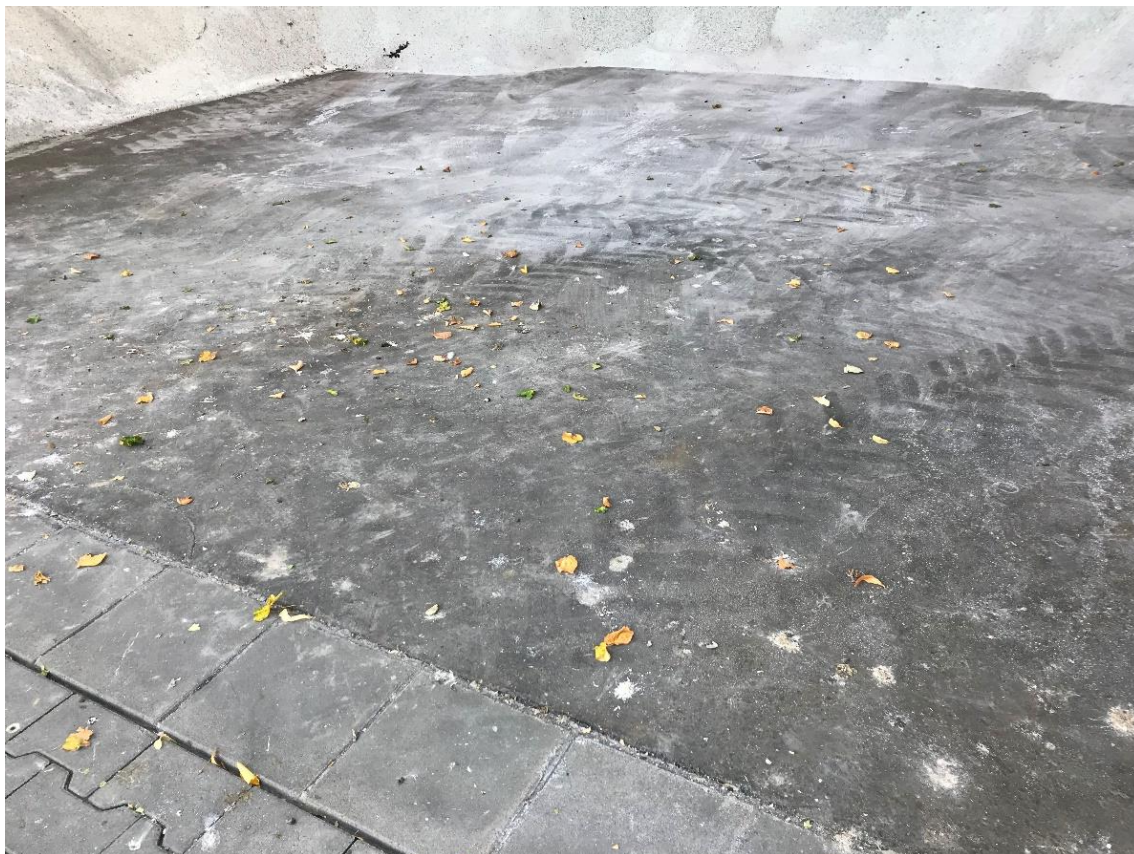
Streustoffhalle SAM Frankfurt: Hallenboden aus Gussasphalt (Bild: Holldorb)
