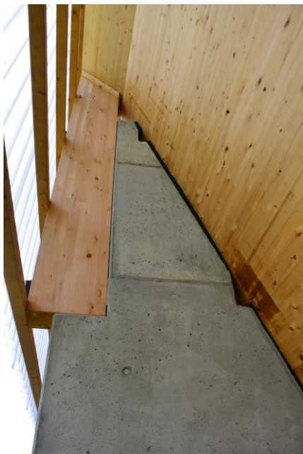
Streustoffhalle SM Geislingen, Lagerung der Dachkonstruktion und der Holzseitenwände auf Betonquerrippen und (Bilder: Pape)
