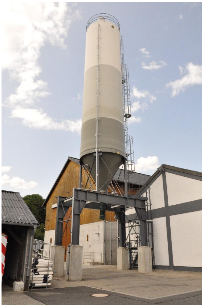
Streustoffhalle AM Reiskirchen: Verladesilo aus GFK auf Stahlunterbau (Bild: Pape)
