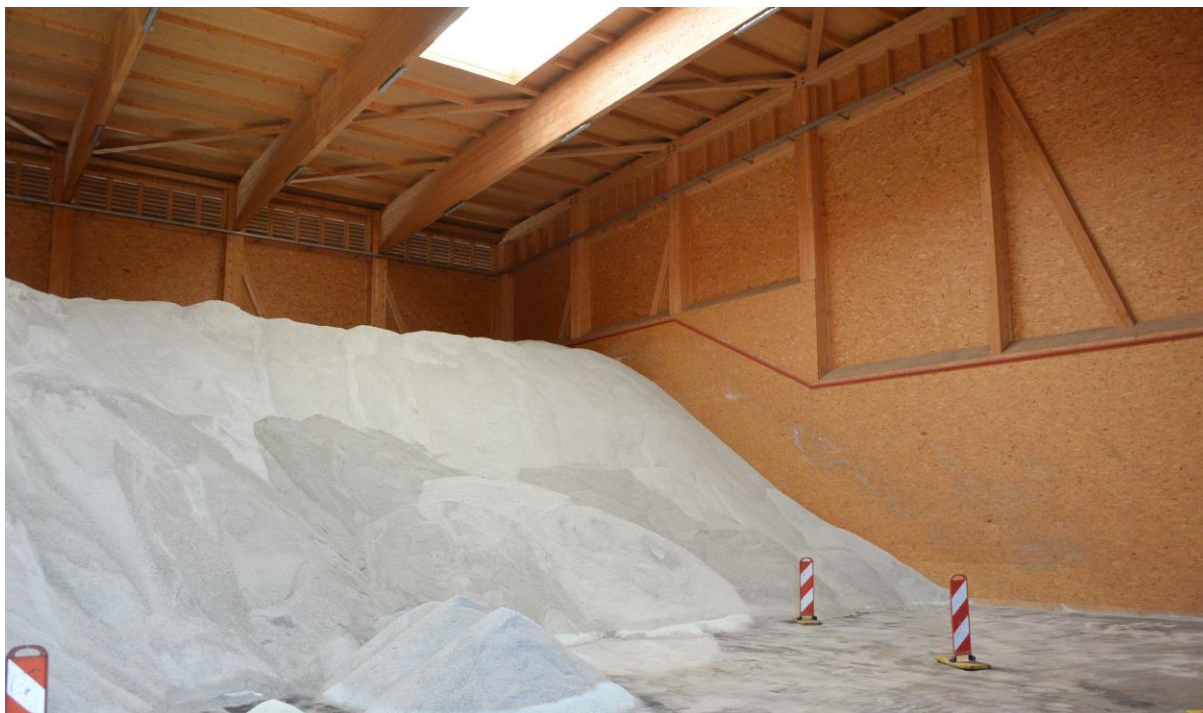
Streustoffhalle AM Kirchheim/Teck, Innenansicht mit Markierung der zulässigen Schütthöhe (Bild: Pape)
