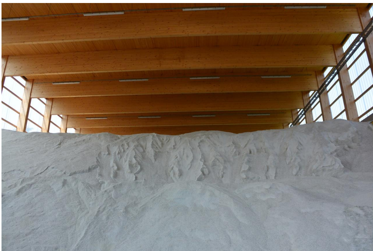
Streustoffhalle SM Geislingen, Binder der Dachkonstruktion (Bild: Pape)
