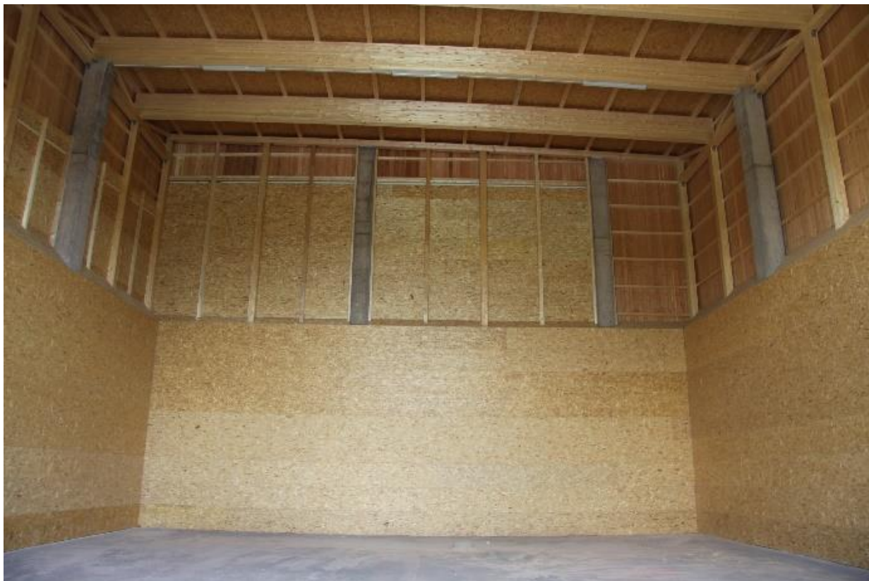
Streustoffhalle SAM Merzig, Innenansicht der neuen Streustoffhalle (Bild: Cypra)
