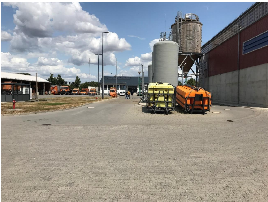
Streustoffhalle SAM Frankfurt: Verladesilo und Soletanks neben der Streustoffhalle (Bild: Holldorb)
