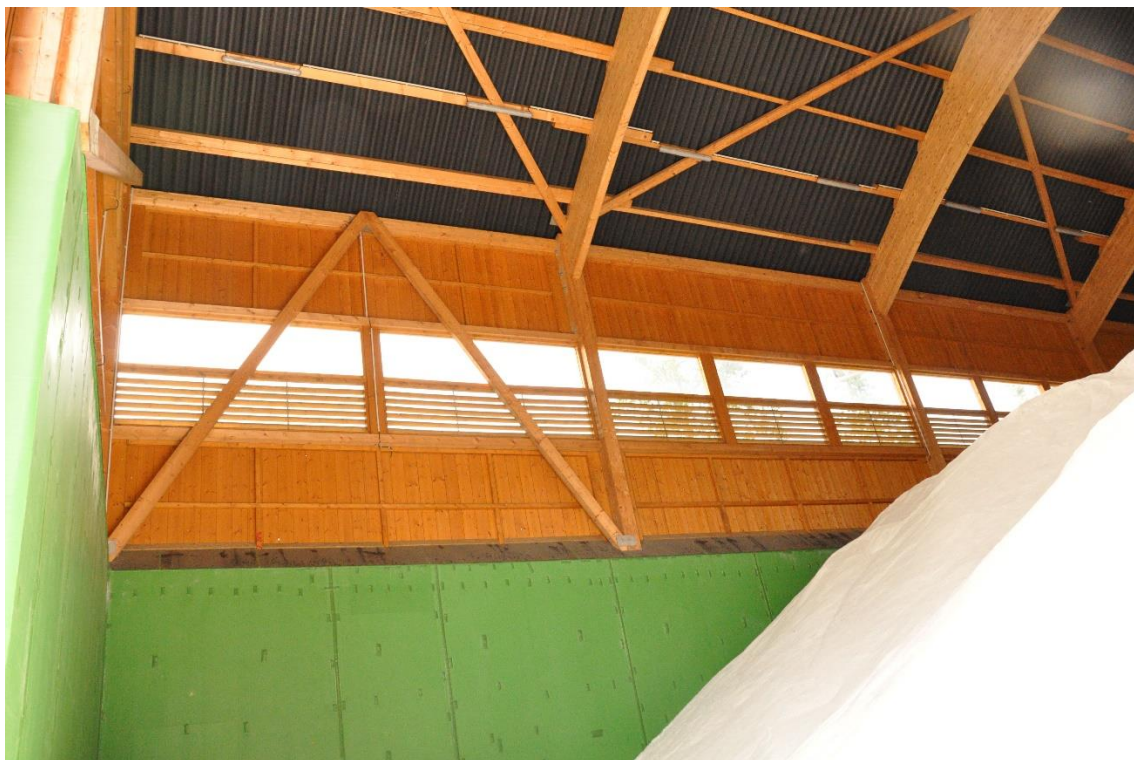
Streustoffhalle AM Reiskirchen: Innenansicht der gefüllten Streustoffhalle (Bild: Pape)
