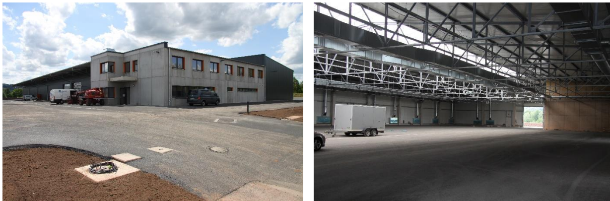
SAM Merzig, Gesamtansicht des Gebäudekomplexes mit Verwaltung und Innenansicht der Fahrzeug- und Gerätehalle (Blick Richtung Halleneinfahrt) (Bilder: Cypra)
