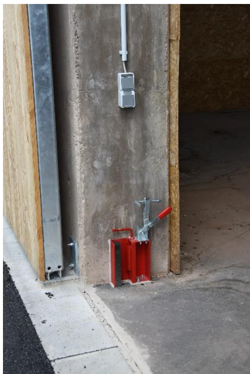
Streustoffhalle SAM Merzig, Sperreinrichtung zum Rückhalten von salzhaltigem Löschwasser im Falle eines Hallenbrandes (Bilder: Cypra)
