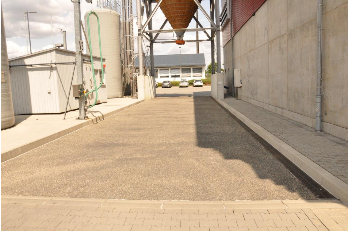
Streustoffhalle SAM Frankfurt: Verkehrsfläche im Bereich Solebetankung und Verladesilo (Bild: Pape)
