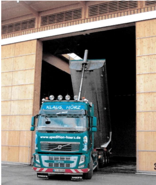
Streustoffhalle AM Kirchheim/Teck, Hallentor mit Durchfahrtshöhe von 9,20 m und Detail der Tor-aufhängung (Bilder: AM Kirchheim/Teck)
