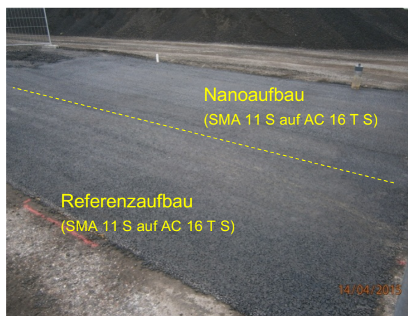
Bild 7.4 Fertiggestellte Demonstratorfläche
