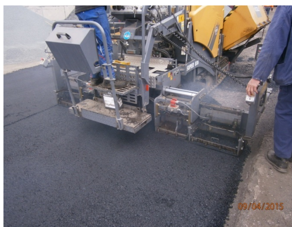
Bild 7.3 Einbau der nanomodifizierten Asphalttragschicht AC 16 T S
