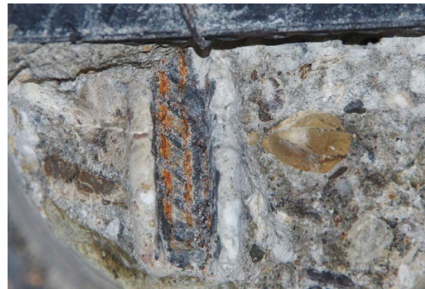
Bild 4: Stelle BK 8 in Teilflächen angerostet
