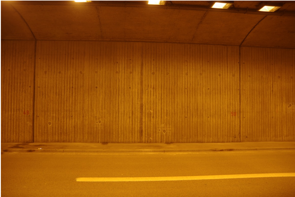
Bild 3 Block 50, westliche Wand
