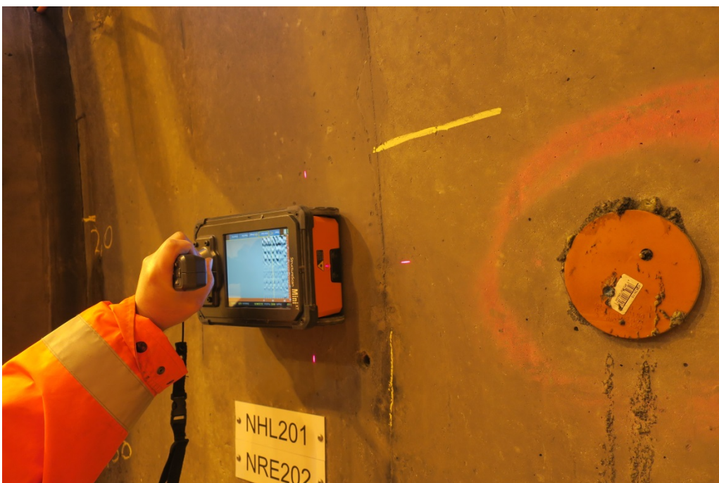
Bild 16 Bewehrungsortung mit Radar
