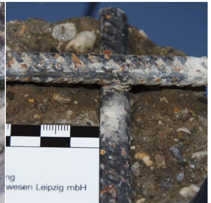
Bild 3: Stelle BK 4 stellenweise angerostet
