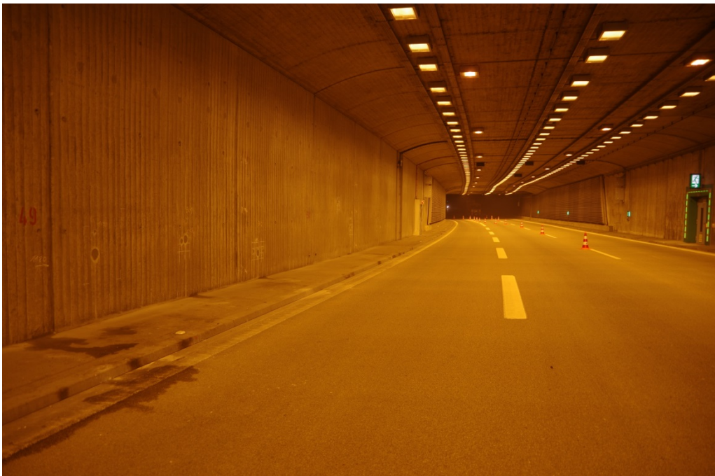
Bild 2 Tunnel Prüfening, Einfahrtbereich der Weströhre mit Lärmschutzelementen (im Bildhintergrund)
