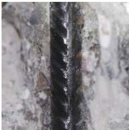
Bild 10: Stelle K 3 ohne Korrosion
