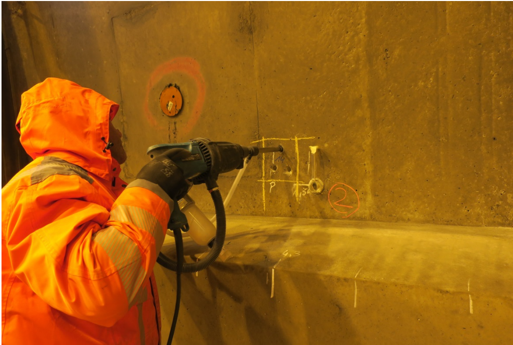
Bild 13 Bohrmehlentnahme mit Entnahmeggerät
