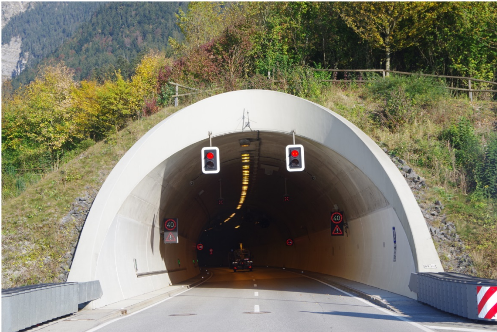
Bild 1 Tunnel Farchant, Einfahrt Oströhre
