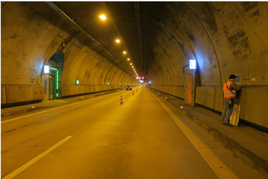
Bild 2 Tunnel Pfaffenstein, Innenansicht Oströhre
