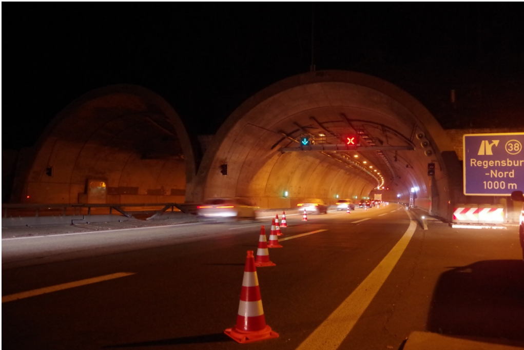
Bild 1 Tunnel Pfaffenstein, Einfahrt Oströhre
