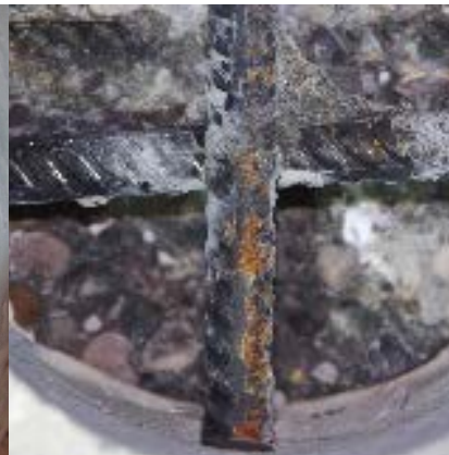
Bild 2: Stelle BK 3 in Teilflächen angerostet
