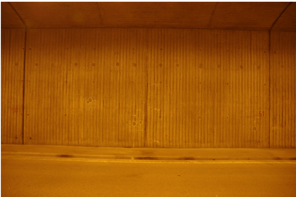
Bild 4 Block 51, westliche Wand
