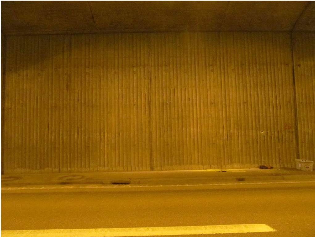
Bild 7 Block 24, westliche Wand
