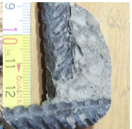
Bild 12: Stelle BK 6 ohne Korrosion
