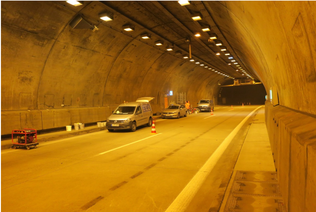
Bild 3 Tunnel Pfaffenstein, Untersuchungsbereich an der östlichen Wand
