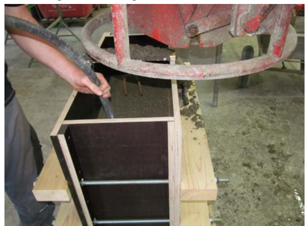
Abbildung 10: Verdichtung
