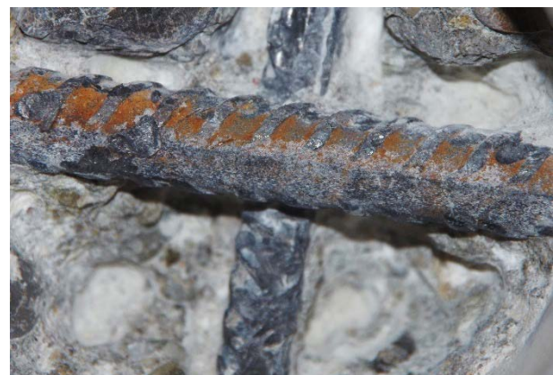
Bild 2: Stelle BK 6 in Teilflächen angerostet
