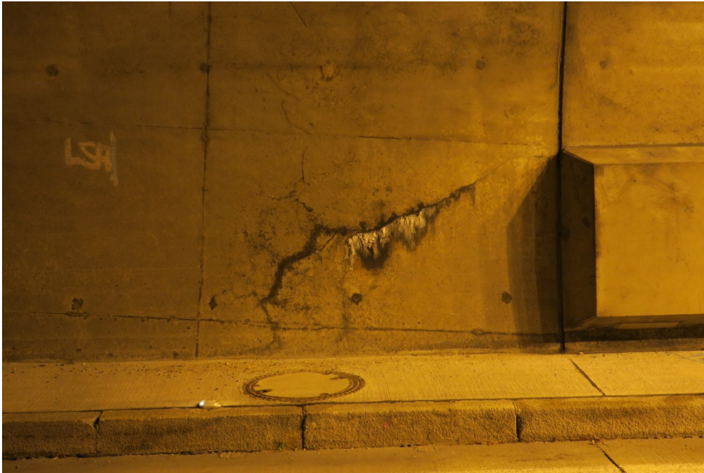
Bild 11 Schrägriss mit Aussinterungen, Block 82
