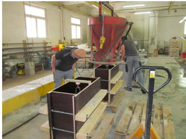
Abbildung 18 – Betonage PK 3
