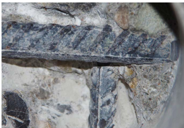
Bild 1: Stelle BK 5 ohne Korrosion
