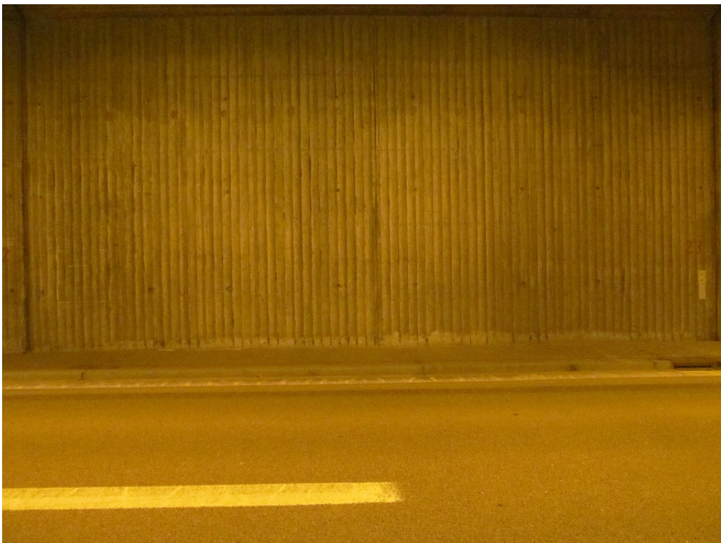
Bild 6 Block 23, westliche Wand
