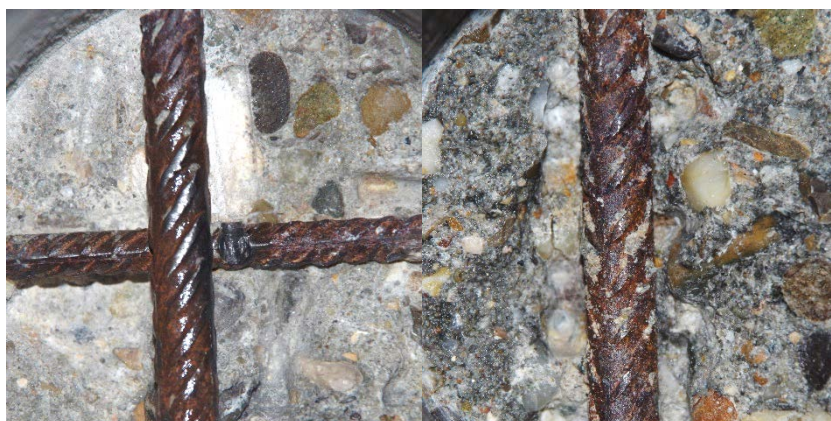
Bild 6: Stelle BK 7 flächig angerostet
