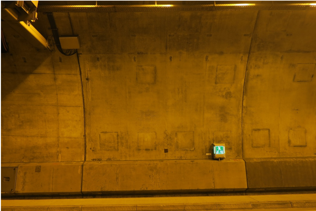
Bild 7 Tunnelschale Block 81, Westseite
