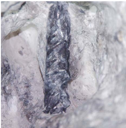
Bild 7: Stelle K 4 ohne Korrosion
