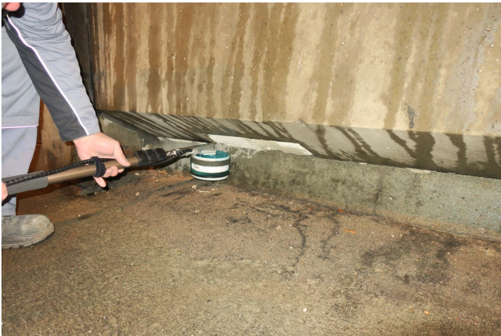
Bild 14 Potentialmessung unterhalb des Leitungskanals
