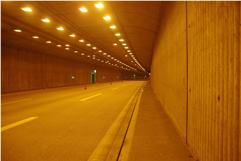
Bild 1 Tunnel Prüfening, Innenansicht Weströhre
