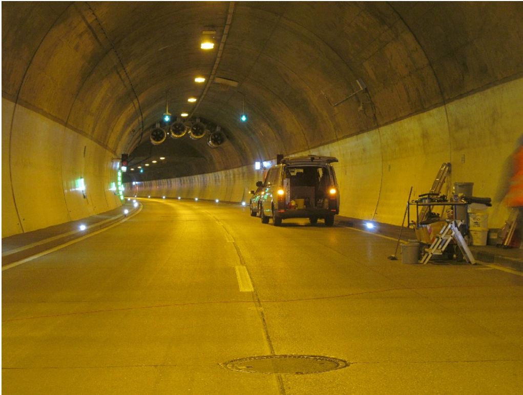
Bild 3 Tunnel Farchant, Ulmenbereich mit Beschichtung
