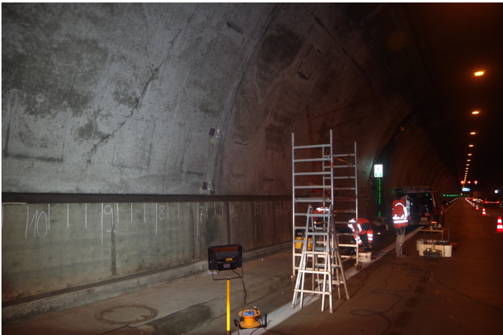
Bild 4 Tunnel Pfaffenstein, Untersuchungsbereich an der westlichen Wand
