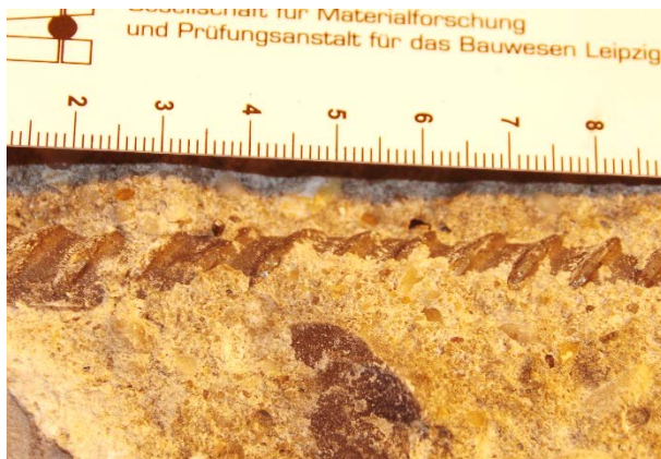
Bild 7: Stelle BK 3 ohne Korrosion
