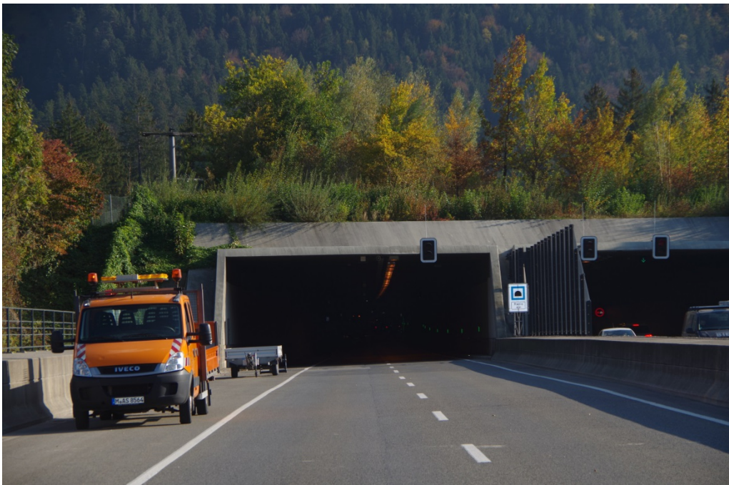
Bild 2 Tunnel Farchant, Ausfahrt Oströhre
