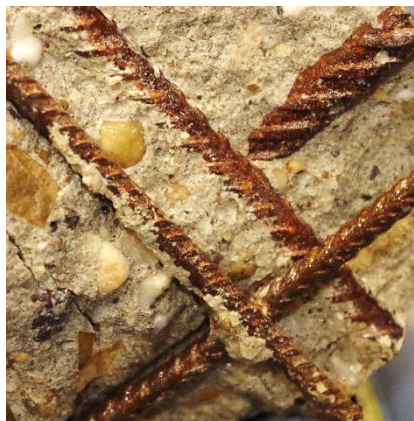
Bild 9: Stelle BK 1 flächig angerostet
