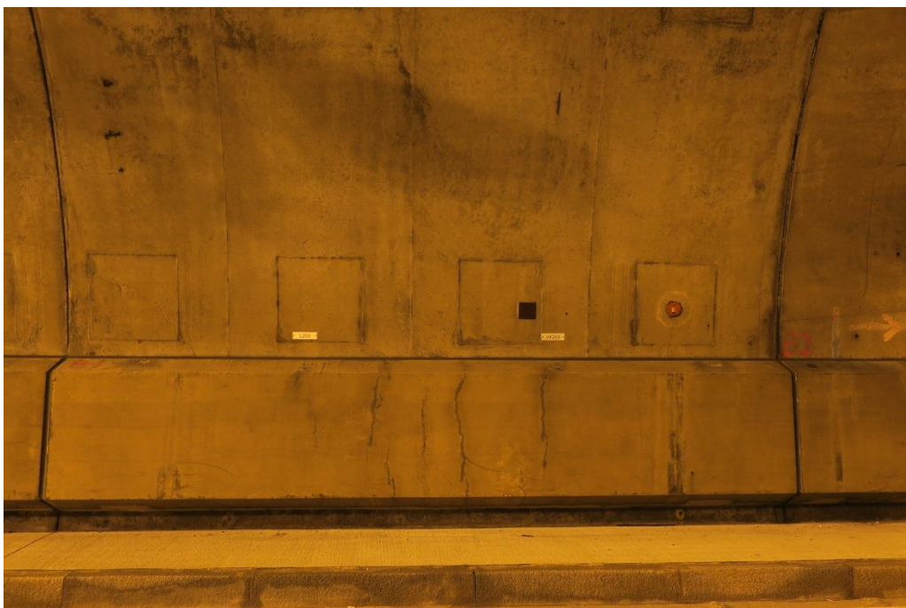
Bild 6 Tunnelschale Block 81, Ostseite
