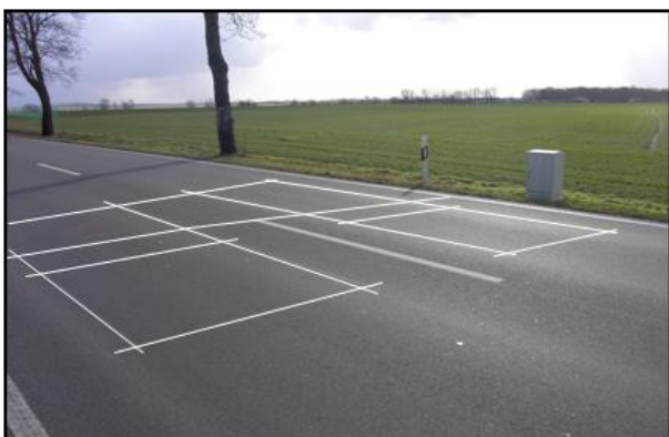
Bild 5: Querschnitt mit Doppelinduktionsschleifen
