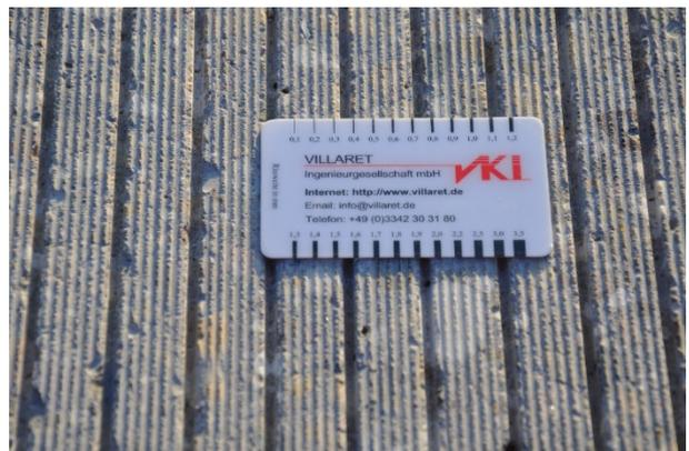
**Abbildung 311:** Grindingtextur auf der A 5, Testfeld VI-2
