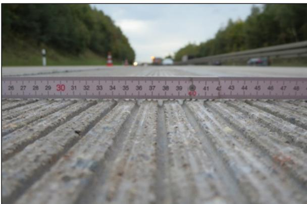
**Abbildung 26:** Grindingtextur nach zweitem Schneidvorgang auf der A 93
