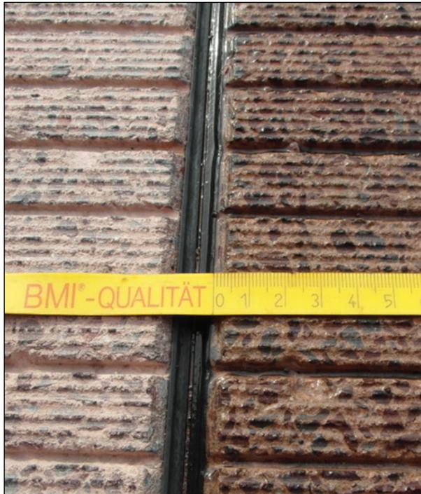
**Abbildung 92:** Querfuge auf Testfeld 1.1 der Erprobungsstrecke auf der BAB A 12 zum Zeitpunkt der Kontrollierten Vorbeifahrtmessungen.
