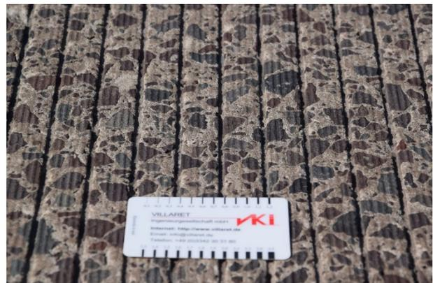
**Abbildung 227:** Grindingtextur auf der A 12, Testfeld 1.3
