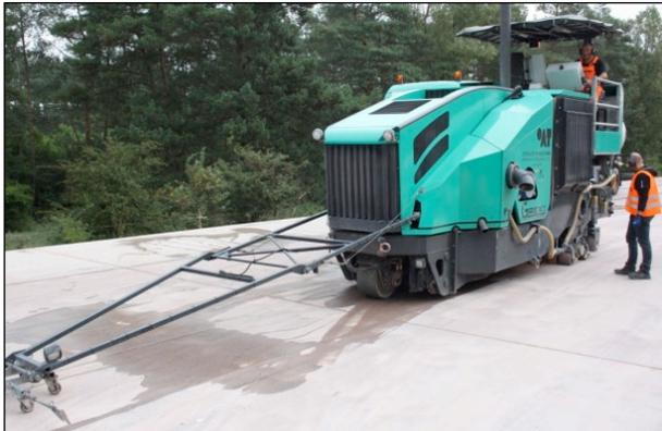
**Abbildung 217:** Grinding auf der Erprobungsstrecke A 12
