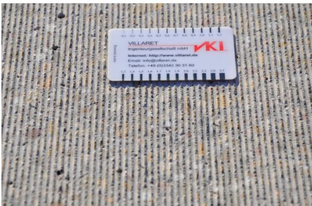
**Abbildung 325:** Grindingtextur auf der A 5, Testfeld VIII-3
