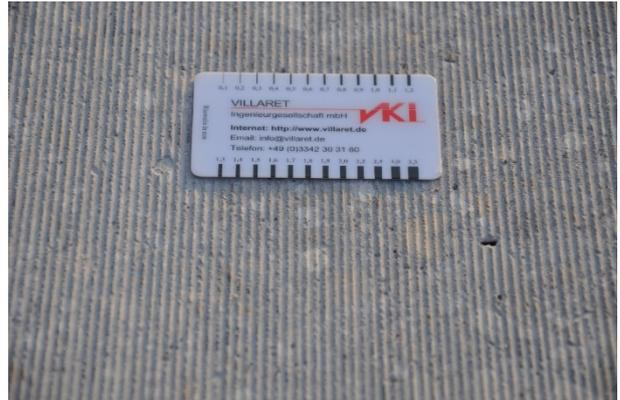
**Abbildung 309:** Grindingtextur auf der A 5, Testfeld VI-1
