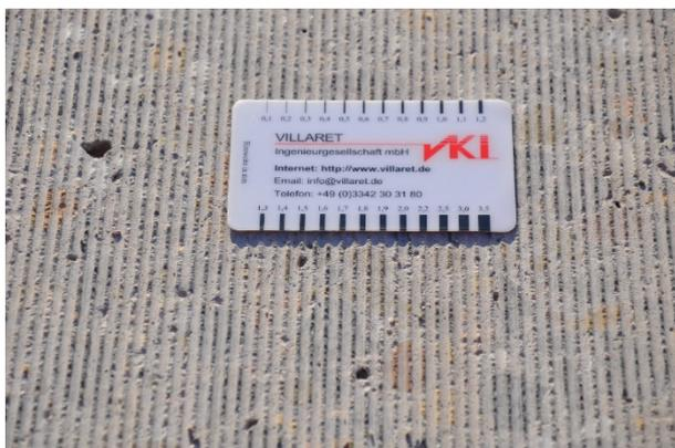
**Abbildung 315:** Grindingtextur auf der A 5, Testfeld VII-3
