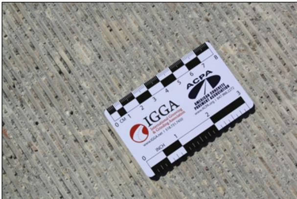
**Abbildung 5:** Betonoberfläche unmittelbar nach dem Grindingvorgang
