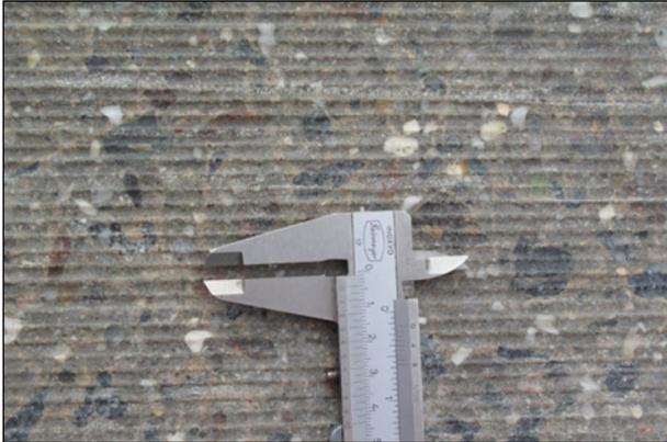
**Abbildung 24:** Grindingtextur nach erstem Schneidvorgang auf der A 93
