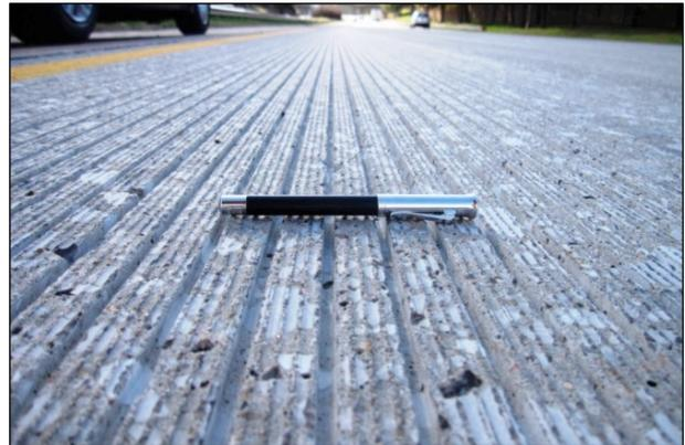
**Abbildung 10:** Textur Grinding und Grooving
