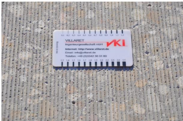
**Abbildung 313:** Grindingtextur auf der A 5, Testfeld VI-3
