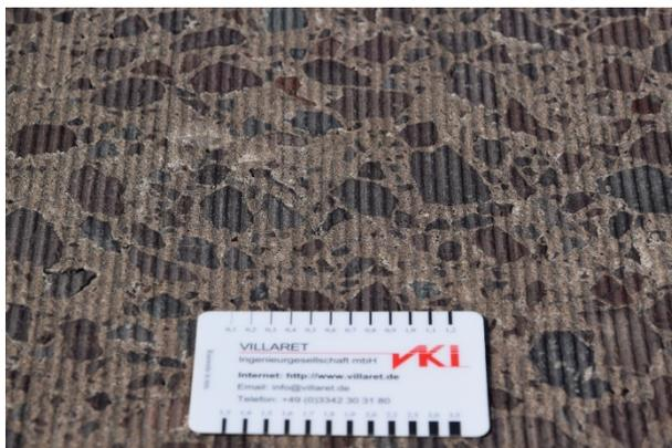
**Abbildung 225:** Grindingtextur auf der A 12, Testfeld 1.2
