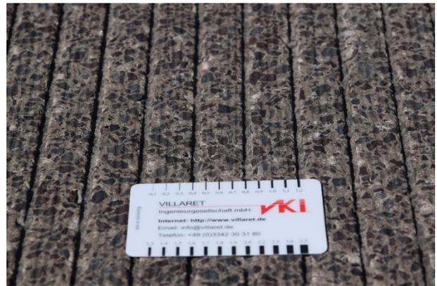
**Abbildung 239:** Grindingtextur auf der A 12, Testfeld 3.3
