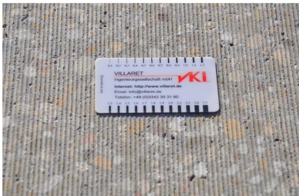
**Abbildung 321:** Grindingtextur auf der A 5, Testfeld VIII-1
