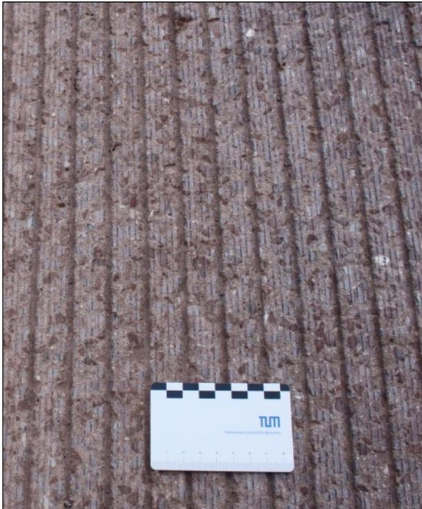
**Abbildung 220:** Kornausbrüche entlang der Groovingrillen am Beispiel des Waschbetons mit Ausfallkörnung und Textur 3
