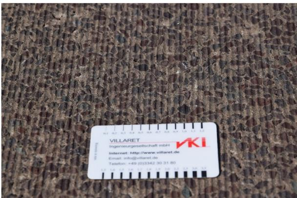
Abbildung 231: Grindingtextur auf der A 12, Testfeld 2.2
