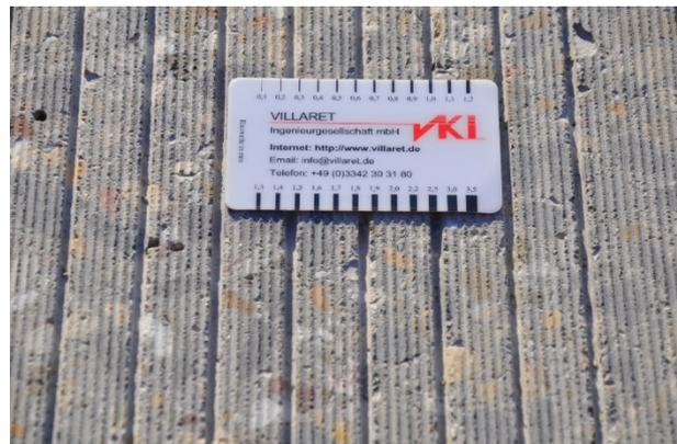
**Abbildung 317:** Grindingtextur auf der A 5, Testfeld VII-2
