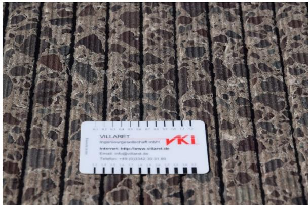
**Abbildung 223:** Grindingtextur auf der A 12, Testfeld 1.1
