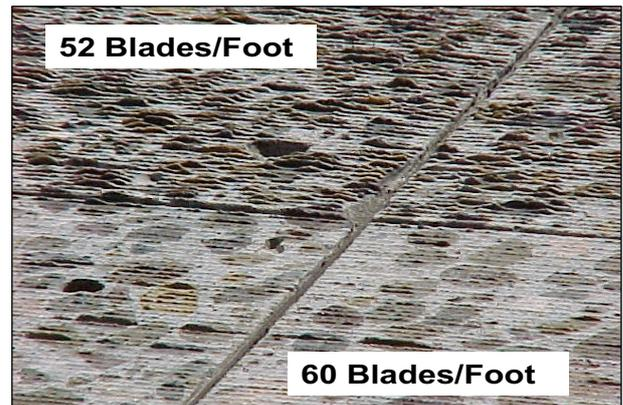
**Abbildung 6:** Einfluss der Anzahl an Schneidscheiben auf die sich ergebende Grindingoberfläche
