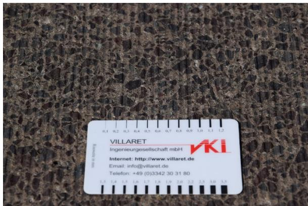
**Abbildung 237:** Grindingtextur auf der A 12, Testfeld 3.2
