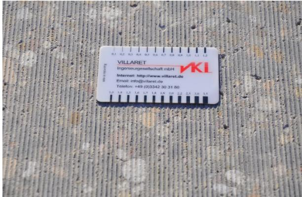
**Abbildung 319:** Grindingtextur auf der A 5, Testfeld VII-1
