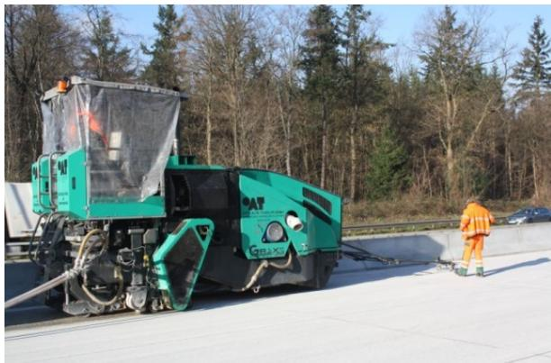
**Abbildung 302:** Grinding auf der Erprobungsstrecke A 5
