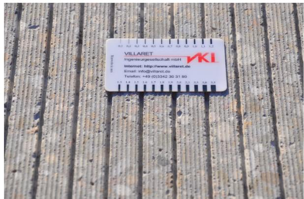
**Abbildung 323:** Grindingtextur auf der A 5, Testfeld VIII-2
