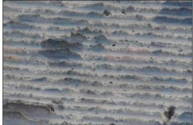
**Abbildung 17:** Konventionelle Grindingoberfläche
