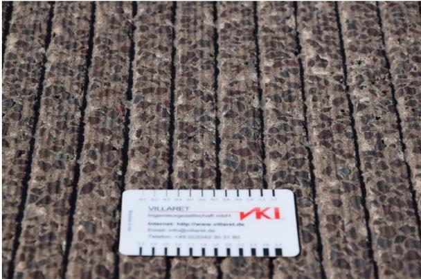
Abbildung 229: Grindingtextur auf der A 12, Testfeld 2.3
