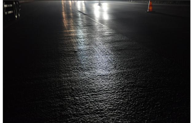
**Abbildung 30:** Unebenheiten im nachträglich angebauten Hauptfahrstreifen und Seitenstreifen A 92, RF München, km 16,7
