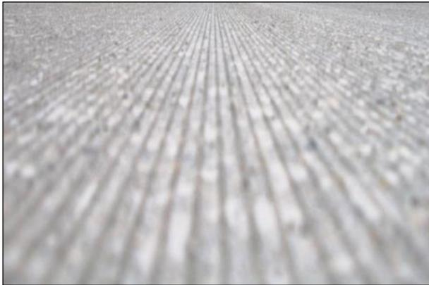
**Abbildung 11:** Oberfläche eines Texturgrindings
