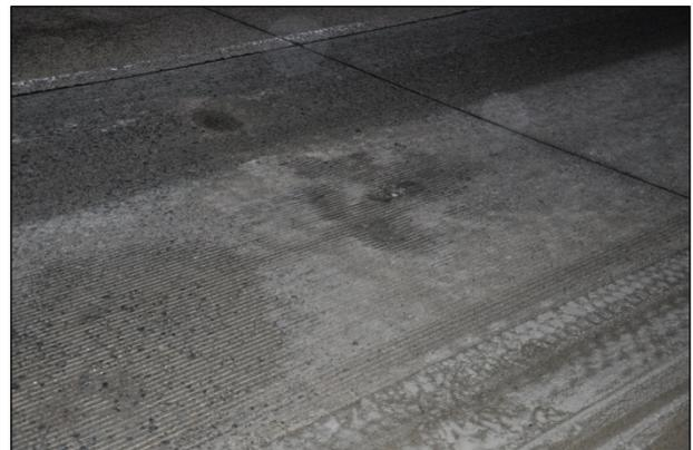
**Abbildung 31:** Unregelmäßige Textur im nachträglich angebauten Hauptfahrstreifen und Seitenstreifen A 92, RF München, km 16,7
