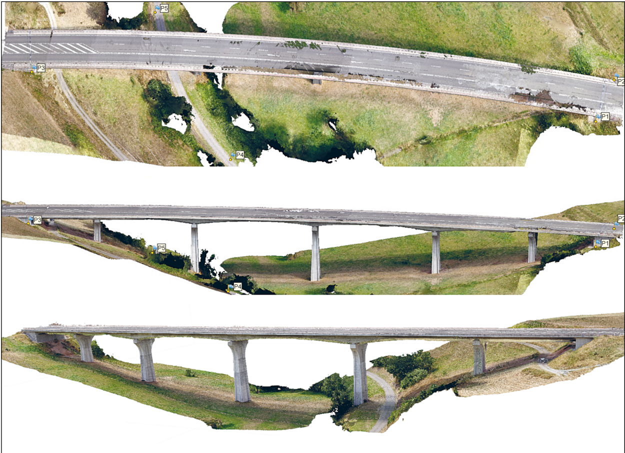
Bild 30: Grobe georeferenzierte 3D-Rekonstruktion der Körnebachtalbrücke, Draufsicht (oben), Westansicht (Mitte), Ostansicht (unten)
