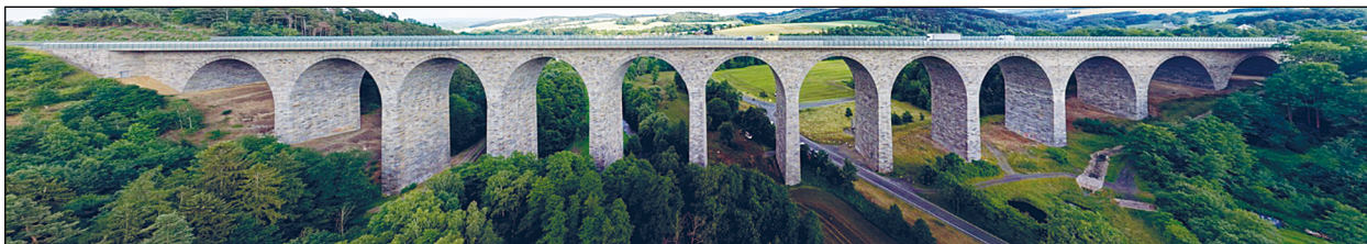
Bild 12: Elstertalbrücke bei Pirk, Nordwestansicht
