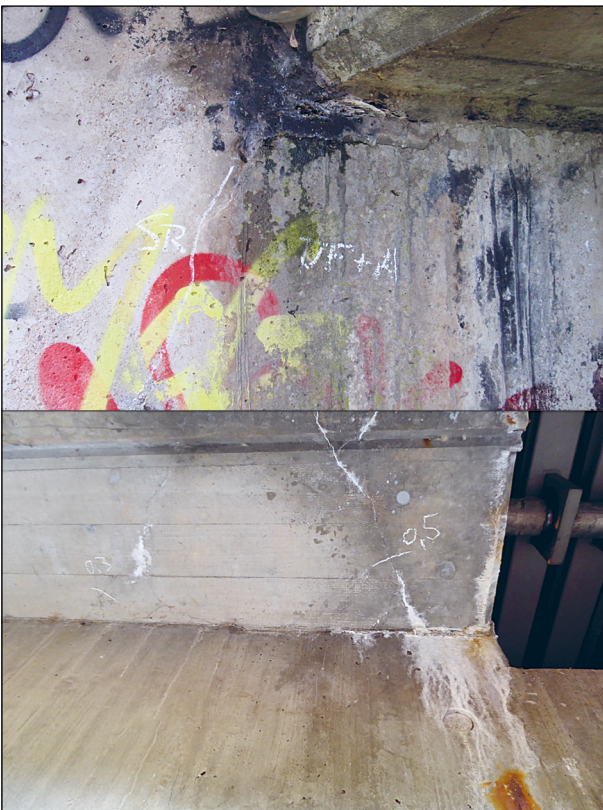
Bild 5: Beispiel typischer Störquellen – Verschmutzung, Verfärbungen und Aussinterungen [Foto: TLBV]
