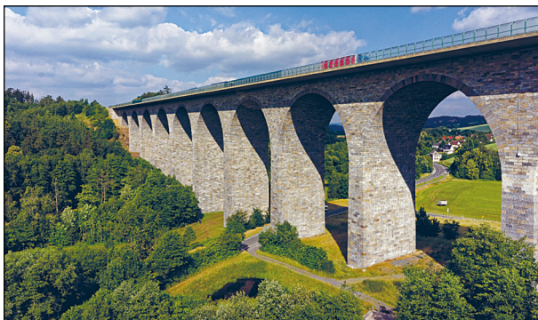
Bild 13: Beispielaufnahme aus der luftbildbasierten Aufnahme der Elstertalbrücke
