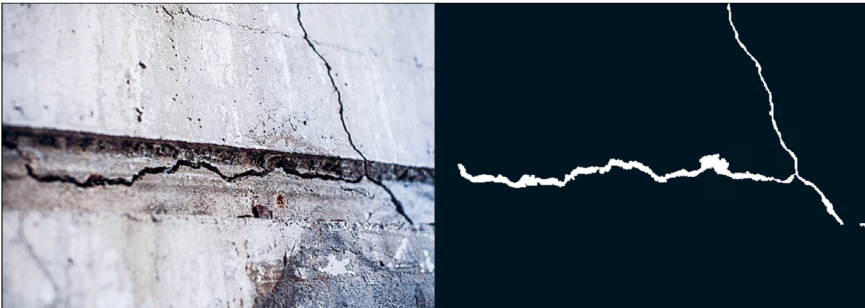
Bild 48: Beispiel aus dem DC19 Datensatz zur Pixelklassifikation mit entsprechender Annotation (Ground-Truth)
