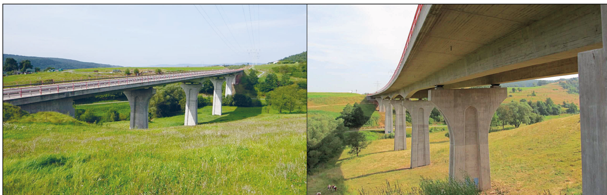
Bild 28: Körnebachtalbrücke bei Schwallungen
