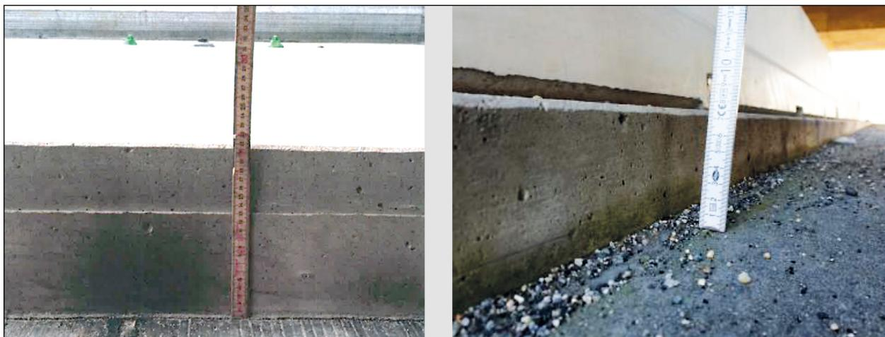
Bild 52: Vergleich der Kalibrierpunkte vor (links) und nach (rechts) Aufbringung der Abdichtung und Gussasphaltschichten (Quelle: BAST 2015 (links) und KIWA GmbH Bauconsulting 2019 (rechts))
