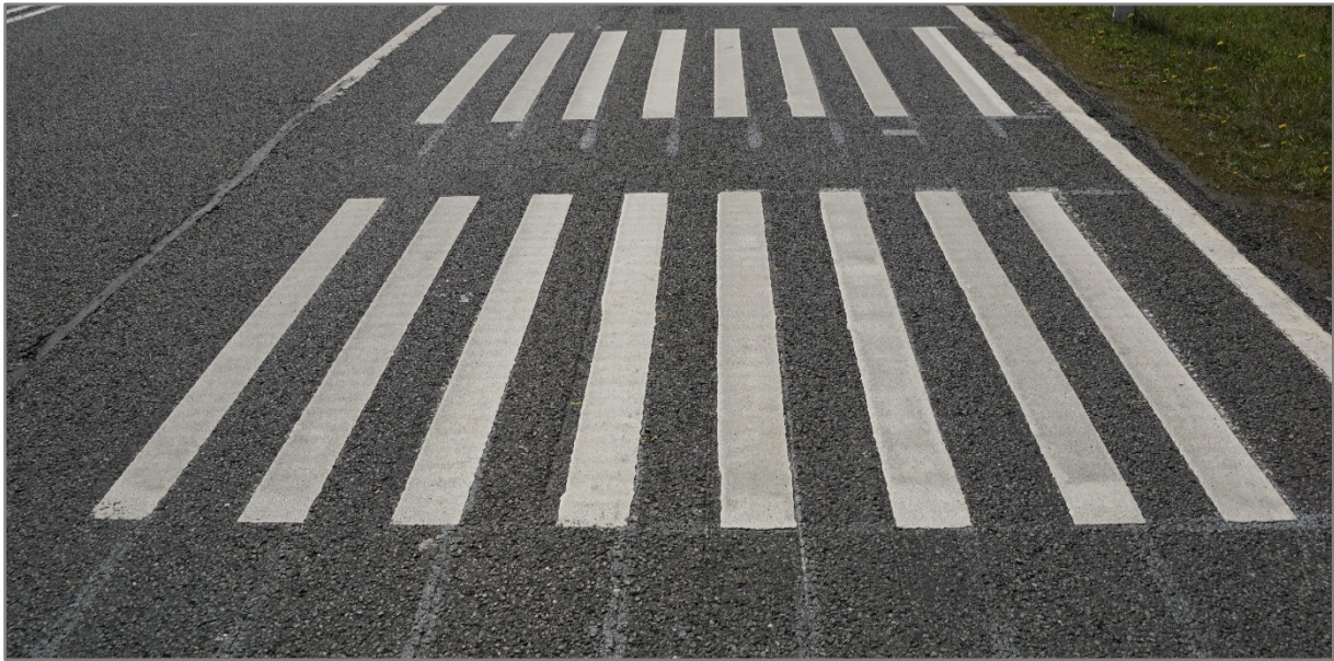
Abbildung 5: Sichtbarkeit der Vormarkierung nach einer Liegedauer von einem Jahr (links Streifen 1)
