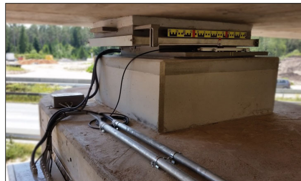
Bild 5: Eingebautes KGA 40/3 im Bauwerk
