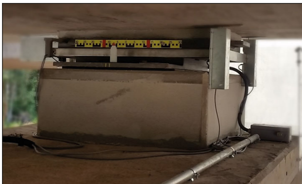
Bild 3: Eingebautes KGA 40/1 im Bauwerk
