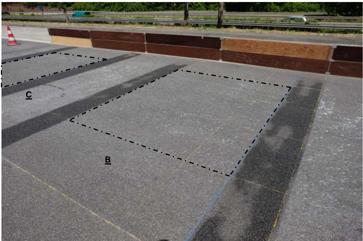
Bild 13: Blick auf die Messfelder B und C, Überfahrt 2;
