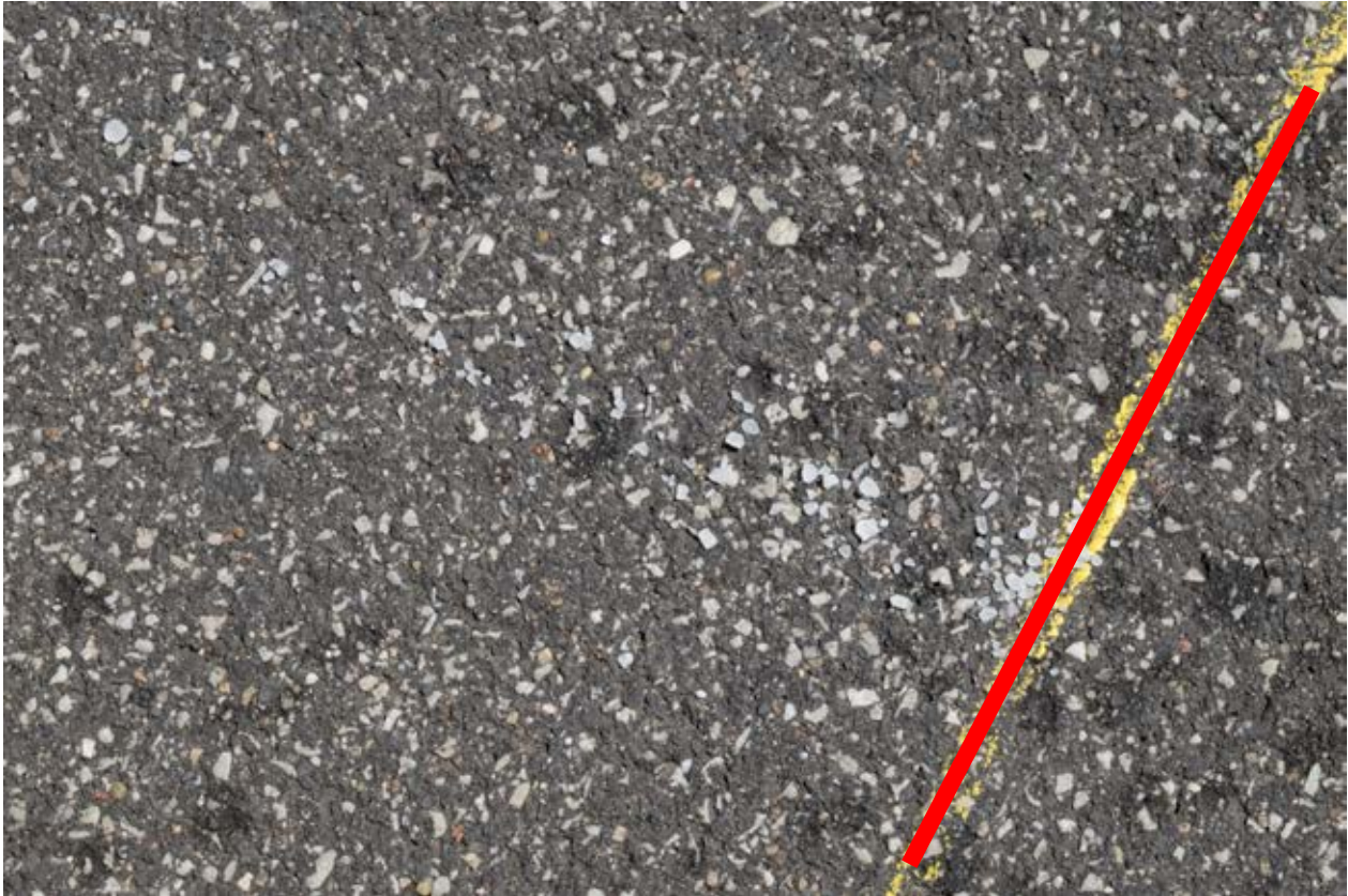
Bild 20: Salzansammlung im Bereich der Begrenzungswand (Standort = rot dargestellt)
