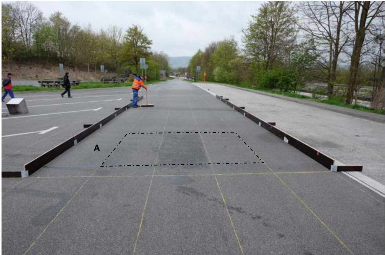
Bild 17: Blick auf das Prüffeld A, Überfahrt 2
