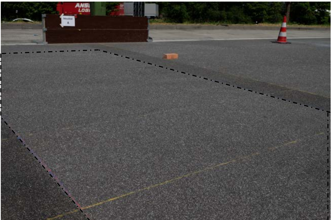
Bild 19: Blick auf Messfeld A, Überfahrt 1 zeigt die Art und Weise der Soleverteilung
