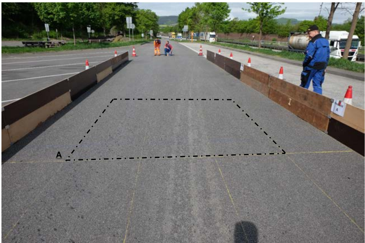
Bild 7: Blick auf das Prüffeld nach der ersten Überfahrt; im Vordergrund ist Messfeld A zu sehen
