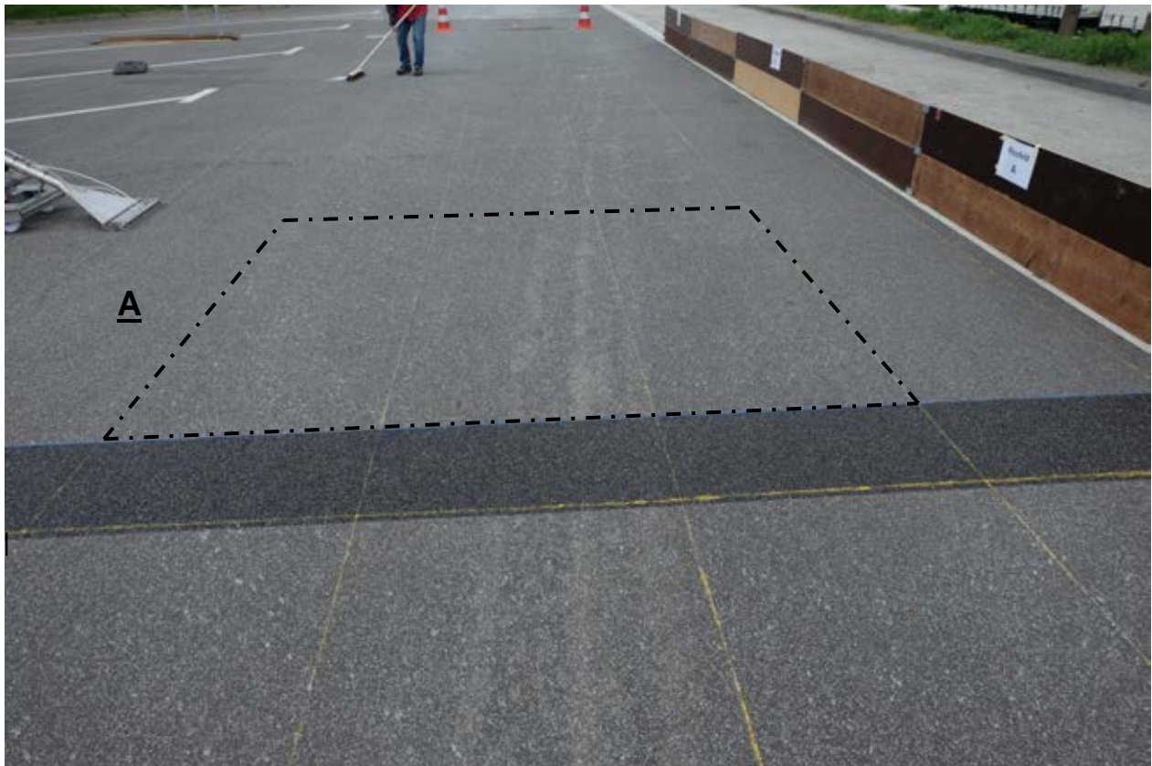
Bild 8: Blick auf das Messfeld A, Überfahrt 1
