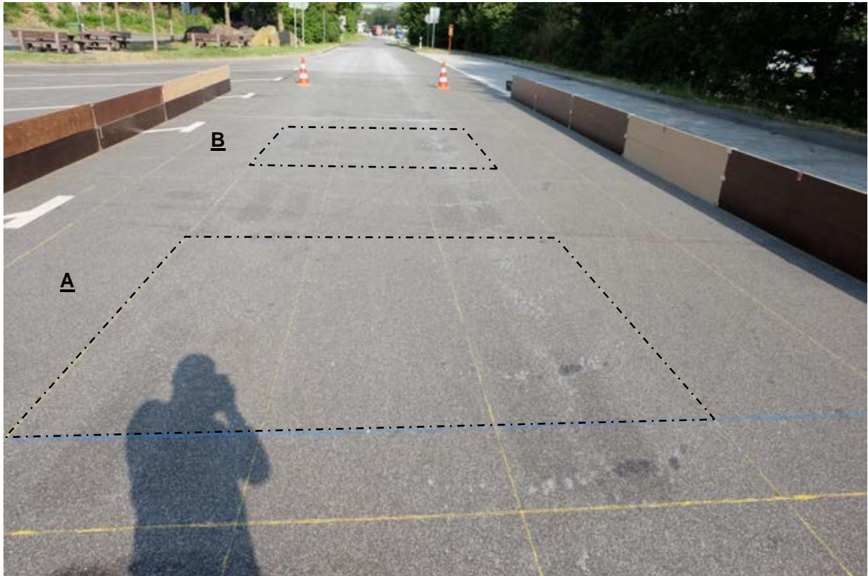
Bild 16: Blick auf Prüffeld A und B, Überfahrt 2
