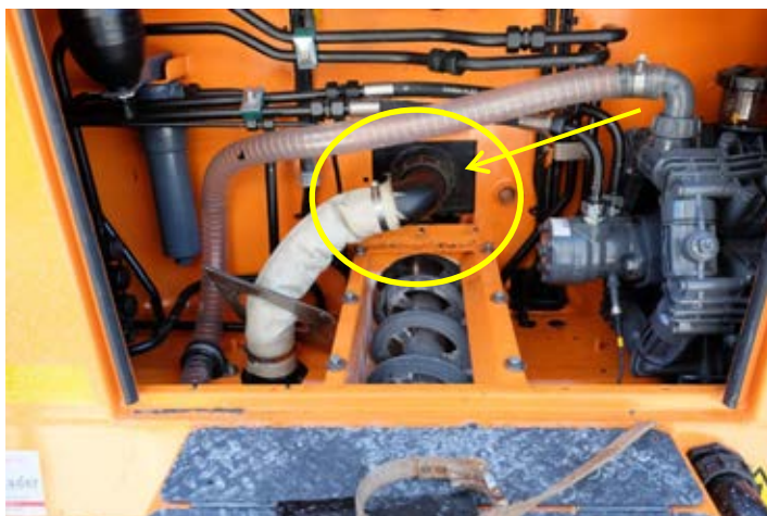
Bild 9: Blick auf den defekten Soleanschluss, aus dem Sole in die Schnecke entwich
