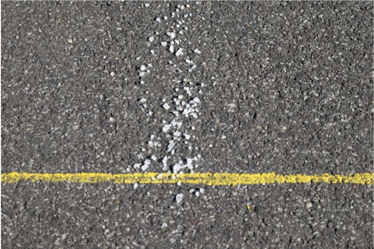
Bild 21: Blick auf entmischtes Salz bei 5,5m links
