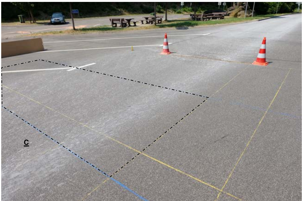
Bild 26: Blick auf das Prüffeld C, Überfahrt 1
