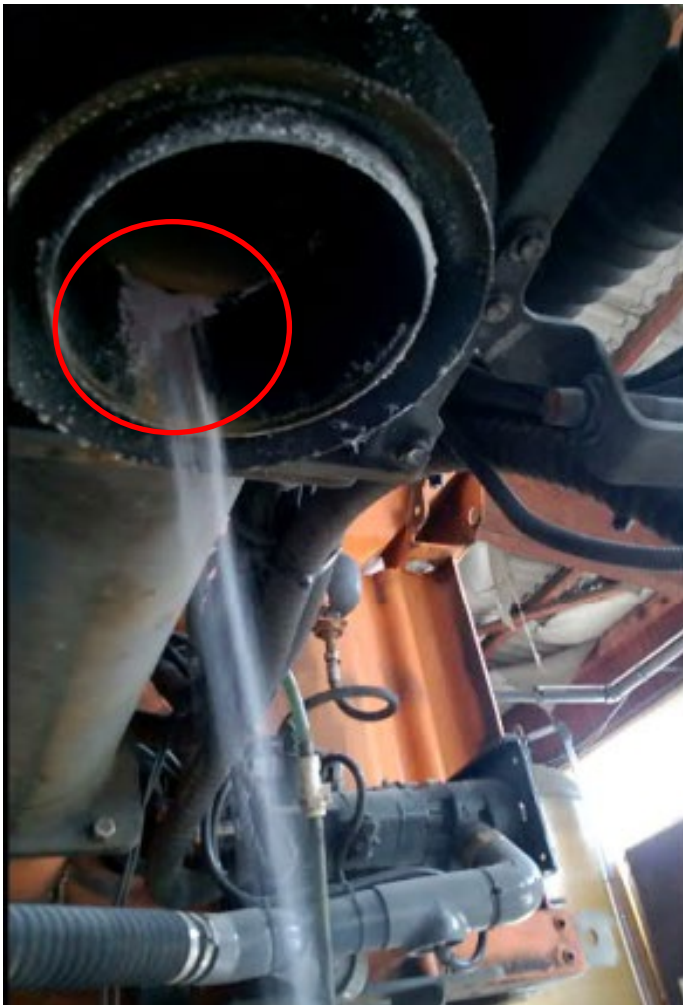
Bild 28: Blick auf das Ende der Förderschnecke
