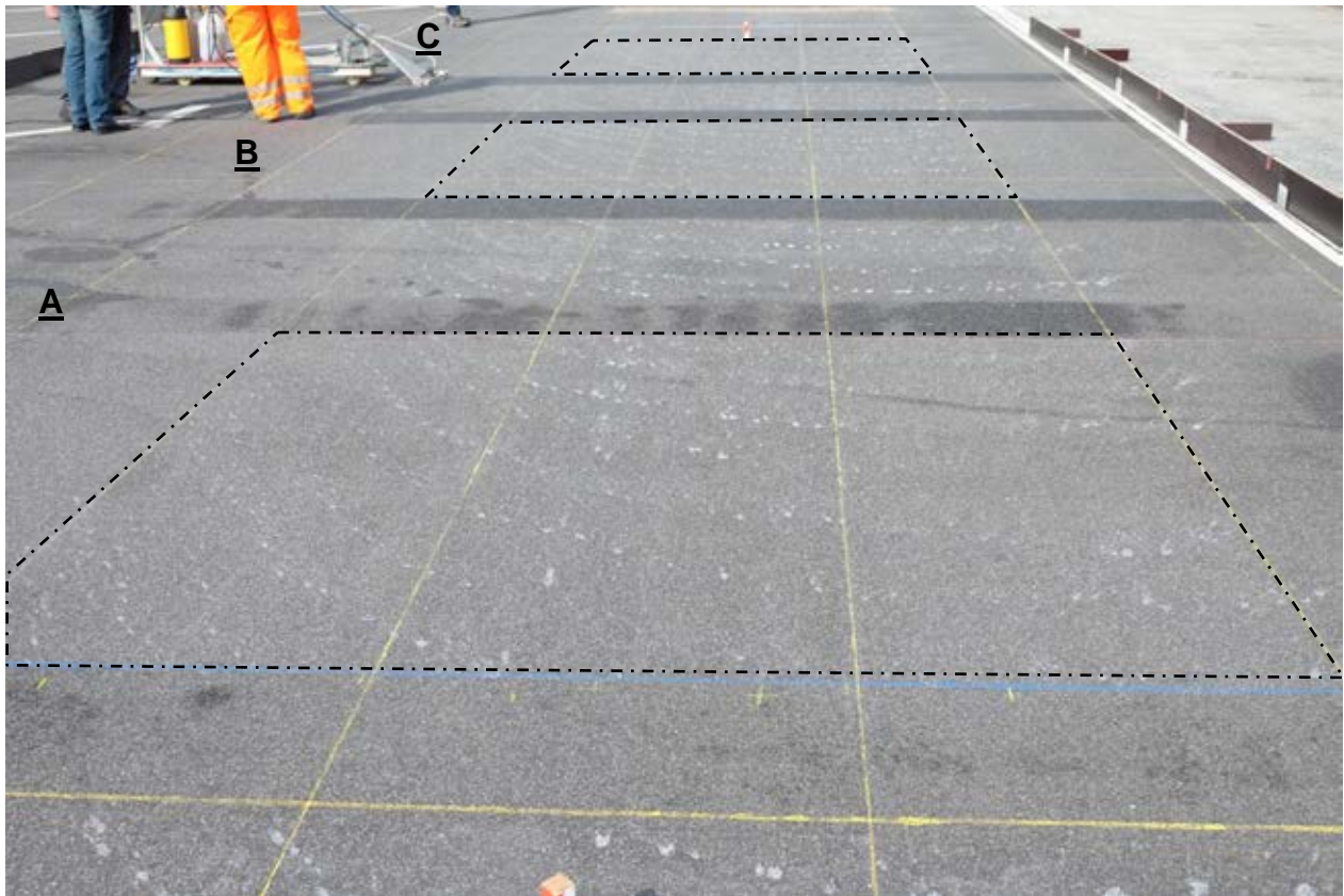
Bild 12: Blick auf das Prüffeld nach der ersten Überfahrt mit den Messfeldern A, B und C
