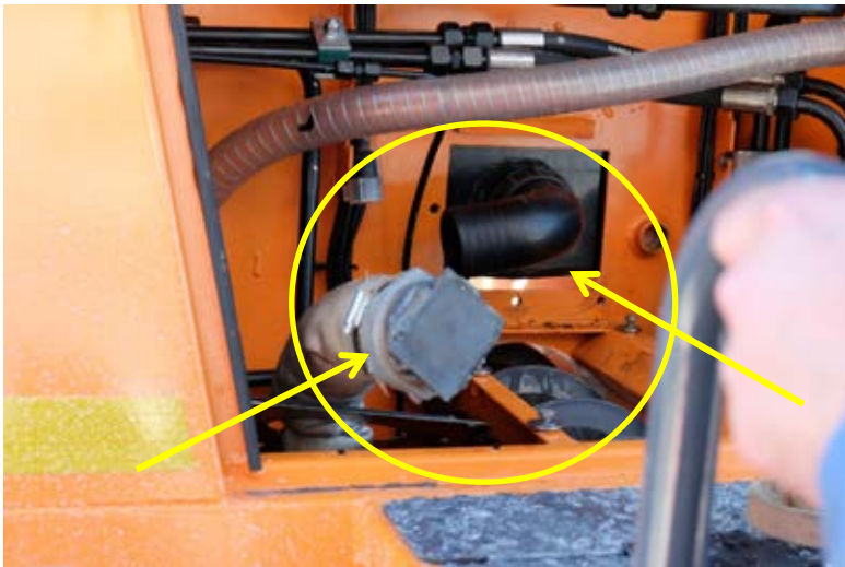
Bild 11: Blick auf die entkoppelte Zuleitung (rechts) und den angebrachten Verschluss (links)
