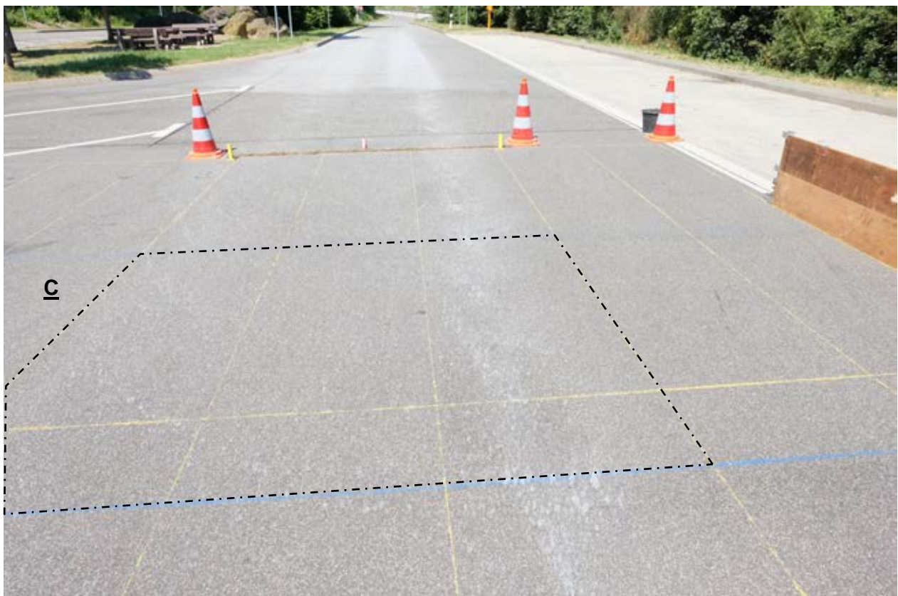
Bild 15: Blick auf das Prüffeld C, Überfahrt 1
