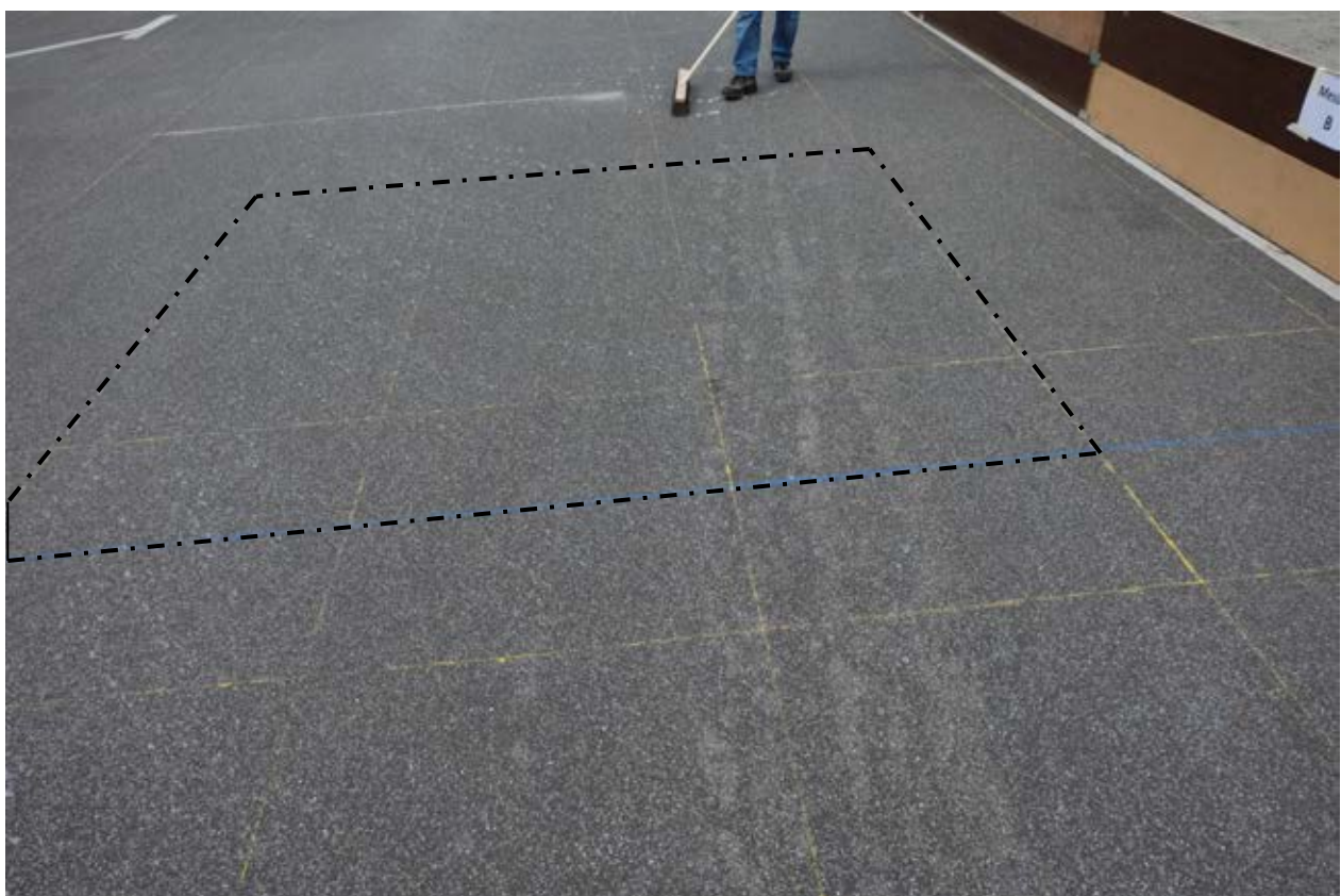
Bild 9: Blick auf das Messfeld B, Überfahrt 1
