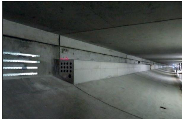
**Bild 7:** Vorbereitung zur Umverlegung der Kabel in die Zu- und Abluftkanäle
