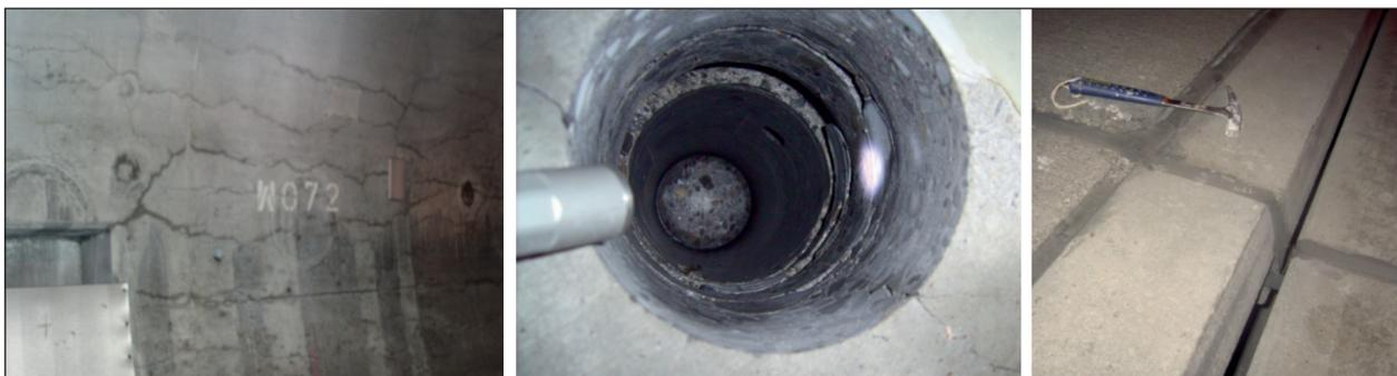
Bild 2: Schadensbilder, Risse in den Ulmen, Schalenparallele Risse, Verformung der Fahrbahn
