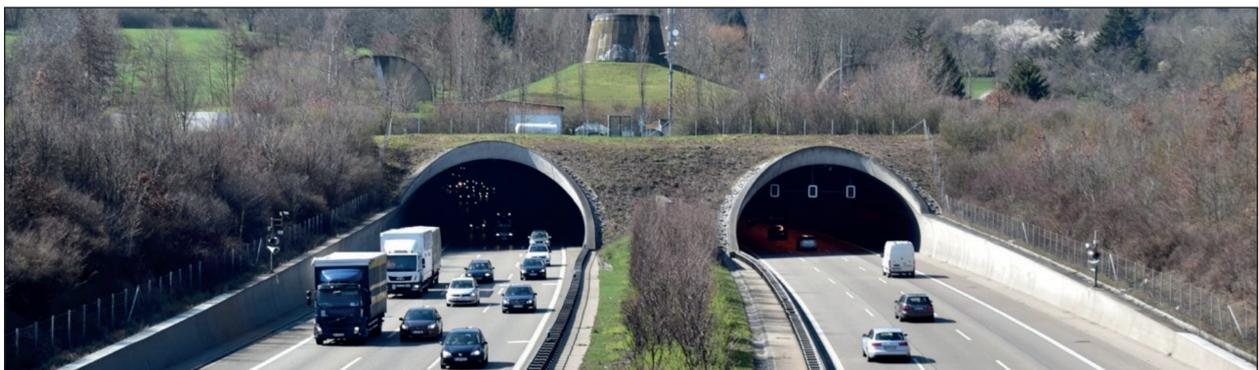
Bild 1: Nordportal Engelbergbasistunnel mit Zu- und Abluftbauwerk im Hintergrund
