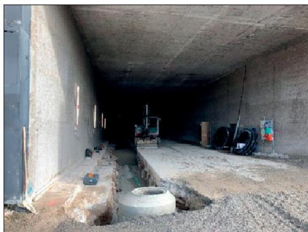
**Bild 8:** Erdarbeiten in der Südröhre
