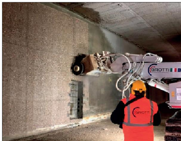
**Bild 7:** Schrämmarbeiten in der Südröhre
