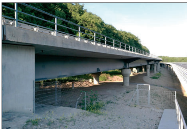
Bild 3: Hangbrücke Würgau Stahlverbund
