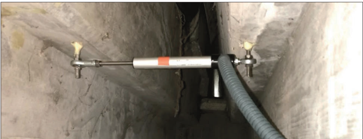
Bild 17: Wegaufnehmer montiert (Paradiestabbrücke)
