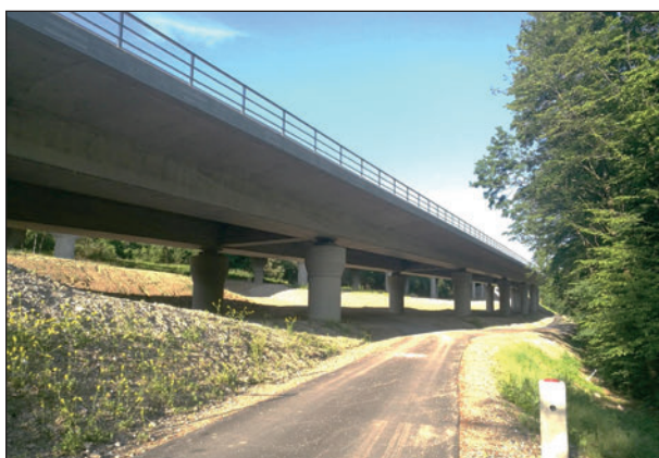
Bild 2: Hangbrücke Würgau Beton
