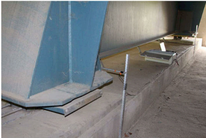
Widerlagerbereich Hangbrücke Würgau Stahlverbund
