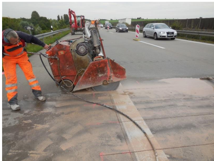
Zuschnitt der Balkensegmente
