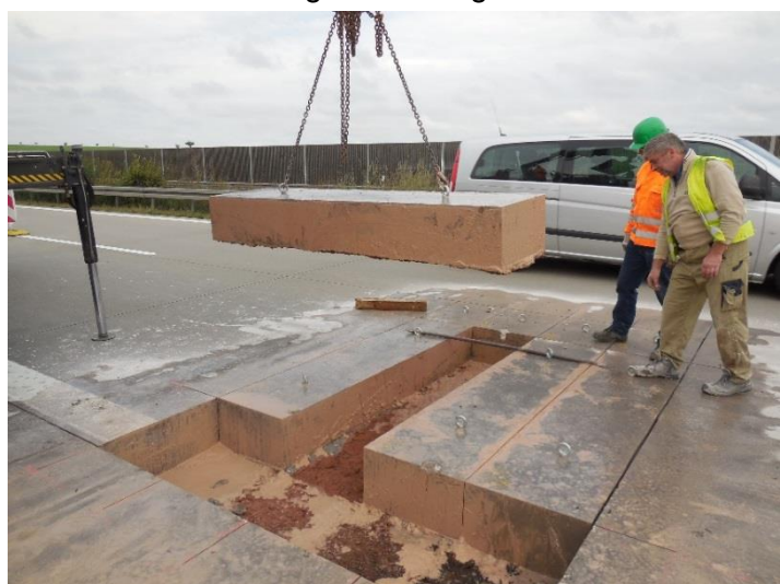
Entnahme der Balkensegmente
