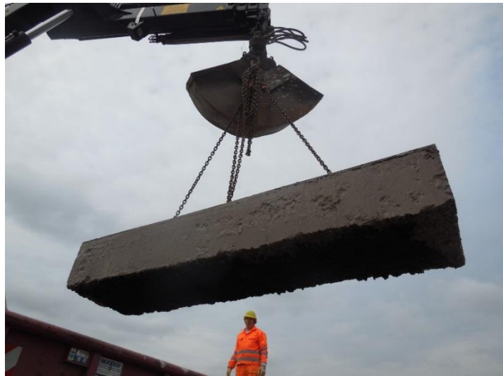
Verladen der Balkensegmente
