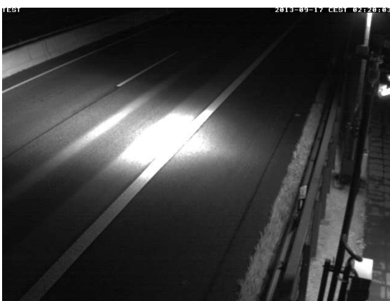
Bild 38: Aufnahme bei Dunkelheit, ein partielles Abtrocknen in den Rollspuren auf dem rechten Fahrstreifen ist erkennbar
