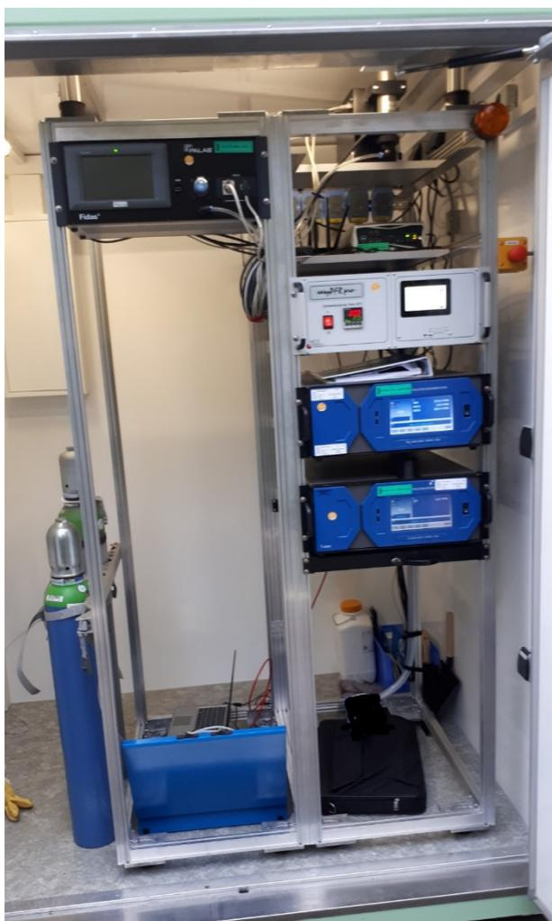
Abbildung 8: Messstation A4\_OI\_1 an der BAB A4 in Fahrtrichtung Olpe – Innenansicht des neuen Messcontainers. Messparameter: NO<sub>x</sub>, PM<sub>x</sub>, Partikelanzahl, O<sub>3</sub>, p, rh und T.
