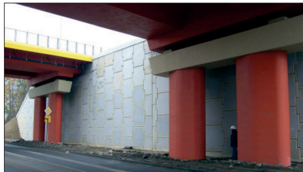
Bild 3-11: Kombiniertes Widerlager mit innenliegenden Pfeilern [53]
