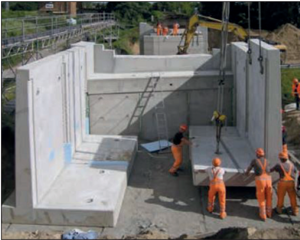
Bild 3-2: Montage der Flügel [53]
