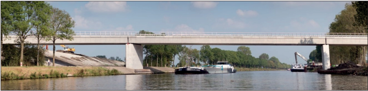
Bild 3-42: Haitsma Hohlprofil, Mehrfeldbauwerk [49]
