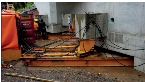
Bild 4-1: EÜ km 32,541; Strecke 5230, Ausführung [45]
