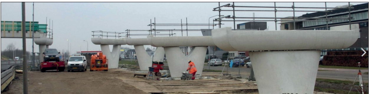
Bild 3-33: Unterbau aus vorgefertigten Betonelementen [50]
