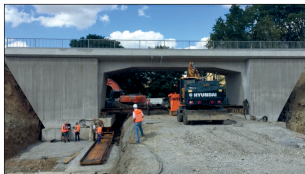
Bild 4-3: Einschub EÜ km 12,087, Strecke 5230 [46]
