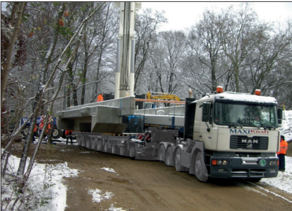
Bild 4-14: EÜ km 209,002 Görlitz, Einbauvorgang, 2008 [51]
