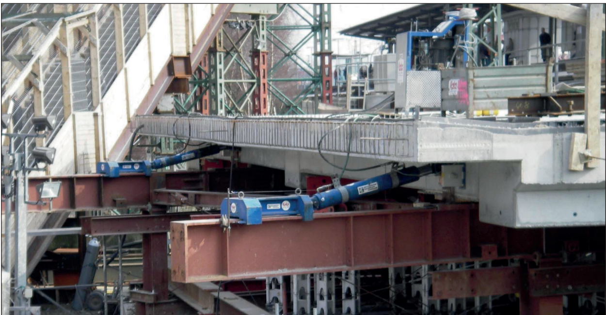
Bild 4-11: EÜ Reichsbahnstr. in Hamburg Eidelstedt, Verschub eines WIB-DLT-Überbaus (600 t) [43]
