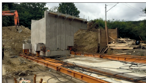
Bild 4-4: Einschub EÜ km 12,925, Strecke 5230 [46]
