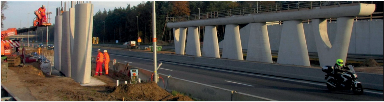
Bild 3-32: Unterbau aus vorgefertigten Betonelementen [50]
