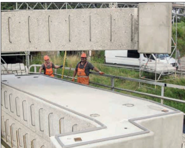
Bild 3-3: Montage eines Schachtelements [53]
