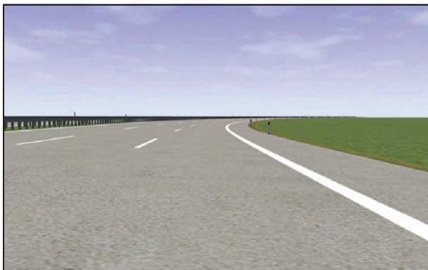
Bild 94: Kurze Zwischengerade mit RQ 36, R = 500 m, L_R = 55 m, Länge der Zwischengerade: 100 m
