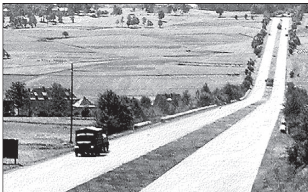
Bild 7: Knickwirkung im Höhenplan (LORENZ, 1971)
