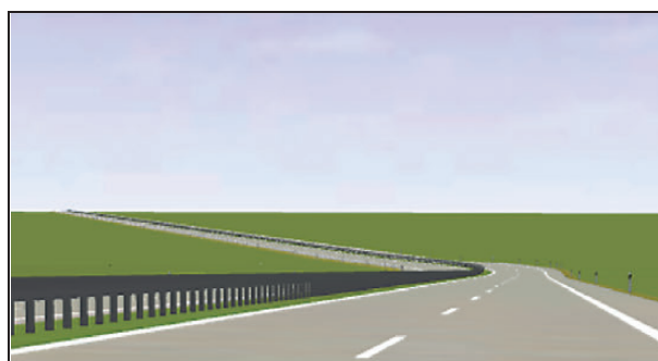
Bild 84: Linkskurve in der Wanne mit durchgängiger Querneigung von q = 2,5 \% , R = 280 \text{ m} , A = 93,33 \text{ m} , RQ 25, \Delta s = 4 \% , H_W = 1.667 \text{ m} ( T = 100 \text{ m} )
