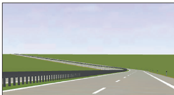
Bild 85: Linkskurve in der Wanne mit negativer Querneigung von q = -6,0 \% , R = 280 \text{ m} , A = 93,33 \text{ m} , RQ 25, \Delta s = 4 \% , H_W = 1.667 \text{ m} ( T = 100 \text{ m} )
