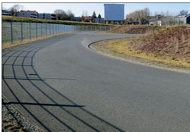
Bild 20: Teststrecke auf der die Aufnahmen durchgeführt wurden
