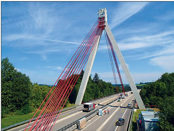
Bild 8: Talbrücke Oberer Argen (Teil mit oberhalb der Fahrbahn liegenden Seilen)
