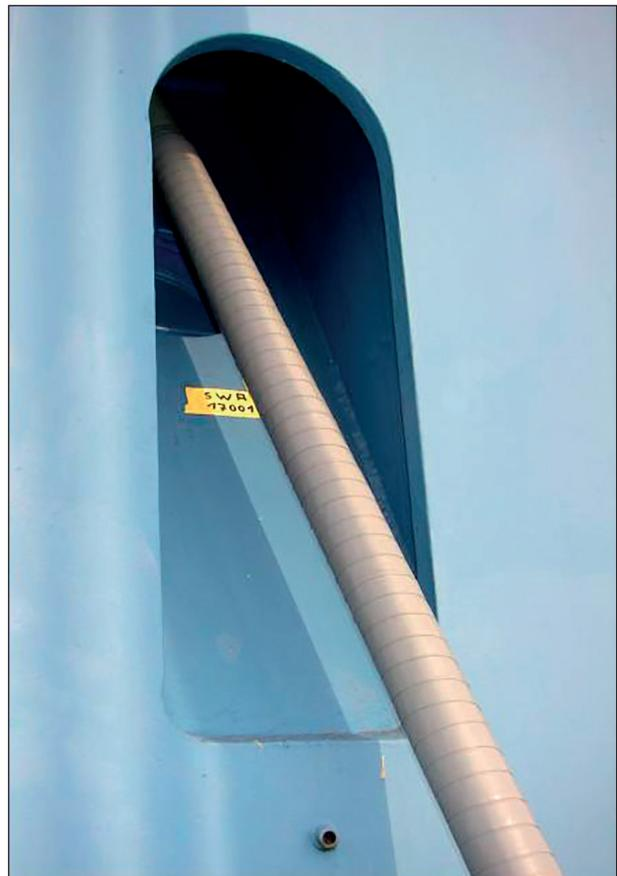
Bild 5: Anschluss an die Verankerung am Pylon (Köhlbrandbrücke) [3]
