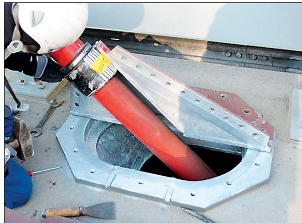
Bild 10: Montage von Seilhaube und Dämpfer [4]
