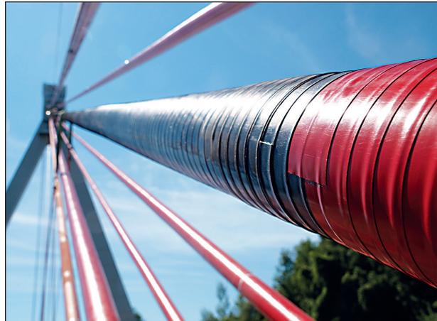
Bild 9: Die Umwicklung mit der roten Decklage erfolgt auf die schwarze Basislage
