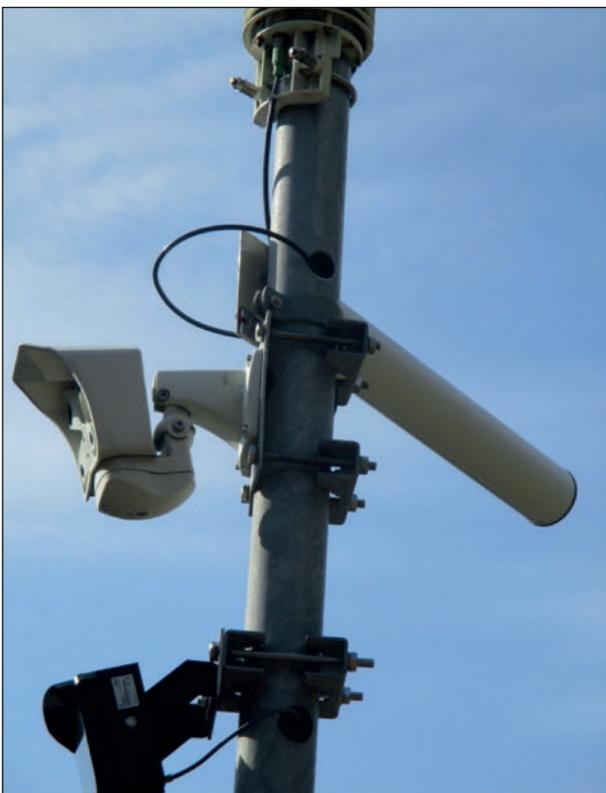
Bild 23: Installierte Antenne für Mobilfunk an der Station Predigtstuhl (Foto: Jimmy Latimer, micKS)
