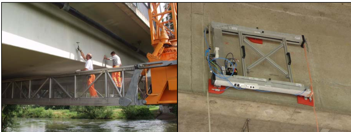
Abb. 2 visuelle Bauwerksprüfung und Brückenscanner
