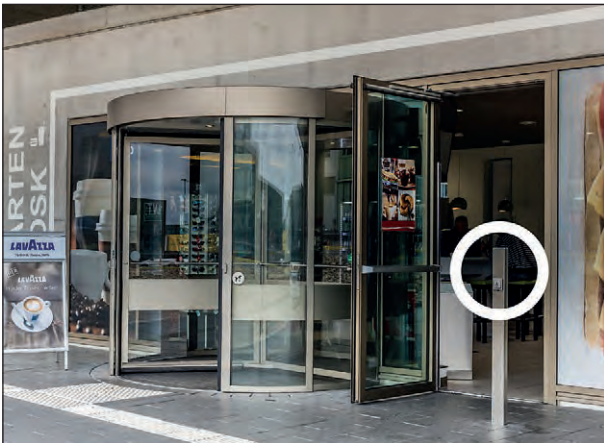
Bild 88: Zugang zu einem Wartebereich mit separater Tür für Rollstuhlfahrer (rechts) und Anforderungstaster – Beispiel Stuttgart (Foto: SAB)
