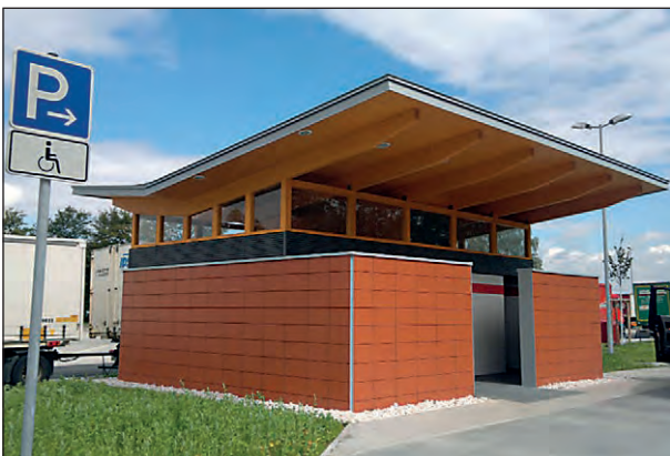
Bild 94: Barrierefrei zugängliches WC auf einer Rastanlage in unmittelbarer Nähe eines Behindertenparkplatzes (Foto: Hering Sanikonzept GmbH)
