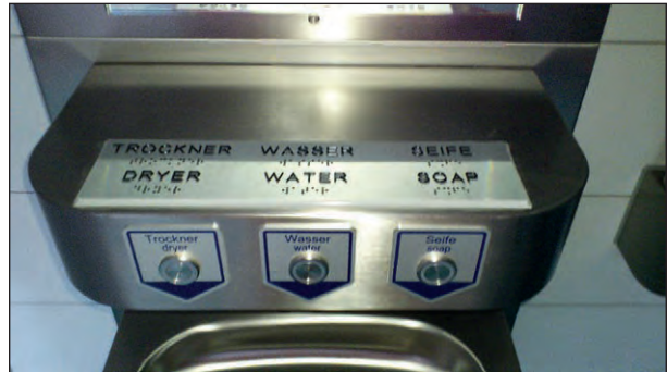
Bild 95: Taktil erastbare und visuell kontrastierende Beschriftung von Bedienelementen (Foto: Hering Sanikonzept GmbH)
