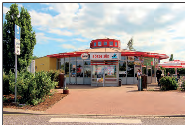
Bild 106: Überquerungsstelle mit abgesenktem Bord (einheitliche Bordhöhe) an einer Rastanlage (Quelle: Tank & Rast)
