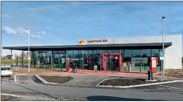
Bild 107: Barrierefrei zugängliche Raststätte (Quelle: Tank & Rast)
