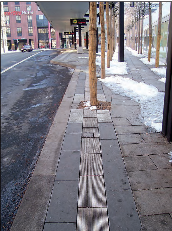
Bild 112: Planungsfehler (Baum im Leitsystem) an einem Busbahnhof
