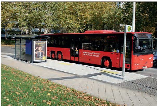
Bild 60: Barrierefreie Bushaltestelle mit Bodenindikatoren (Auffindestreifen) und Wetterschutz (Quelle: Kasseler Verkehrs-Gesellschaft AG)
