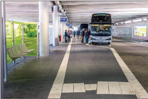
Bild 72: Einstiegsfeld (rechts) mit Anbindung an ein Bodenindikator-basiertes Leitsystem – Beispiel ZOB Stuttgart (Quelle: SAB) 54
