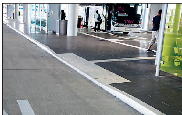
Bild 77: Überquerungsstelle mit einheitlicher Bordhöhe und Richtungsfeld – Beispiel ZOB Stuttgart (© Foto: Helena Kunz)
