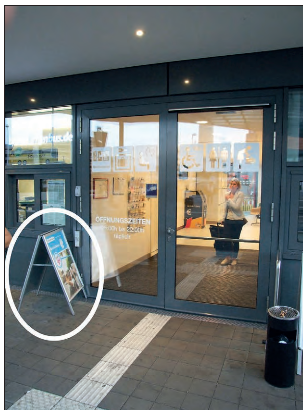
Bild 108: „Kundenstopper“ vor dem Anforderungstaster zum Öffnen der automatischen Tür am Zugang zum Wartebereich
