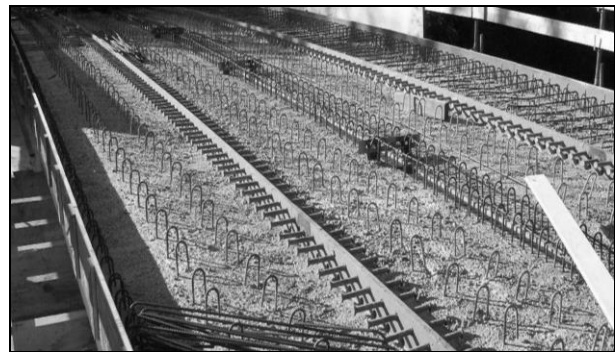
Bild 1-2: Randnahe Kopfbolzen in einem Querschnitt bei einer Wirtschaftswegebrücke über die Bundesstraße B465 bei Münsingen
