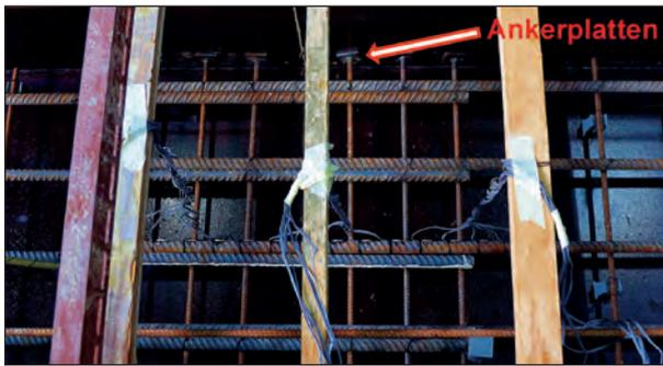
Bild 28: Verankerung der Querbewehrung im Stoßbereich (B3)
