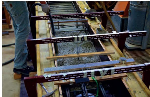
Bild 38: Betonage des Trägers B1
