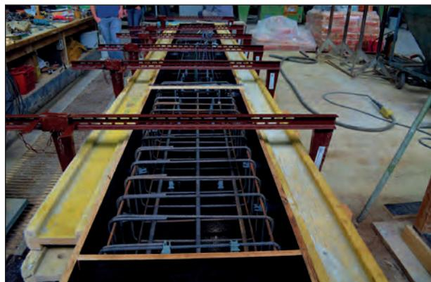
Bild 39: Schalung und Bewehrungskorb Träger B1 (die Biegebewehrung liegt bei der Betonage unten)
