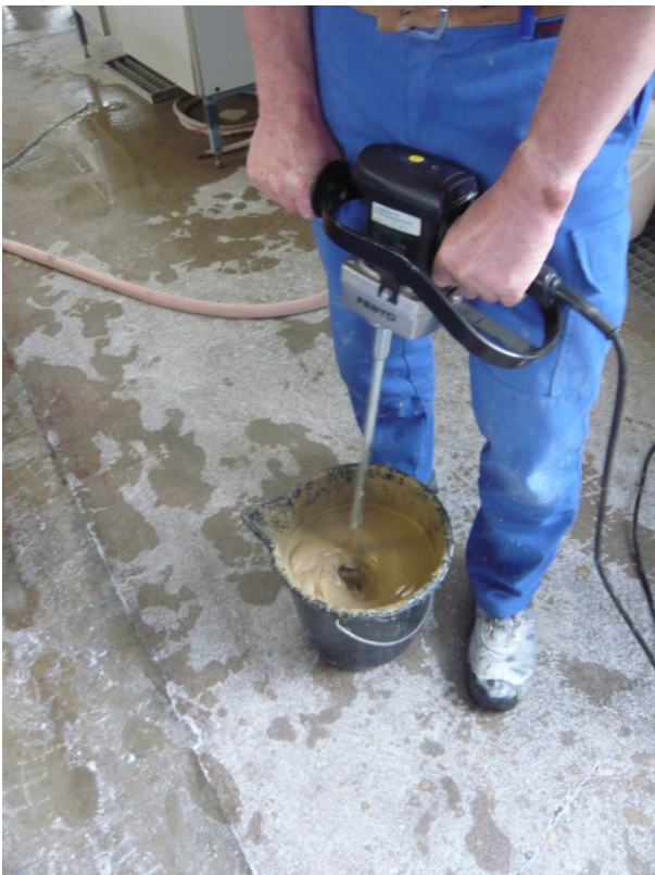
Anrühren einer pumpfähigen Suspension mit definiertem Wassergehalt
