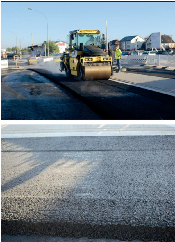
Bild 55: Einbaubilder – AC 16 B S
