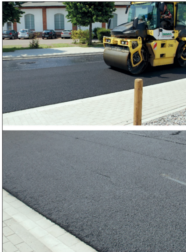
Bild 57: Einbaubilder – AC 5 D S LA
