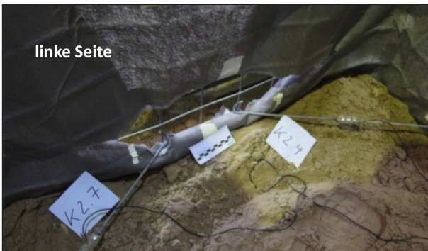
Bild 4–109: Versuch 2, Aufgebogene Haken von K2.4 und K2.7 an der linken Seite der Gabione
