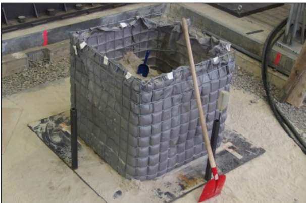
Bild 4–14: Versuch 0, Gabione nach Abbau der Stahlrahmenschalung, Frontseite im Bild oben rechts
