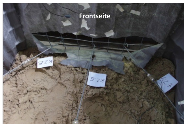
Bild 4–107: Versuch 2, Aufgebogene Distanzhalter in Höhe 0,3 m an der Frontseite der Gabione
