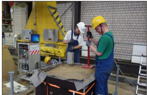
Bild 4–70: Versuch 2, Verdichtung der Füllung
