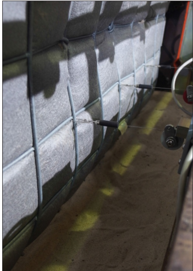
Bild 4–84: Versuch 2, Laststufe 210 kN, Ausbauchungen im unteren Drittel des Frontgitters
