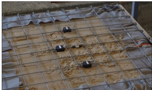
Bild 4–31: Versuch 1, Befüllte Gabione mit Deckelgitter
