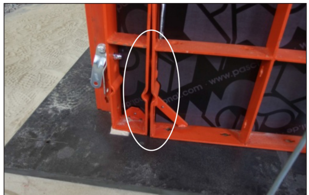
Bild 4–11: Versuch 0, Aufspreizen der Schalungselemente auf der Rückseite (nach Versuchsende)
