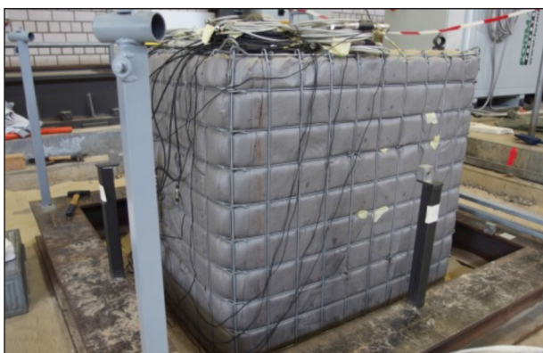
Bild 4-93: Versuch 2, Westseite der Gabione nach dem Abbau der Stahlrahmenschalung (Rückseite im Bild links)
